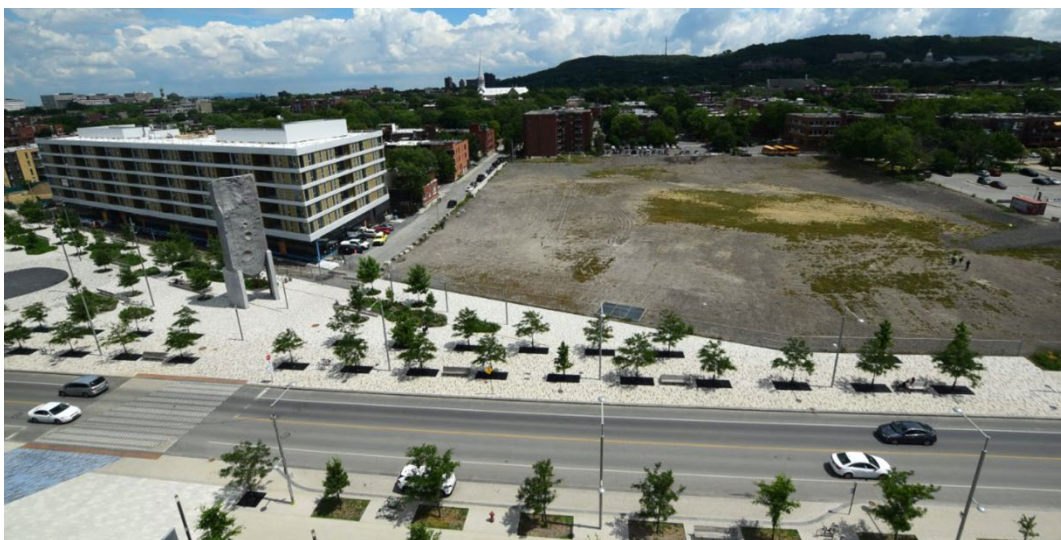
Figure 8 – Vue aérienne des terrains vacants visés pour la construction de l'école primaire et du parc de quartier P-3
