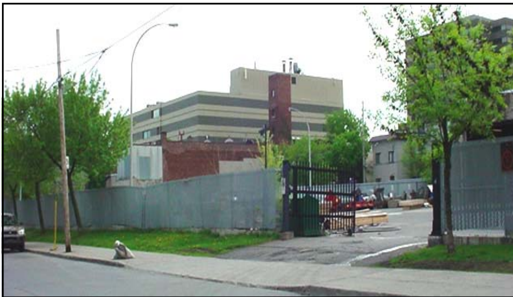
Figure 1 Photo montrant en avant plan une partie de la cour de voirie située à l'angle des rues Marie-Anne et Coloniale et en arrière plan l'édifice de l'entreprise Paris Star , locataire principal du stationnement municipal (document déposé no 5, diapositive no 21).
