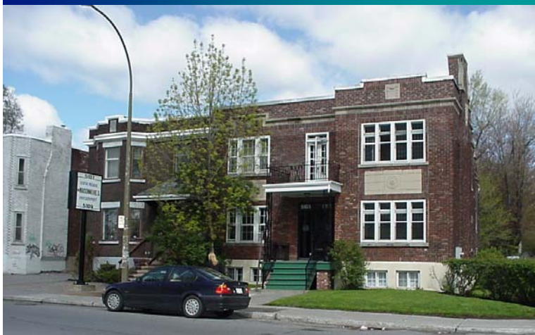
Figure 2 : Bâtiments devant être démolis
