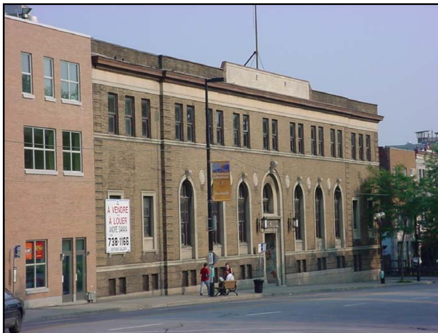
Figure 2 Immeuble « Sir Mortimer B. Davis » situé sur l'avenue du Mont-Royal et faisant l'objet d'un projet de conversion à des fins d'habitation (extrait du document 3.6).
