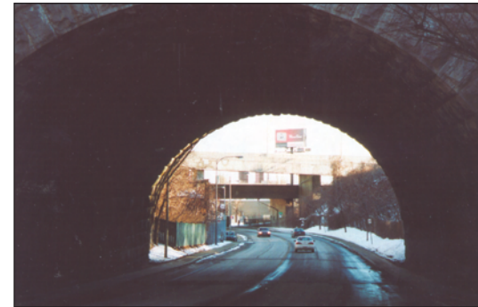
7 Du tunnel vers le sud
