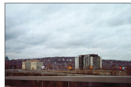
6 Vue du site à partir de l'autoroute 720
