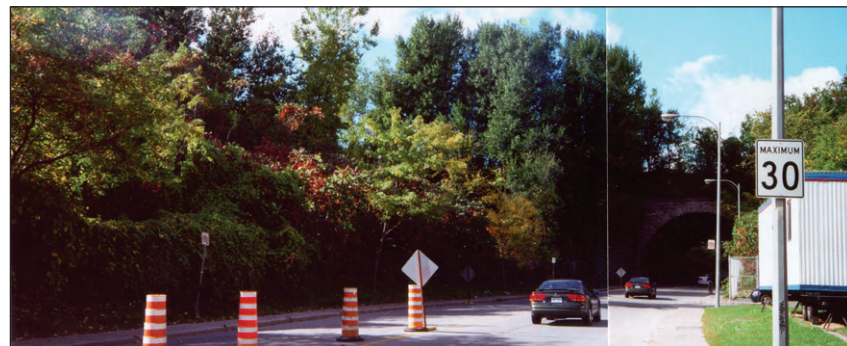
3 L'entrée sud du tunnel Glen
