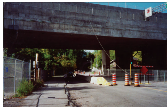
4 L'approche sud du tunnel sur le chemin Glen
