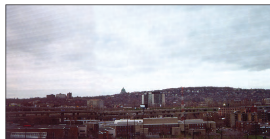
5 Vue du site à partir de l'autoroute 15
