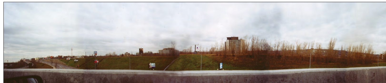
3 Vue du site à partir de l'autoroute 720
