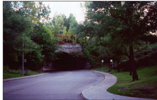
2 L'entrée nord du tunnel
