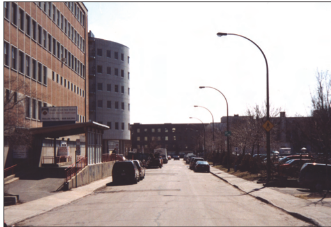
1 Avenue Northcliffe - vue axiale sur l'immeuble de la Place Vendôme
