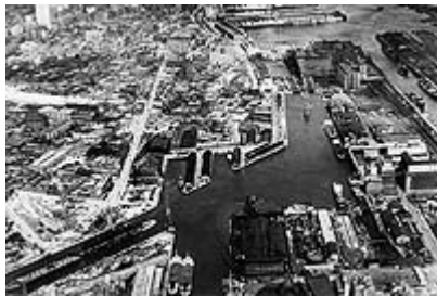
L'entrée du canal de Lachine, en 1931. Archives nationales du Canada
