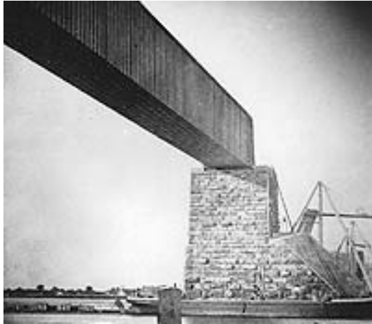
Le pont Victoria en construction, en 1859 Centre tube and no. 13 pier, Victoria Bridge, Montreal, QC, 1859, photographe : William Notman. Archives photographiques Notman, Musée McCord d'histoire canadienne, Montréal. VIEW-7013.0
