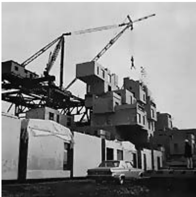
Habitat 67 en construction. Bâtiment , juin 1967
