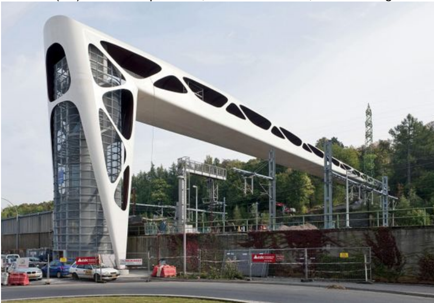
Source : (s.d) Passerelle piétonne, Esch-sur-Alzette, Luxembourg.
