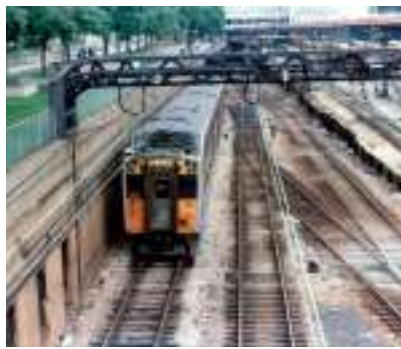
Avant, des voies ferrées
