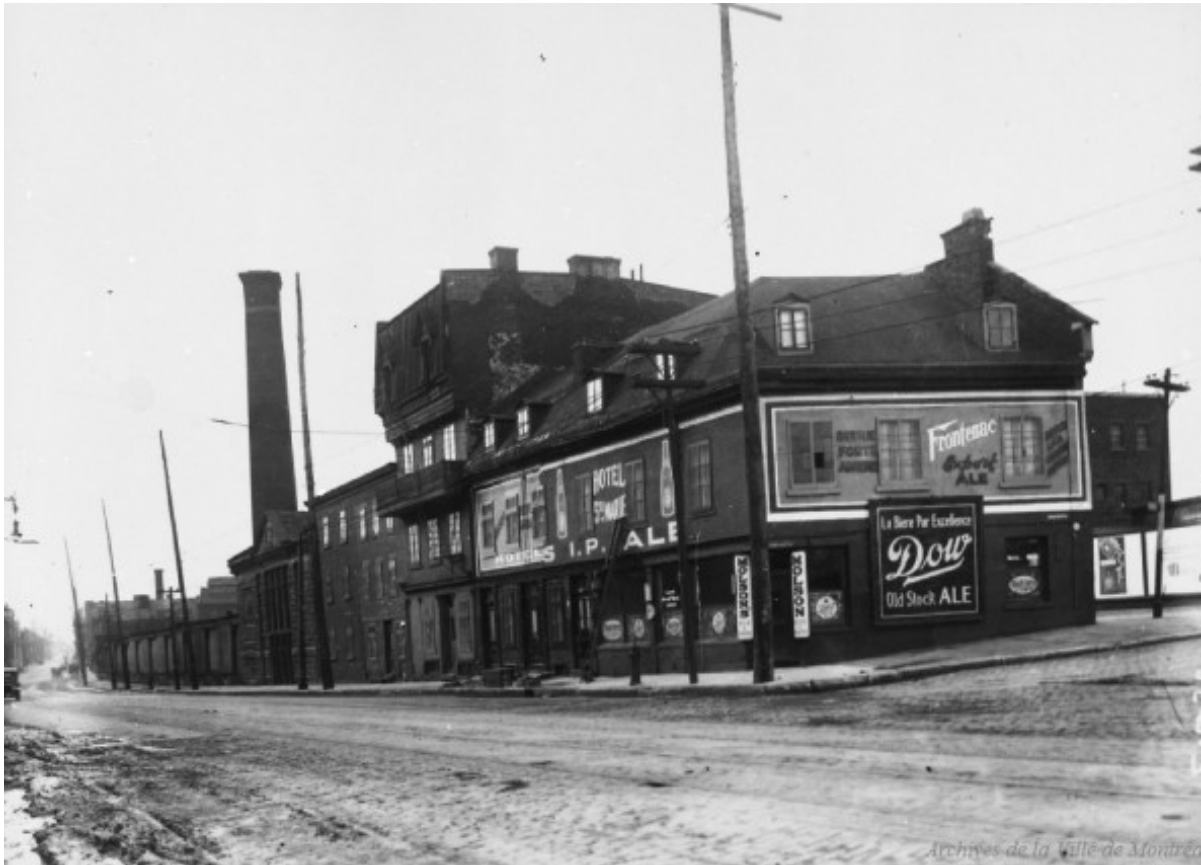
La station de pompage Craig était originellement entourée de bâtiments de chaque côté. Source Archives VDM
