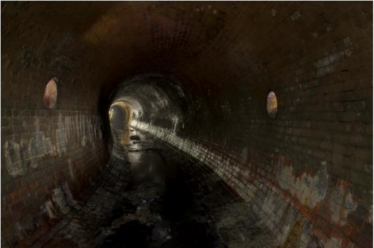
Vue générale du tunnel de l'égout Craig, reconstruit entre 1876 et 1878.
