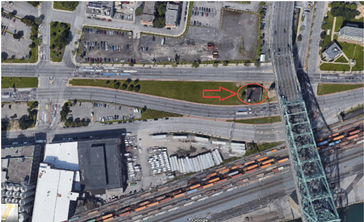
La station de pompage Craig, enclavée entre deux voies d'autoroute. Source : Google Maps
