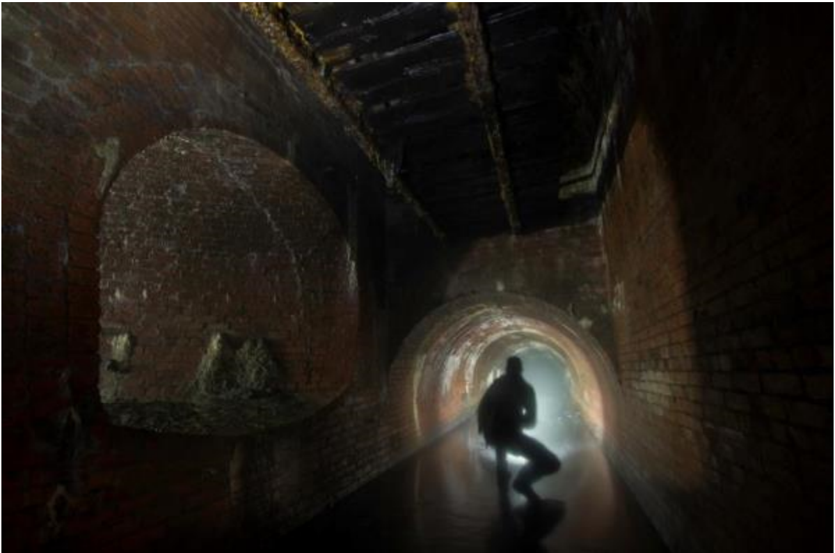
Chambre de dérivation vers les pompes; à gauche, un des canaux d'aspiration.
