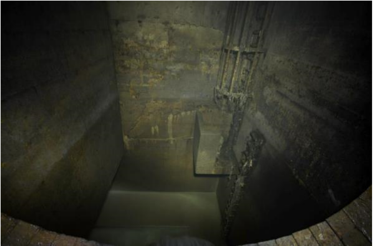
Structure de chute et dérivation vers le collecteur Lafontaine.
