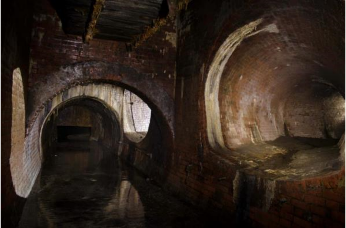
Chambre de dérivation vers les pompes; en arrière-plan, l'écluse qui servait à obturer l'égout.
