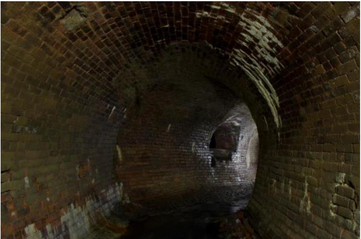
Courbe du tunnel avec, en arrière-plan, le trop-plein vers le collecteur Colborne.
