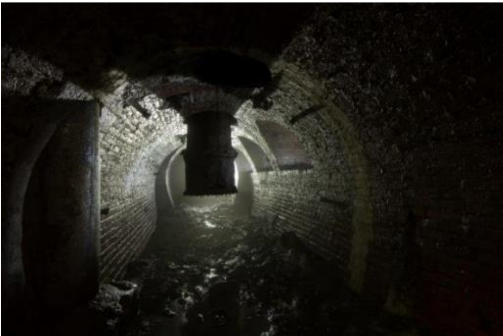
Canal d'aspiration des pompes; à droite, les égaliseurs reliés à un autre canal identique à celui-ci.
