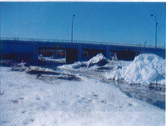
PICT0017.JPG, viaduc Sainte-Catherine, embranchement sud
