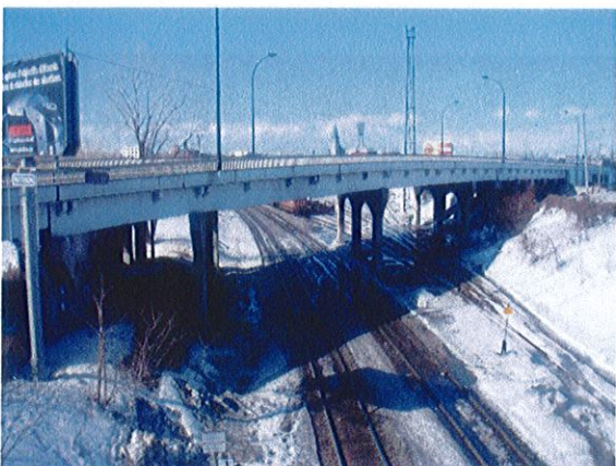
PICT0015.JPG La boucle d'accès, viaduc Sainte-Catherine
