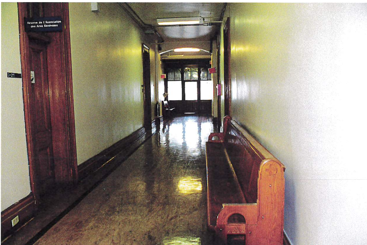
Figure 13 : Pavillon D, cette photographie montre l'état actuel du corridor situé au premier étage. (Caroline Tanguay, juin 2002)
