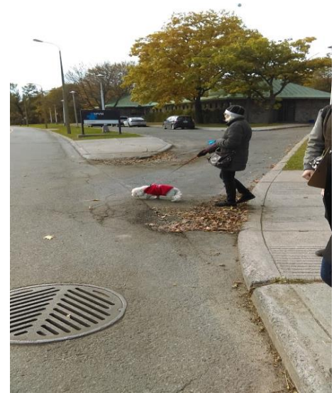
Photo 3: Absence de bateau-pavé et de traverse piétonne
