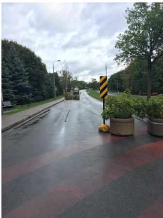
Photo 6: Chicane avec végétation obstruant la vue
