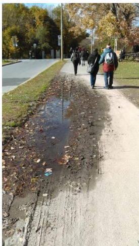
Photo 11: Zone inondée sur trottoir
