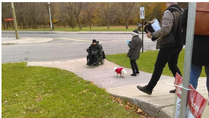
Photo 13: Pente très accentuée entre les voies Camillien-Houde et Remembrance
