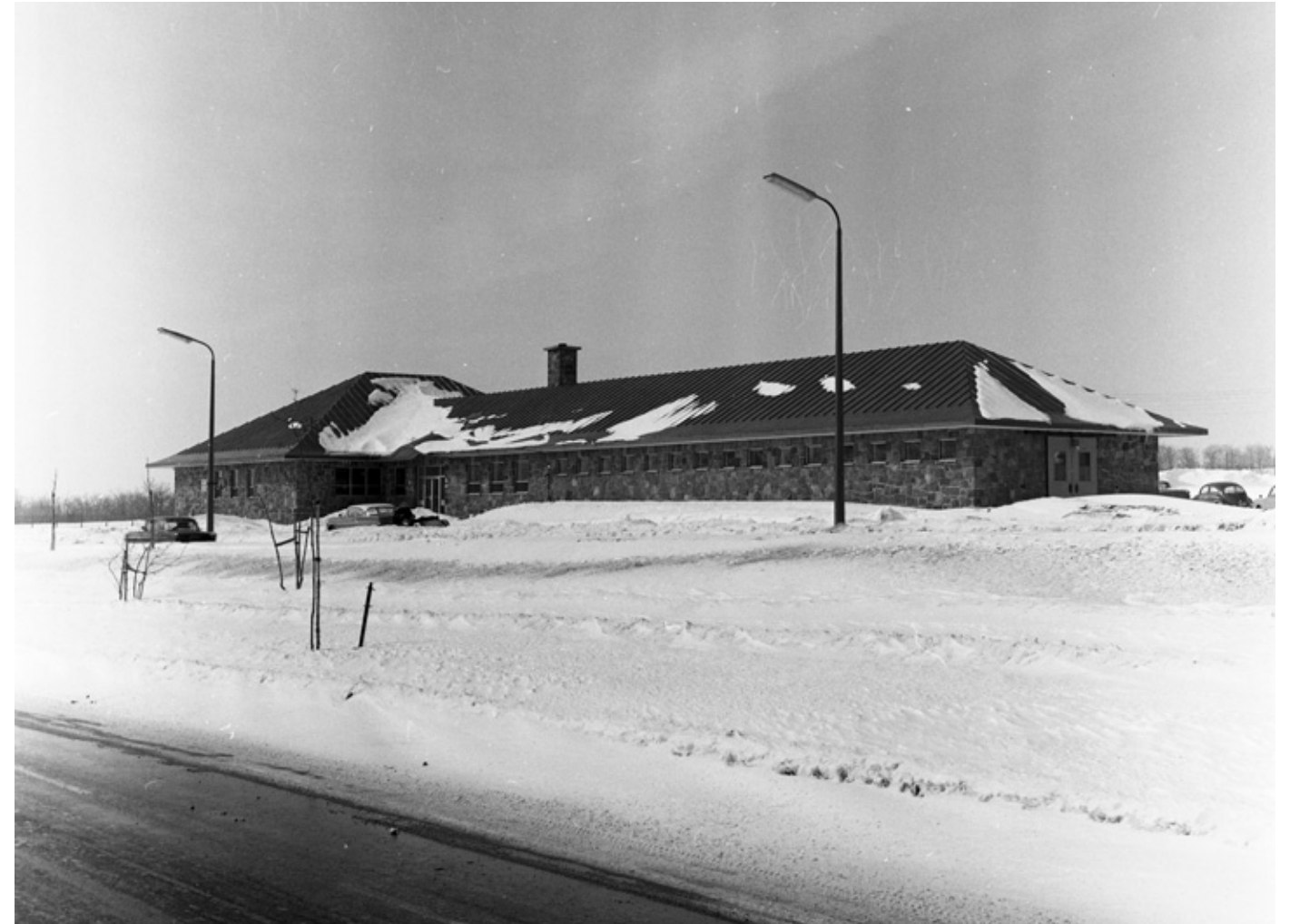
9 Le 15 février 1962. Le poste de police et l'écurie terminée. AVM. VM105-Y-3-632-08.
