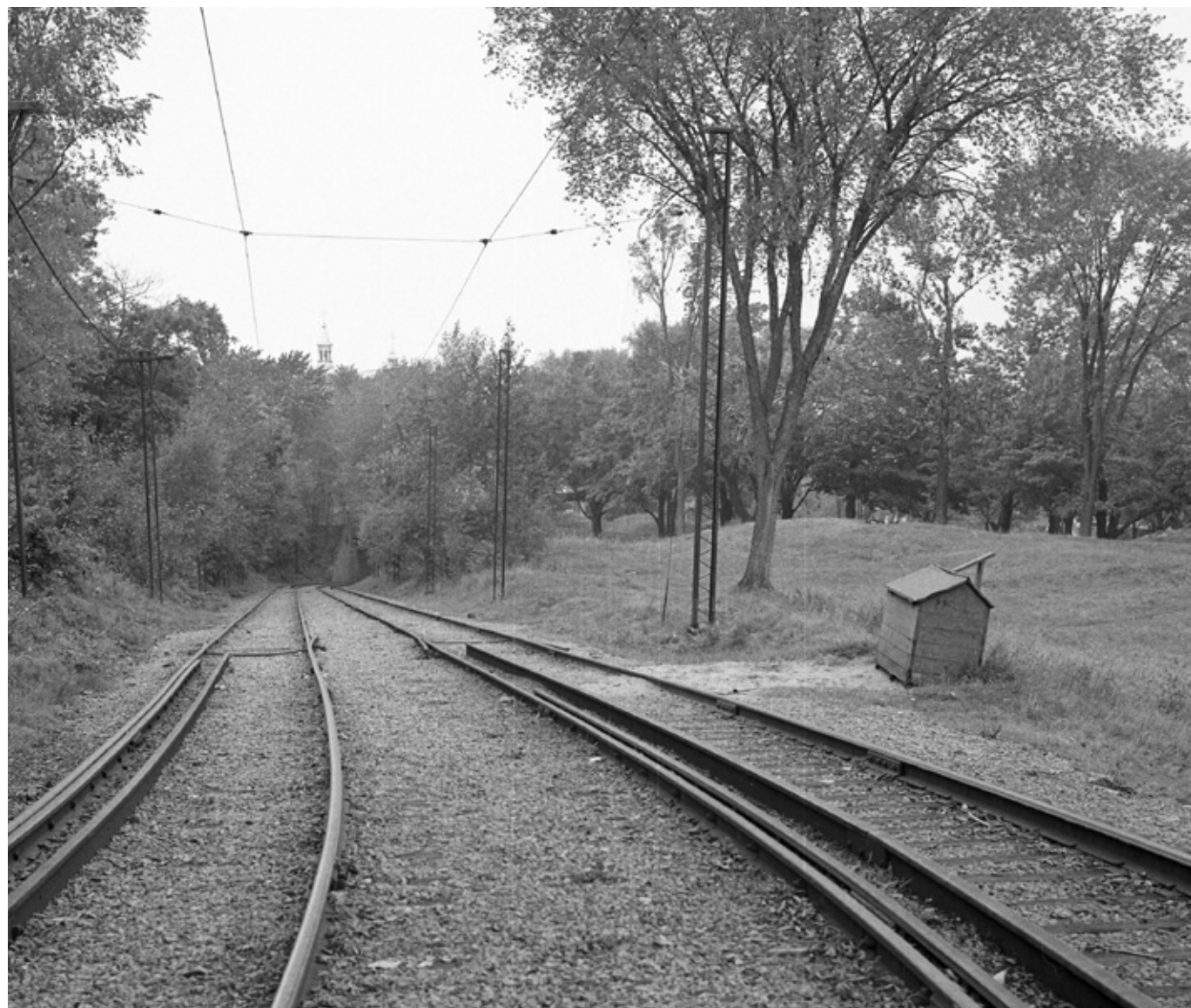
19 Début des années 1950. À droite des rails, une boîte de bois sert à entreposer le sable. On peut remarquer une trainée de sable entre la boîte et les rails. Au bout des rails, on entrevoit le viaduc situé à proximité du boulevard du Mont-Royal. AVM.VM94-U0739-016
