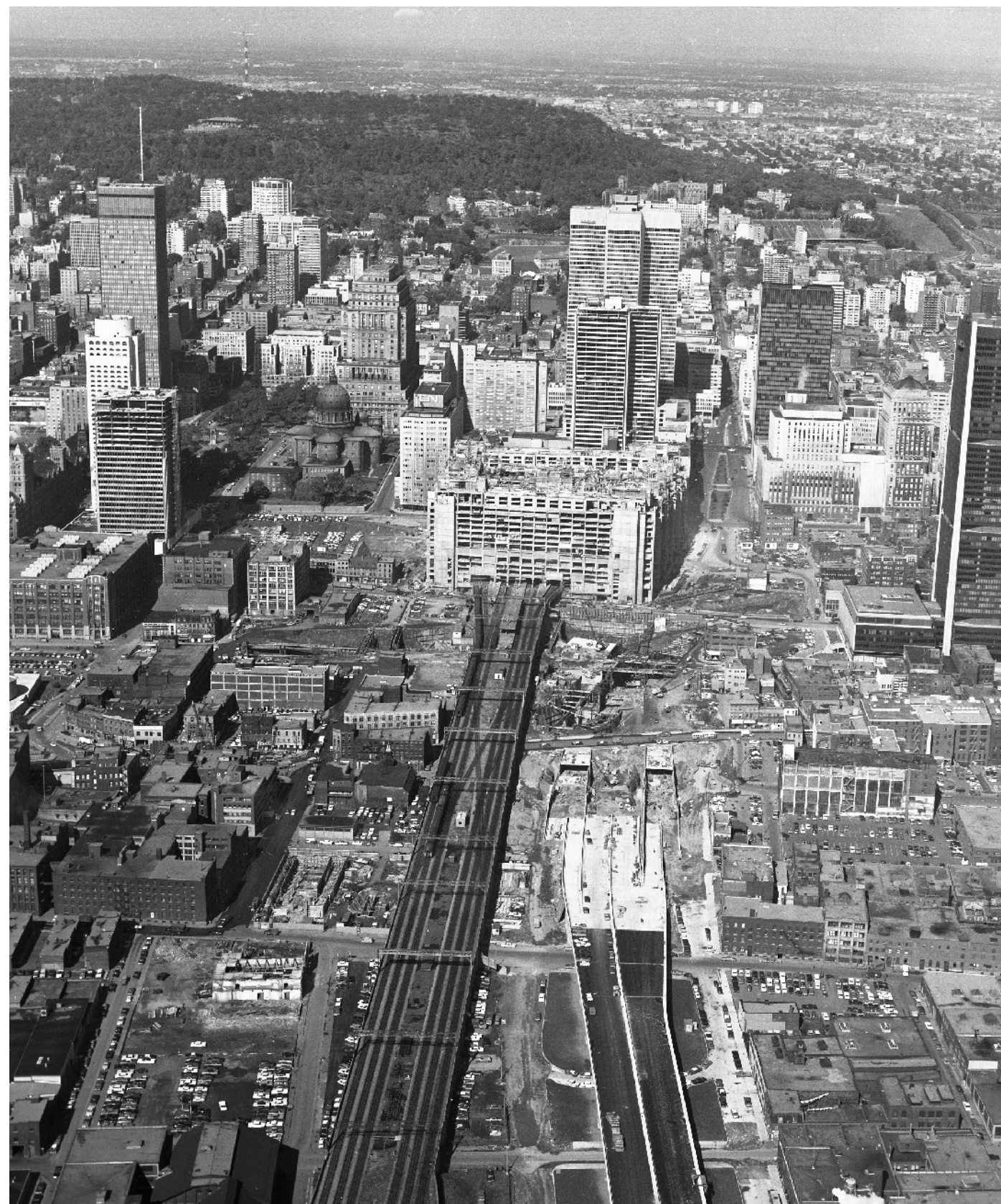
3 Le 16 septembre 1966. L'autoroute Bonaventure et, dans son prolongement, le nouveau tronçon de la rue University sont en construction. Leur point de jonction est à la rue Notre-Dame. Photo Henri Rémillard. AVM. VM94-B32-011.
