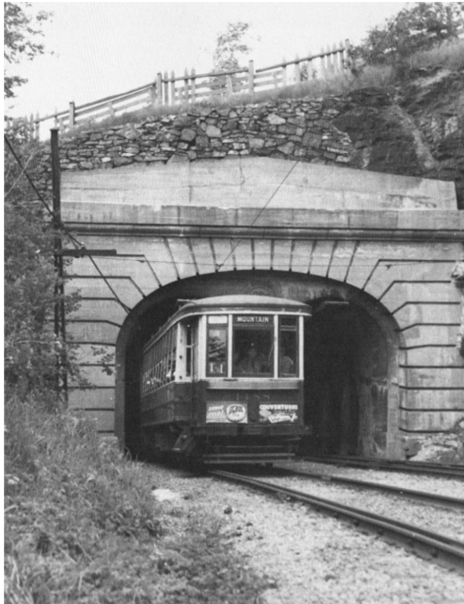
9 Sans date. Le tunnel de la ligne Mountain . À noter la présence des clôtures au sommet du tunnel. Tiré de Richard M. Binns. Montreal's Electric Streetcars - An Illustrated History of the Tramway Era: 1892 to 1959 , p. 64.
