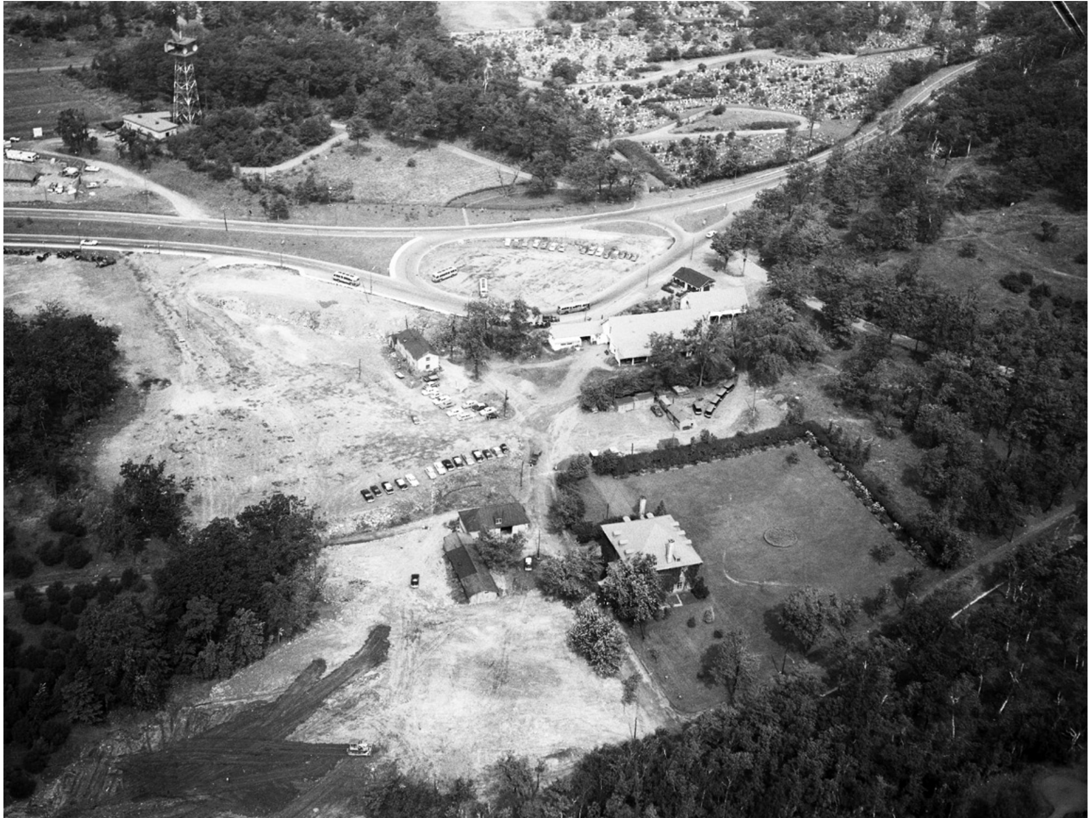
13 Le 1 er septembre 1961. La boucle qui remplace celle du tramway. Les dépendances de la maison construite par Hosea Ballou Smith et autres bâtiments sont voués à la démolition. Vue vers le cimetière Mont-Royal. AVM. VM105-Y-1_0910-005
