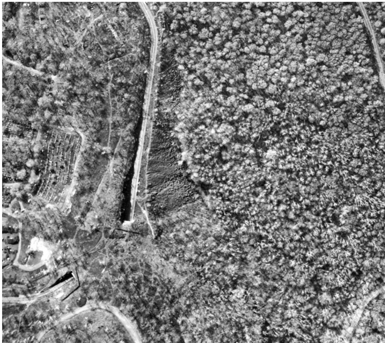
1 1947-1949. Cette vue aérienne surplombe la voie de tramway au sortir du tunnel. Le talus est situé très près de la voie ferrée et il n'y a aucun espace pour un belvédère. AVM. VM97-3_7P11-33.
