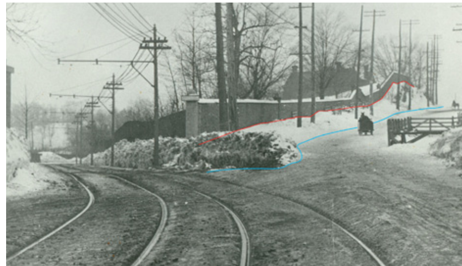
2 1912. Photo prise avant que la Ville adoucisse la pente. Surligné en bleu : la pente du chemin de la Côte-des-Neiges en 1912 avant que la Ville l'adoucisse. Surligné en rouge : le dénivelé de la pente d'origine. Surligné en bleu : la pente avant qu'elle soit adoucie. La maison Thompson, cachée derrière le mur de pierre, est aujourd'hui au-dessus du chemin de la Côte-des-Neiges. ASTM. 3-912-004.
