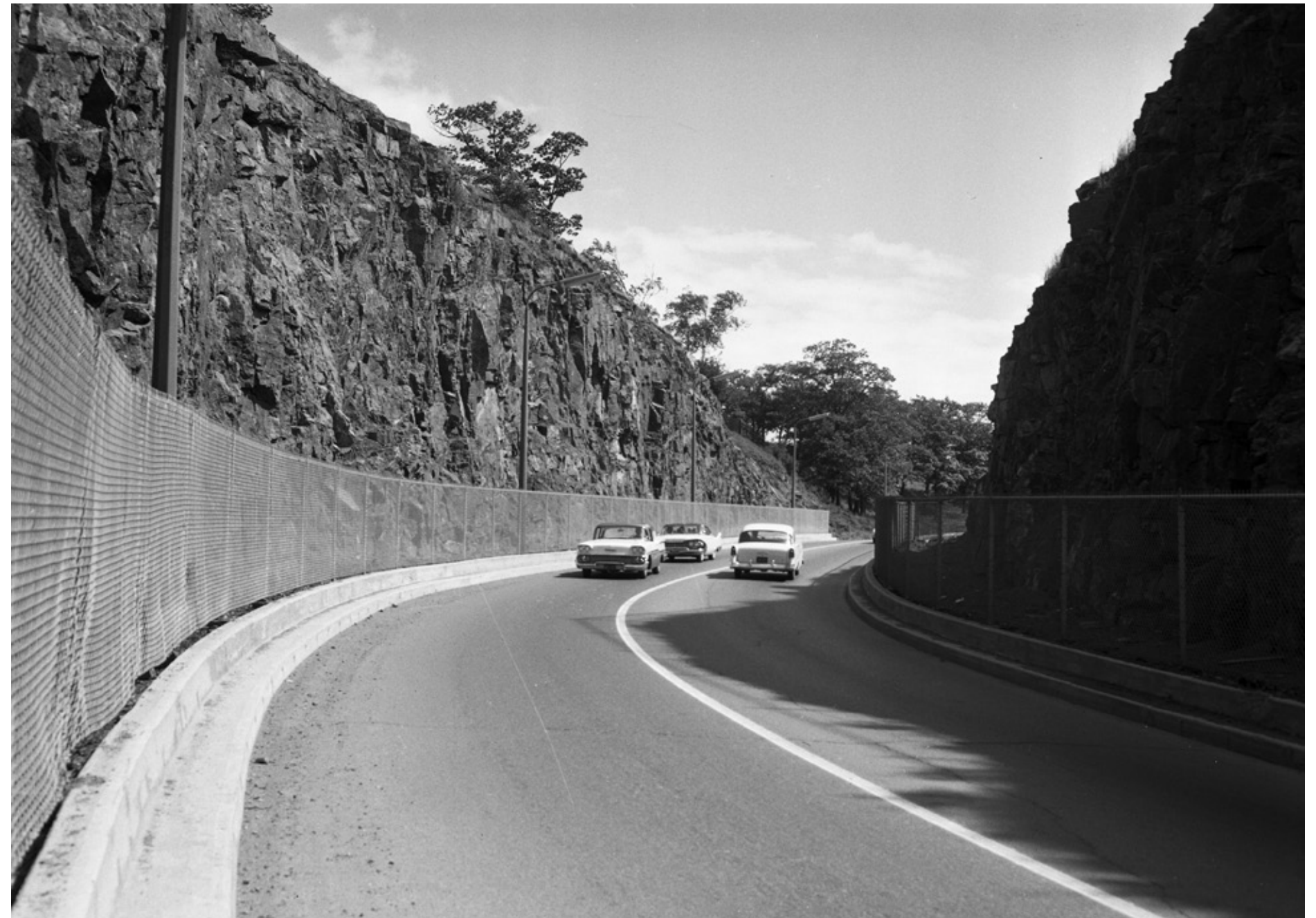
3 Juillet 1960. Couloir dans la courbe de l'ancien tunnel. Jean-Paul Gill, photographe. AVM. VM94-A0047-002.
