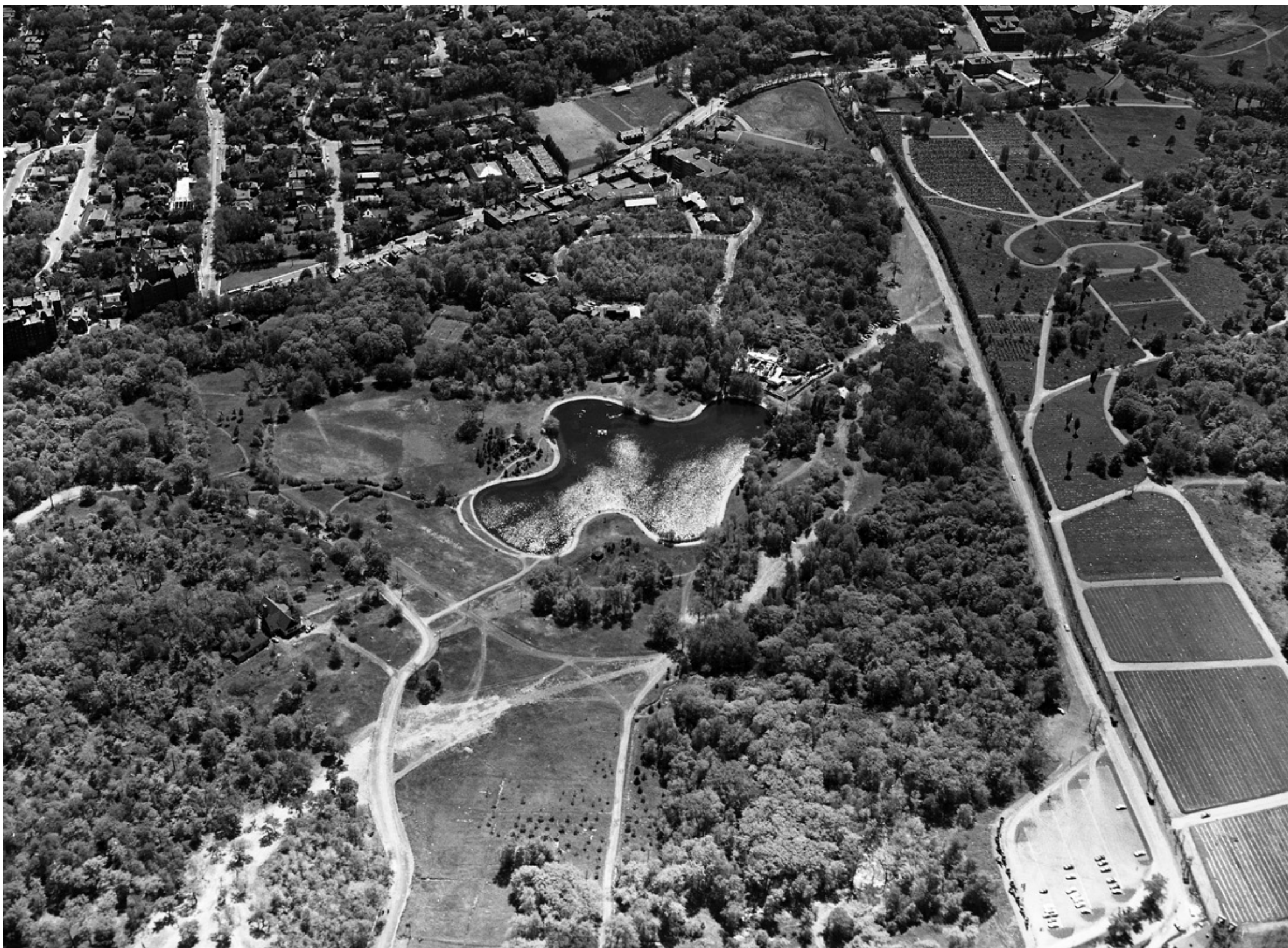
6 Le 29 mai 1957. Vue oblique sur le chemin Remembrance, le chemin de la Côte-des-Neiges, le parc du Mont-Royal et le cimetière Notre-Dame-des-Neiges. On y remarque, au bas de la photo à droite, un stationnement au Sud du chemin Remembrance et au Nord, une nouvelle entrée du cimetière Notre-Dame-des-Neiges. AVM. VM105-Y-1_0490-004.
