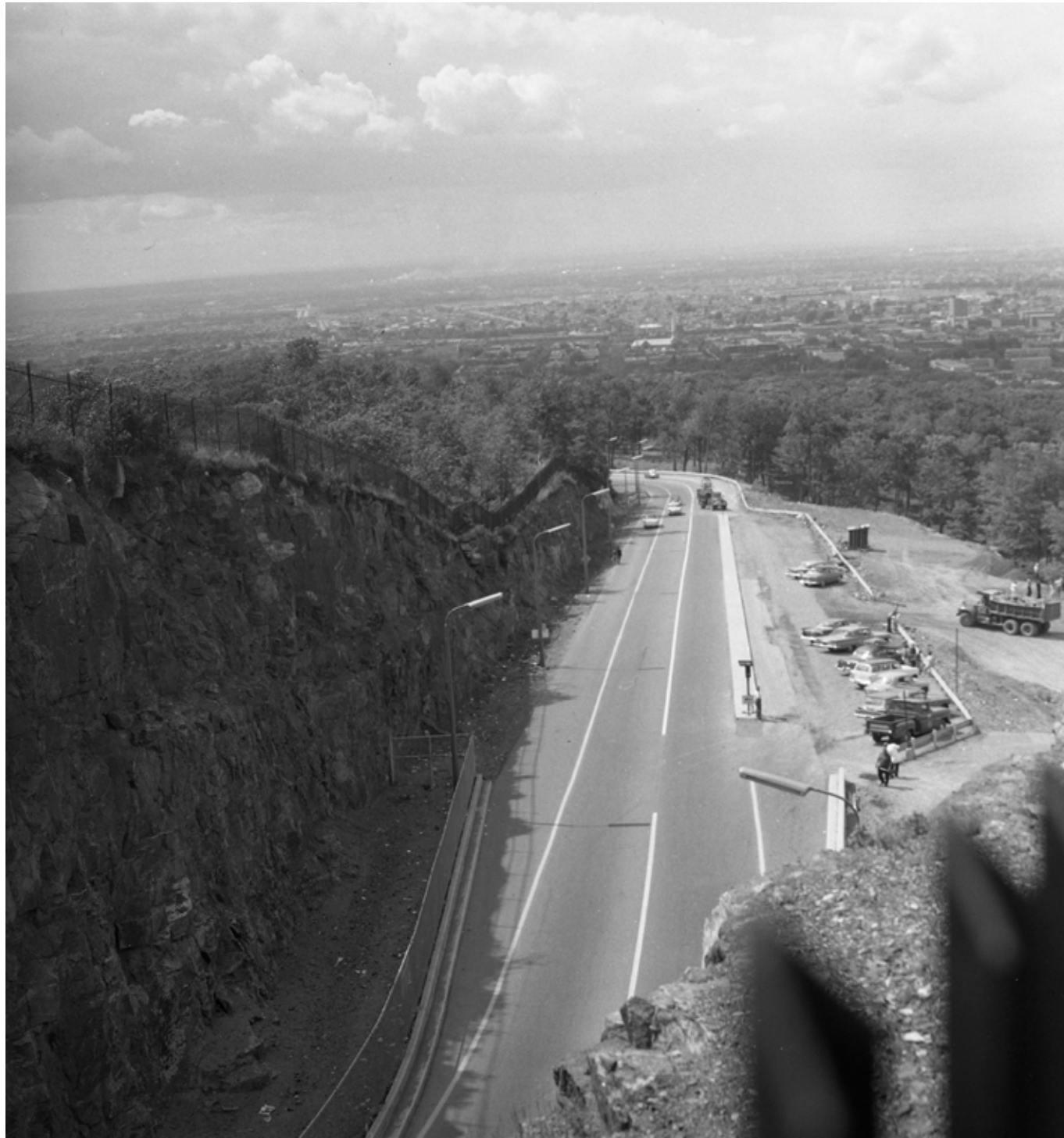
9 Juillet 1960. Des travaux sont en cours au belvédère Camillien-Houde. On remarque deux camions. Le premier encore sur la voie Camillien-Houde s'apprête à entrer sur le belvédère en chantier et le second est situé près du sommet du talus. On remarque aussi des tas de terre (ou de pierre) derrière ce camion et des ouvriers qui y travaillent. Jean-Paul Gill, photographe. AVM. VM94-A47-004.
