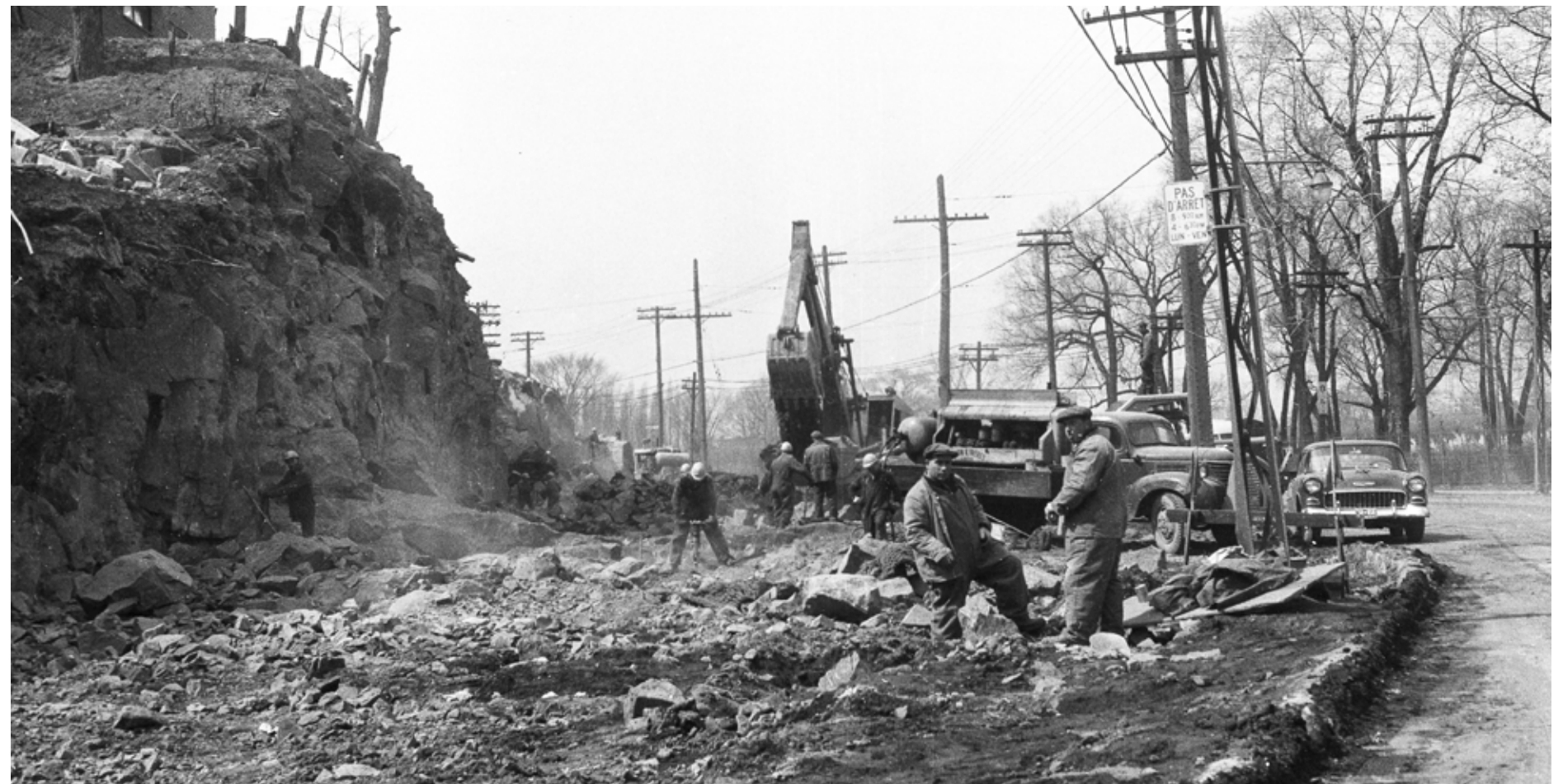
1 1957-1959. Cette photo montre l'ampleur des importants travaux d'élargissement du sinueux chemin de la Côte-des-Neiges dans l'axe Nord-Sud de la montagne. AVM. R3173-2_3449-4505-046.
