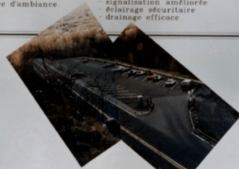
Le belvédère avant les travaux, s'offrait par d'infrastructure d'accès aux nombreux visiteurs.
