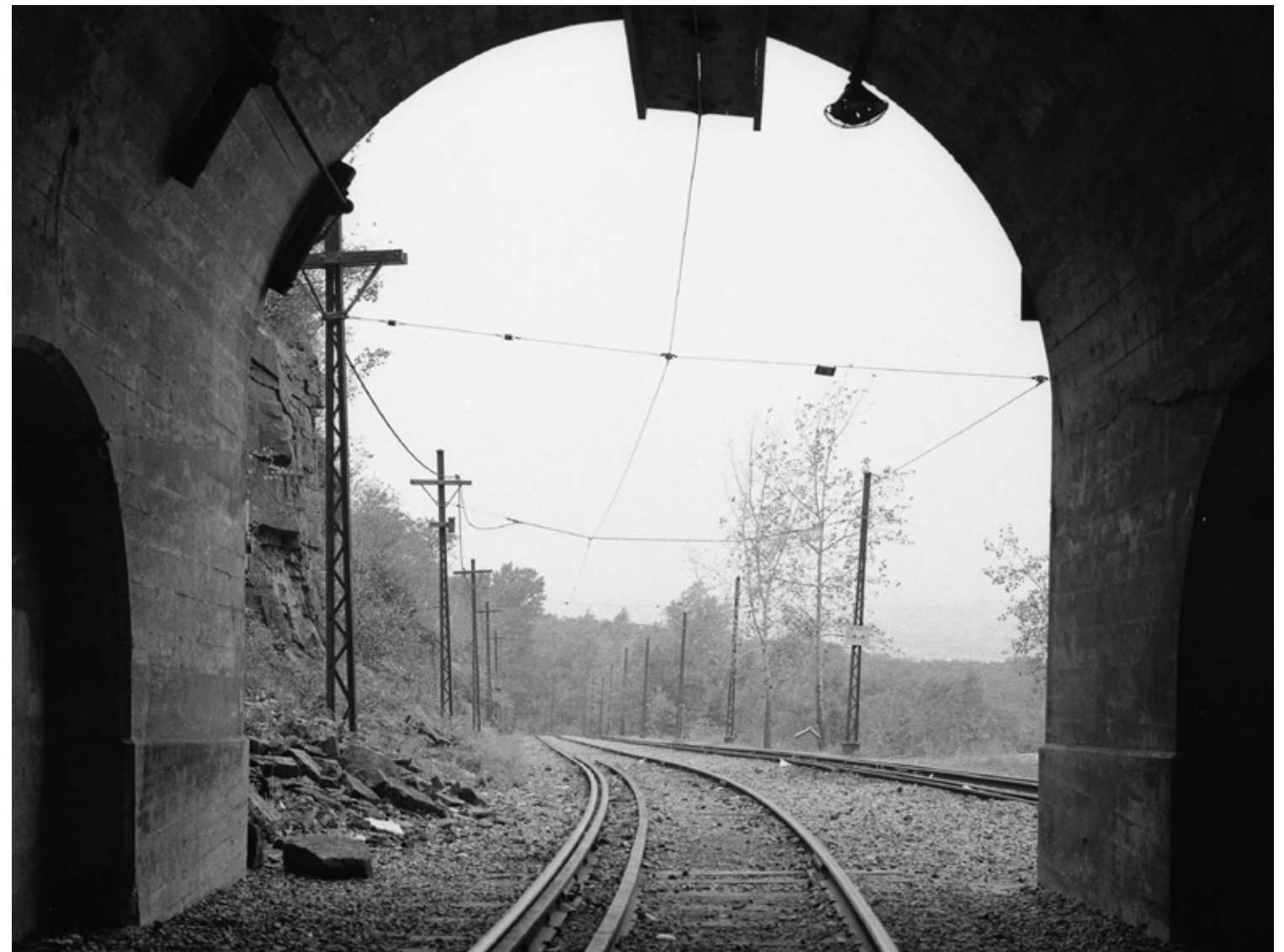
2 La fin des années 1950. La sortie du tunnel avant la construction du belvédère Camillien-Houde. À droite, les poteaux longent le sommet du talus confirmant ce que montrent les photos aériennes et obliques. AVM. VM94-U739-001.
