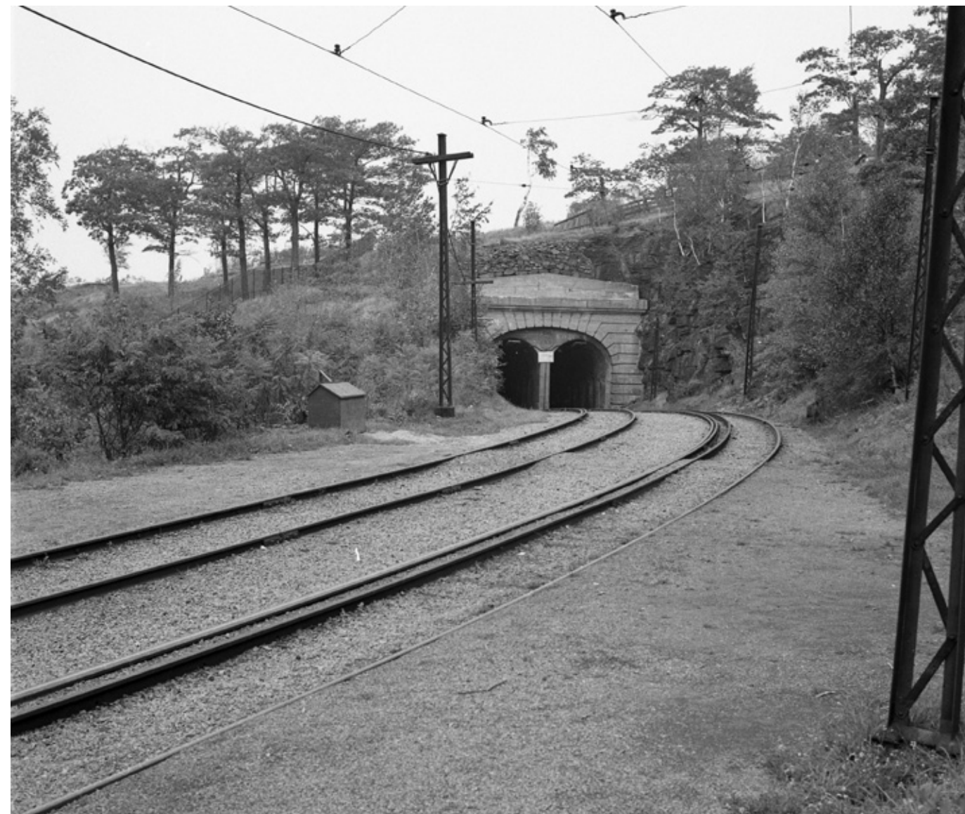
20 Début des années 1950. À gauche, une boîte de bois pour entreposer le sable. À remarquer, en haut à gauche la clôture qui sépare le cimetière Mont-Royal du parc. AVM.VM94-U0739-005.
