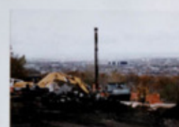
Travaux en cours comprenant le réaménagement des infrastructures, d'électricité, d'éclairage etc...
