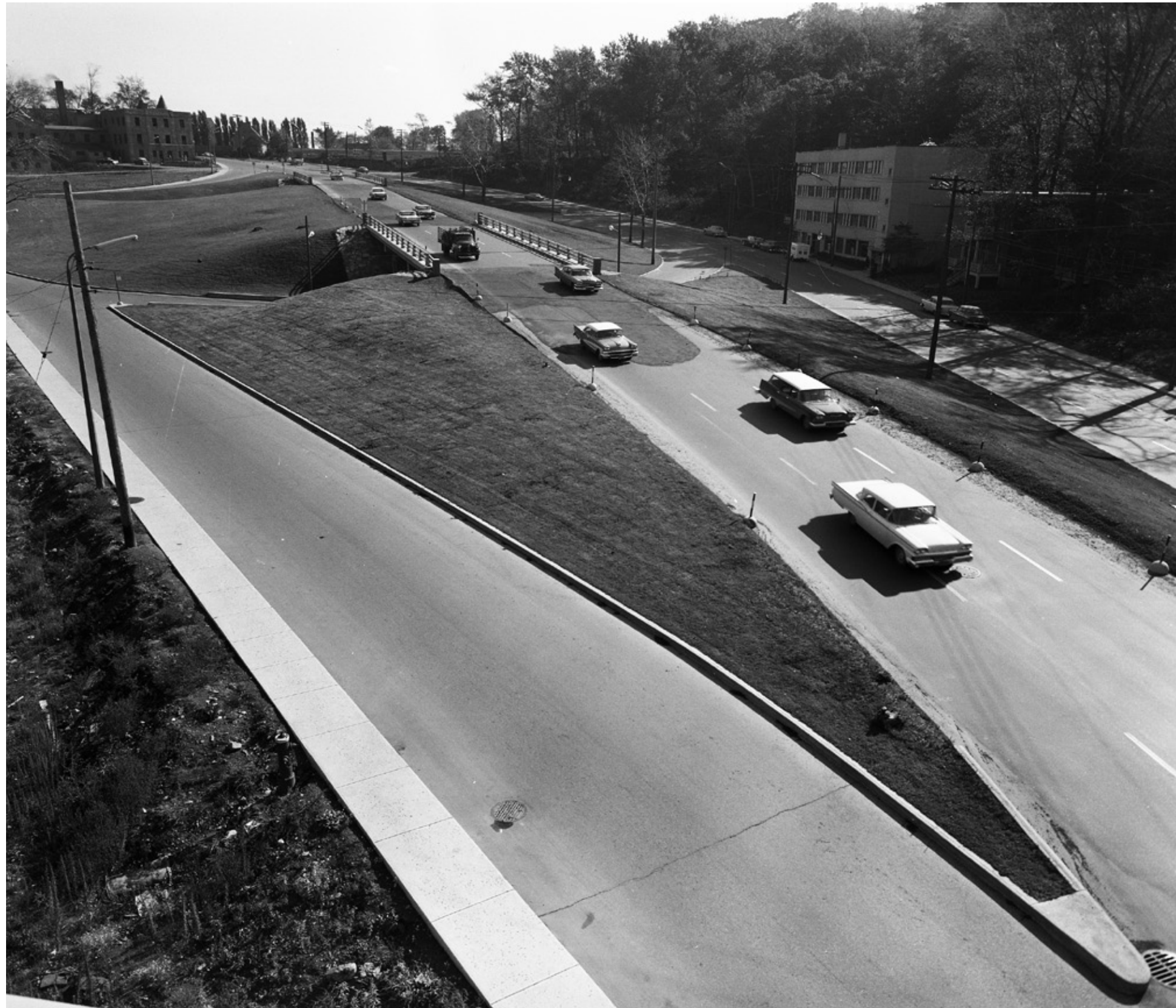
5 Le 16 octobre 1959. Vue vers le Sud de l'échangeur Côte-des-Neiges/Remembrance dans l'axe du chemin de la Côte-des-Neiges. AVM. VM105-Y-1_0721-004.
