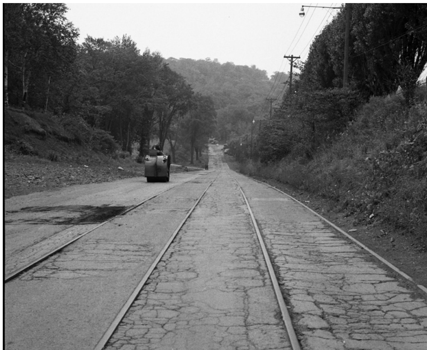
19 Avant 1958. Le chemin Remembrance dans la descente vers l'Ouest. À gauche, le parc et à droite le cimetière Notre-Dame-des-Neiges. On y remarque une rangée d'arbres plantée à l'intérieur du cimetière. AVM.VM94-U0739-024.
