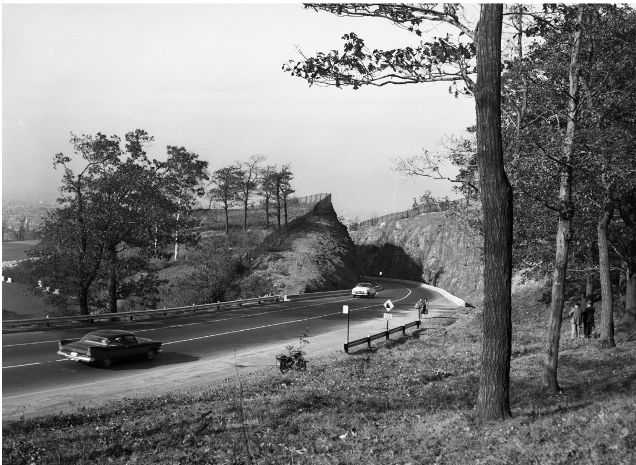
10 Le 22 octobre 1958. La vue du couloir (le tunnel des tramways démolis) limité par les parois rocheuses. Vue vers l'Est. À gauche, on voit des stèles du cimetière Mont-Royal. AVM. VM105-Y-1_0638-001.
