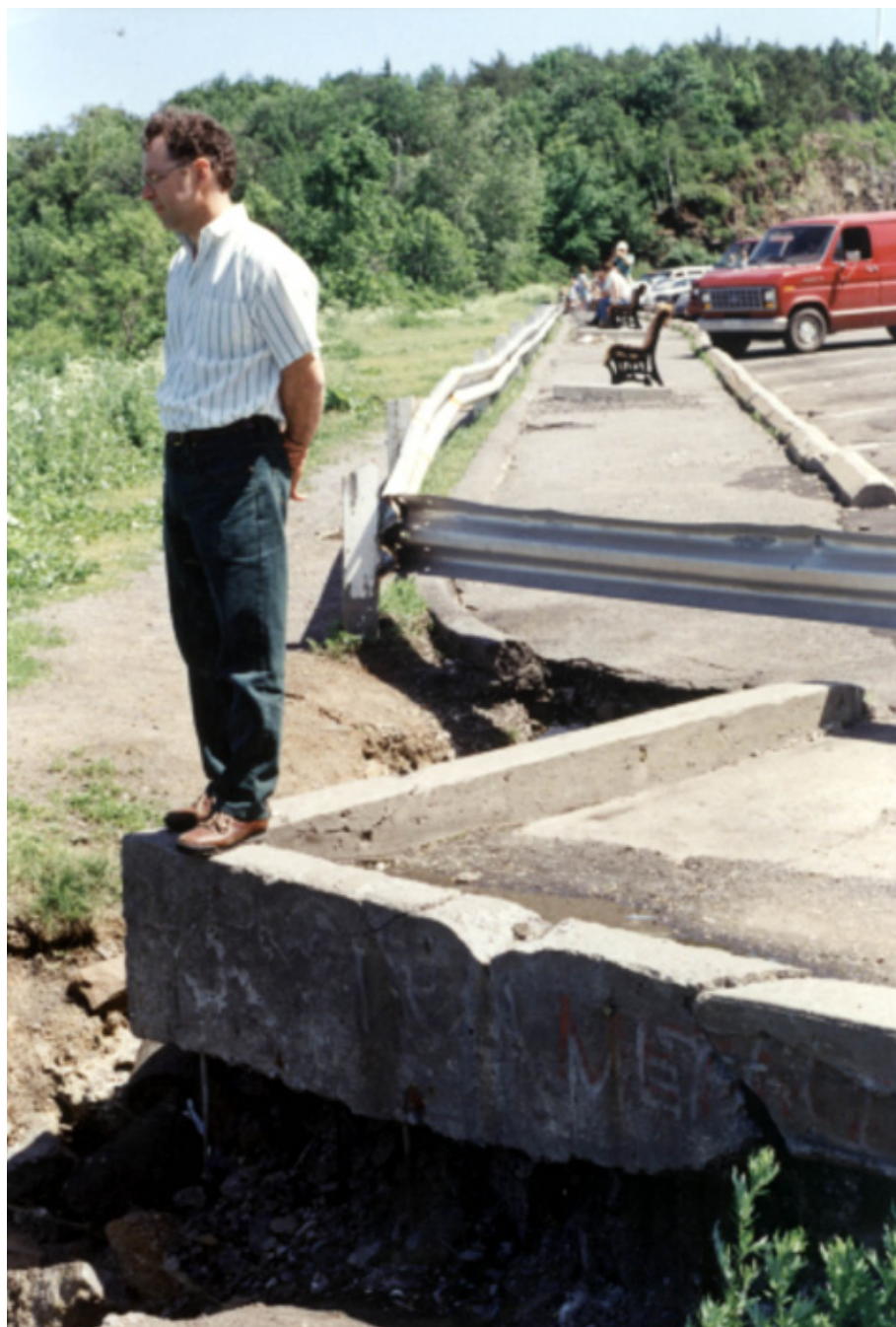
10 Avant 1995. L'état de la zone d'observation au belvédère Camillien-Houde. VM. SGPVMR. DOCS1-#41267-v1-J__6Ville-Marie_0200-0299_0225_Mt-Royal_Général_Photos_avant-apres_MR_mr164_#178a-0225_Esc_Belvédère_CH_vers_le_haut_depuis_dalle_cassée.
