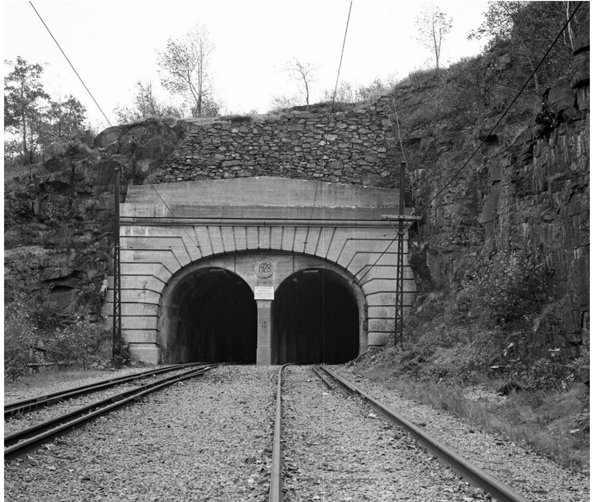
10 Début des années 1950. La date de construction du tunnel est clairement visible au centre. AVM. VM94-U0739-013.
