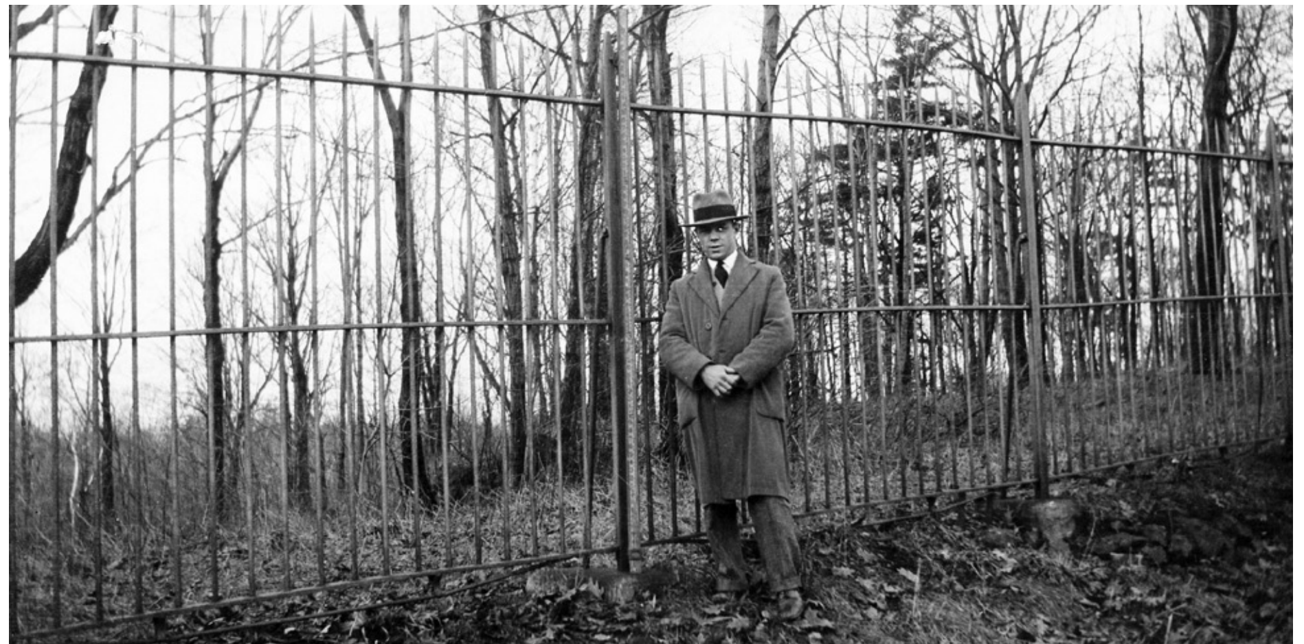
6 Non daté. La nouvelle clôture. AVM. VM1-3-2-25071-1.
