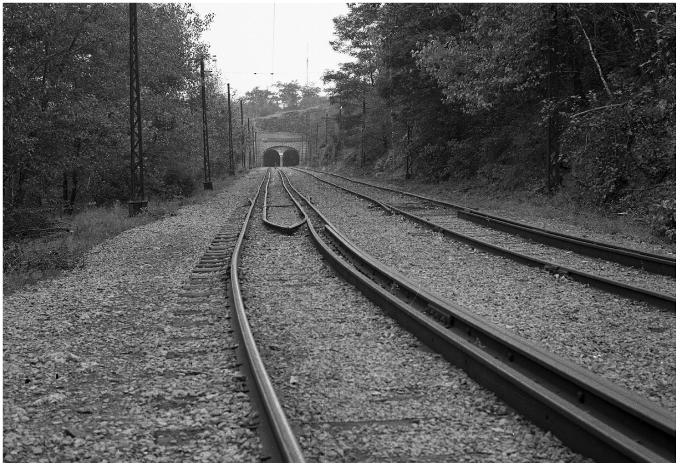
11 Avant 1958. Vue vers l'Est. Le tunnel construit en 1928. La future voie Camillien-Houde suivra ce tracé, mais sera beaucoup plus large. Étant donné l'étroitesse de la voie, la végétation et la pente abrupte prennent une place importante dans le paysage. AVM. VM94-U0739-007.
