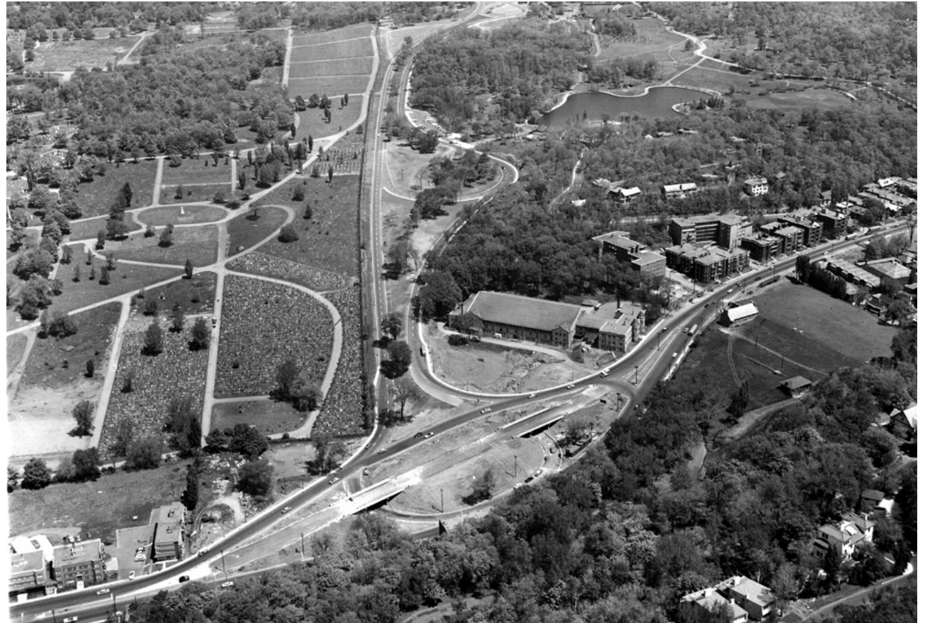
4 Le 25 mai 1959. Le chemin Remembrance. Vue oblique vers l'Est. L'échangeur Côte-des-Neiges/Remembrance est encore en chantier. AVM. VM105-Y-1_0699-05.
