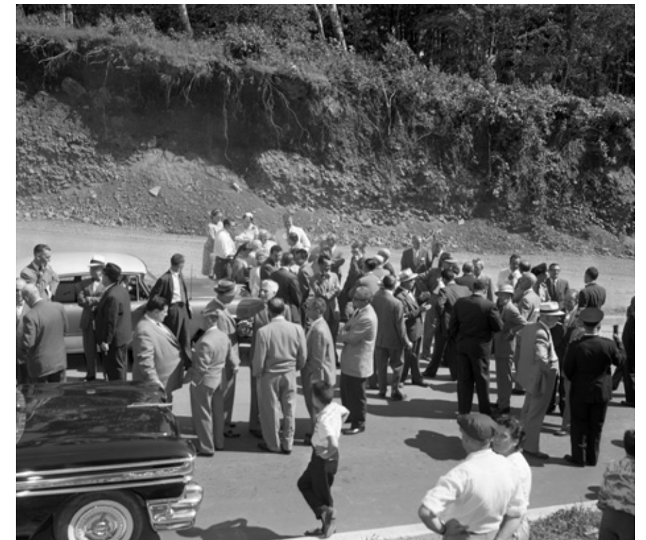
4 Le 11 août 1958. Les invités lors de l'inauguration de route de la montagne (voie Camillien-Houde). À l'arrière, les abords de cette voie laissent voir que le chantier n'est pas encore terminé. Même si cette nouvelle route suit le tracé du tramway, elle est beaucoup plus large, 24 pieds de route et 10 pieds d'accotement de part et d'autre la route. Jean-Paul Gill, photographe. AVM. VM94-Z733-10.
