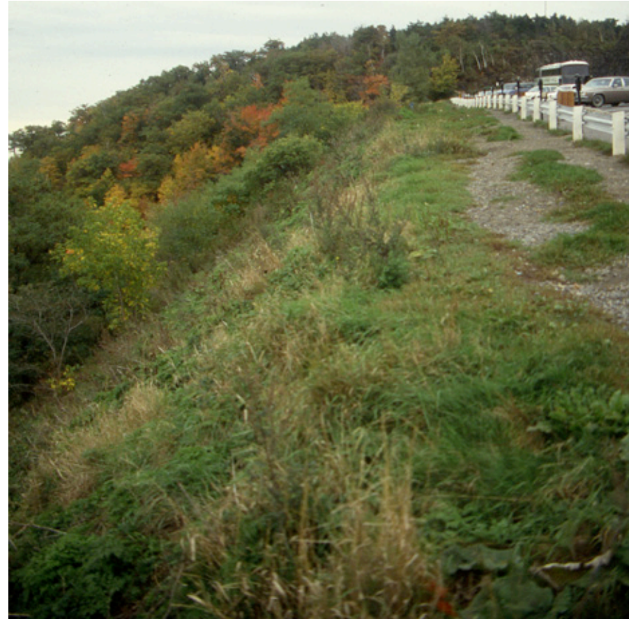
2 1980. Le talus du belvédère Camillien-Houde. VM. SGPVMR. DOCS1-#187623-v1-0225-102_Vers_1980_1-178_Photo_Belvédère_Camillien-Houde_avant_les travaux.
