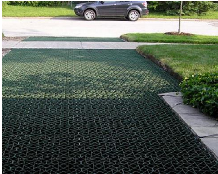
Des tuiles gazonnées à Montréal offrent à la fois une possibilité de verdissement et de circulation confortable pour tous les modes de déplacement. Source : ecologiamontreal.com
