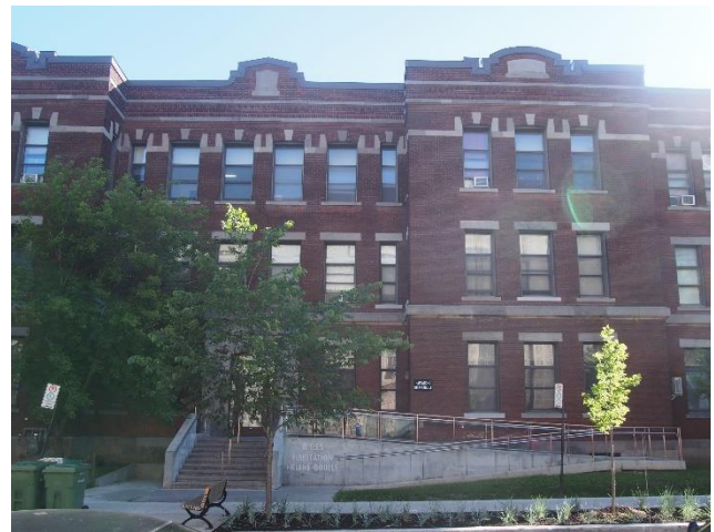
Ajout d'une rampe d'accès
