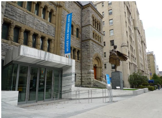
Ajout d'une nouvelle entrée de plain-pied
