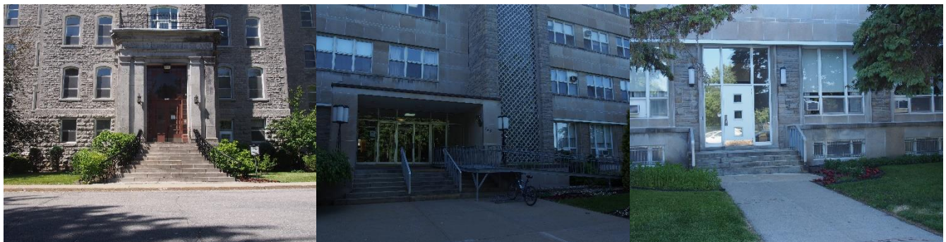
Entrée principale - Non accessible
