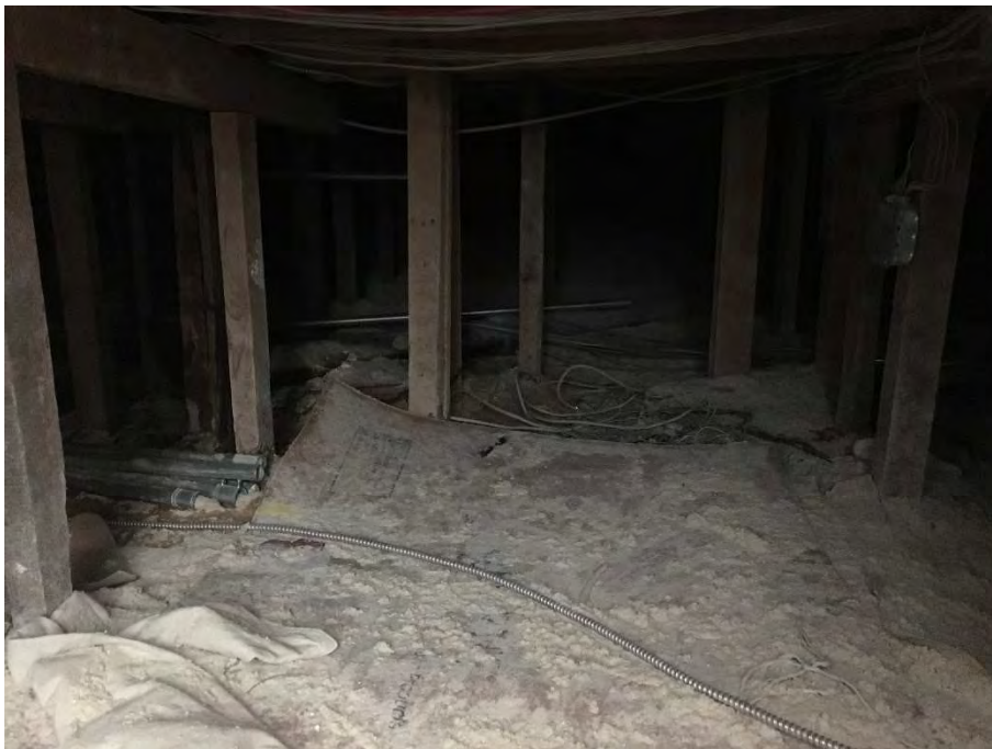
Photographie 17 : Entre-toit de la section C
