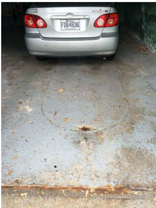
Photographie 12 : Possible ancienne fosse mécanique dans le garage du presbytère
