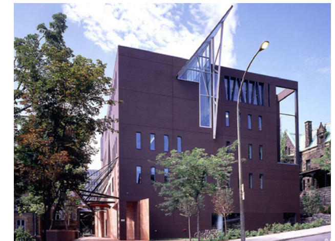
Vue de la façade du bâtiment sur la rue
