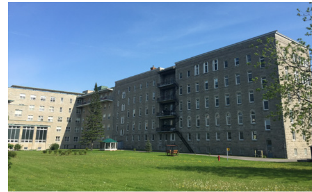
Jonction entre les ailes B et C
