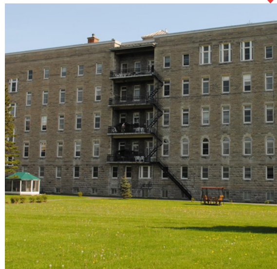
Vue de l'aboutissement de l'axe sur l'aile B
