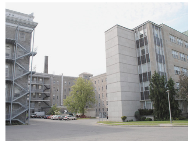
Vue de la cour de service actuelle
