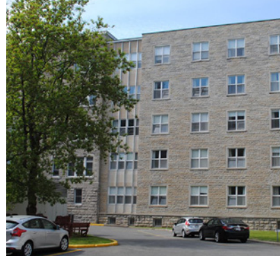
Jonction verticale avant entre bâtiments B et C pour estomper le non-alignement des étages
