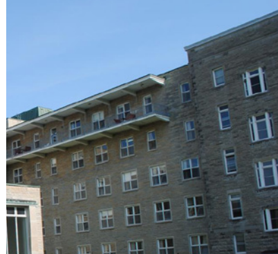
Jonction arrière entre bâtiments B et C
