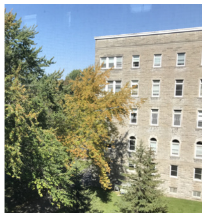
Fenestration dynamique dans l'alignement linéaire de la façade du bâtiment B
