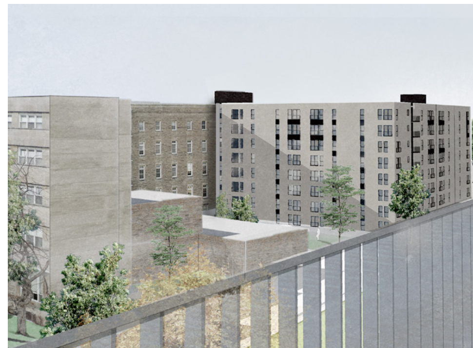
Vue avant - Jonction entre bâtiment B et B+
