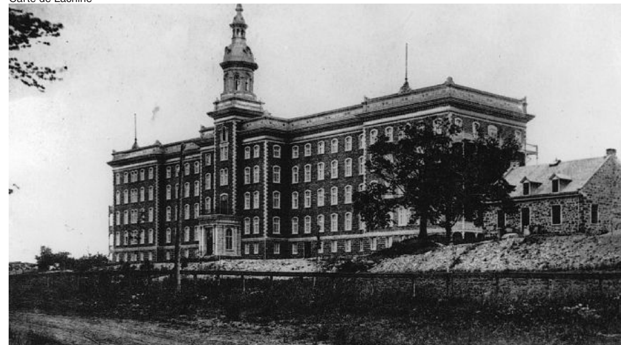
Vue de la façade principale du Mont-Sainte-Anne et de la maison du chapelain, encore avec son toit à pignon. (Source: Musée McCord)
