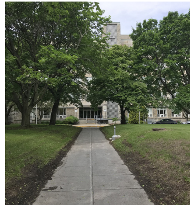
Vue de l'entrée de l'aile C à partir de l'avenue Esther Blondin
