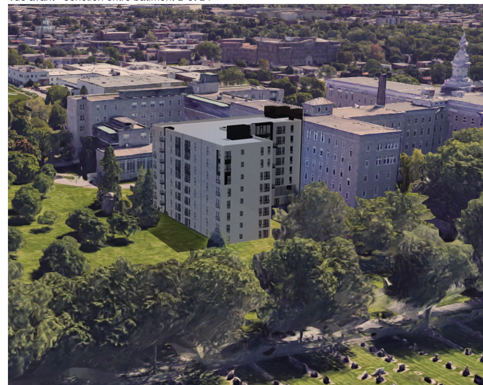
Vue arrière - Jonction entre bâtiment B et B+
