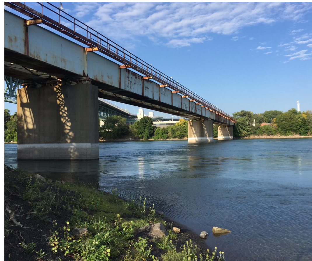
Passerelle de l'EXPO express
