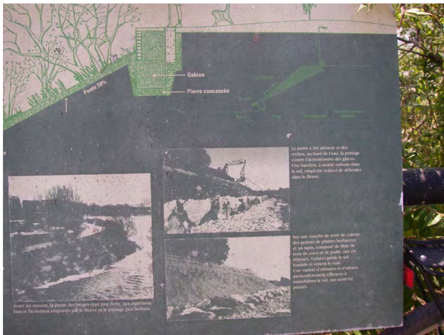
Photo 2 (04-09-2014): Travaux de stabilisation de la pointe de l'île Ste-Hélène en 1991 et 1992
