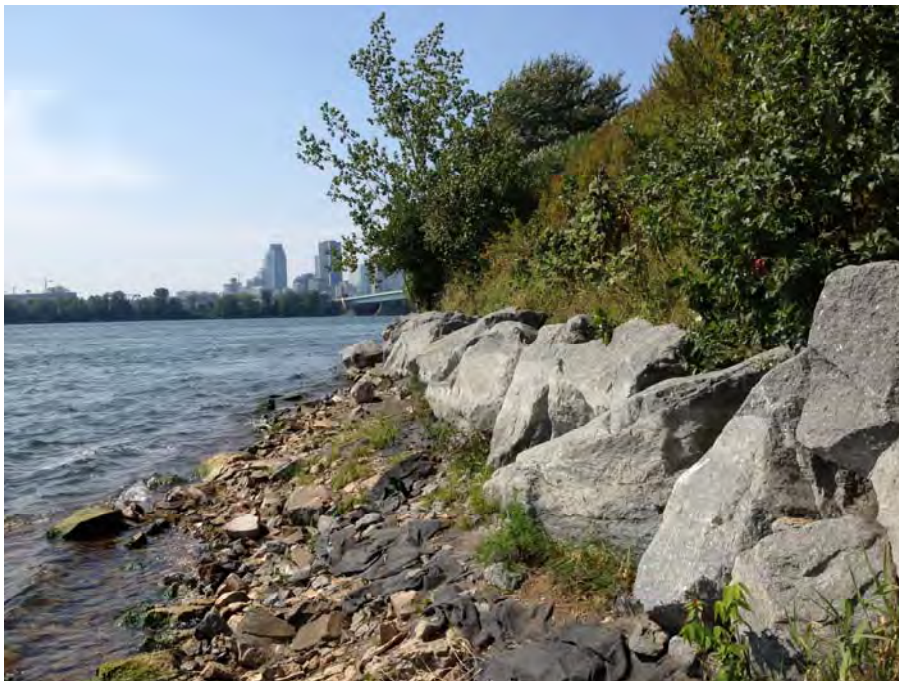
Photo 14 (05-09-2014) : Tronçon 3 – Profil général
