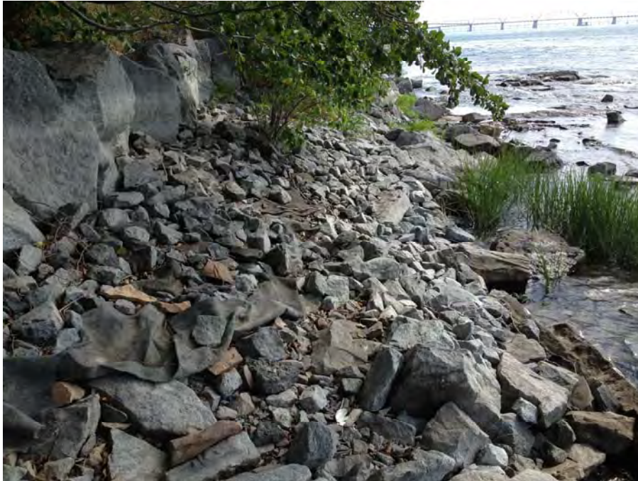
Photo 11 (05-09-2014) : Tronçon 2 – Bas de talus et plage pierreuse
