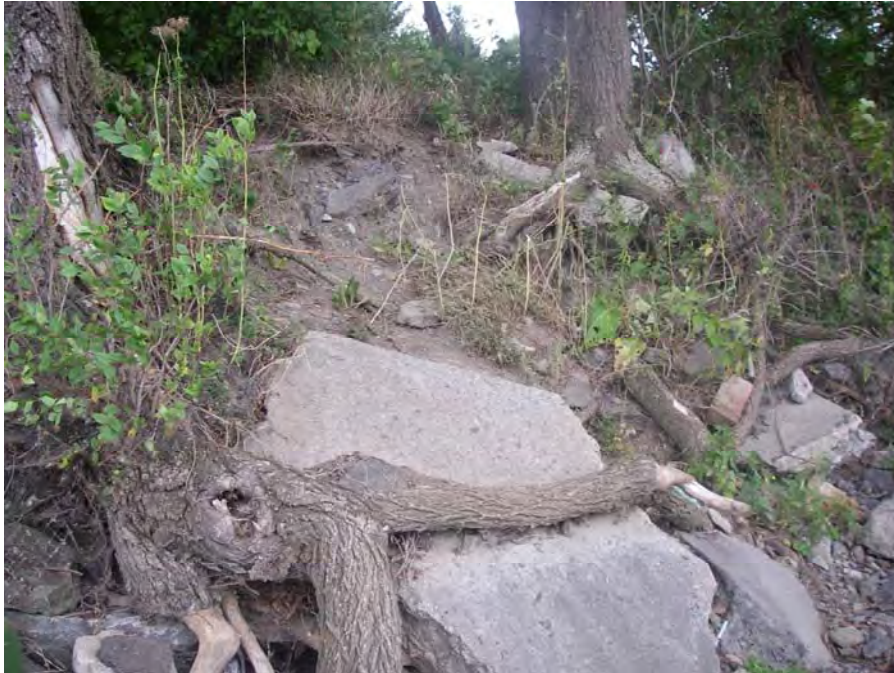
Photo 5 (05-09-2014) : Tronçon 1 – Talus et mi-talus
