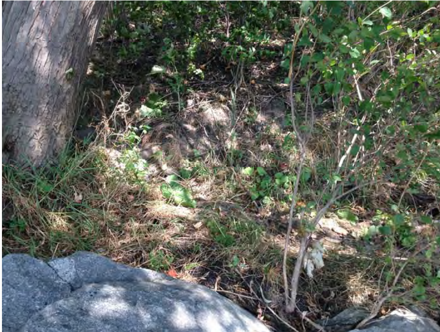
Photo 19 (05-09-2014) : Tronçon 3 – Marques d'érosion au-dessus des blocs
