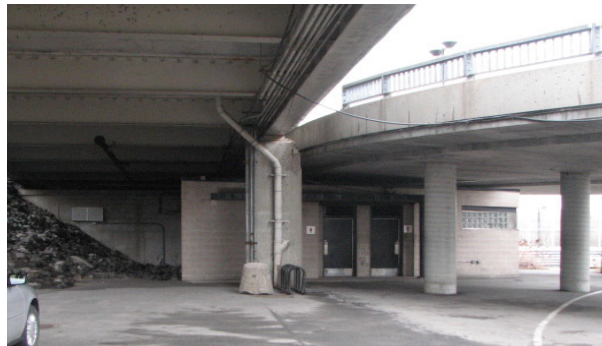
SOUS-STATION ÉLECTRIQUE VESP. PONT DES ILES | date: 1966
