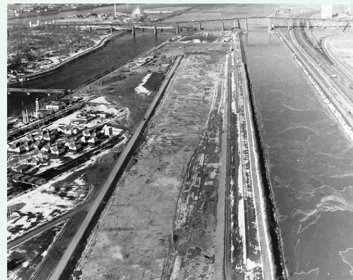
Construction du canal des sports nautiques, 1975, Archives de la Ville de Montréal.
