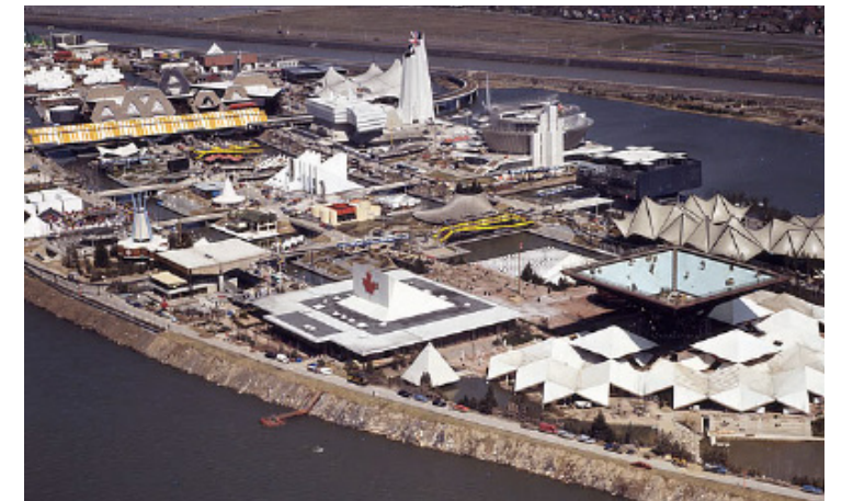
Vue aérienne du Pavillon du Canada, 1967 (Archives Nationales du Canada).
