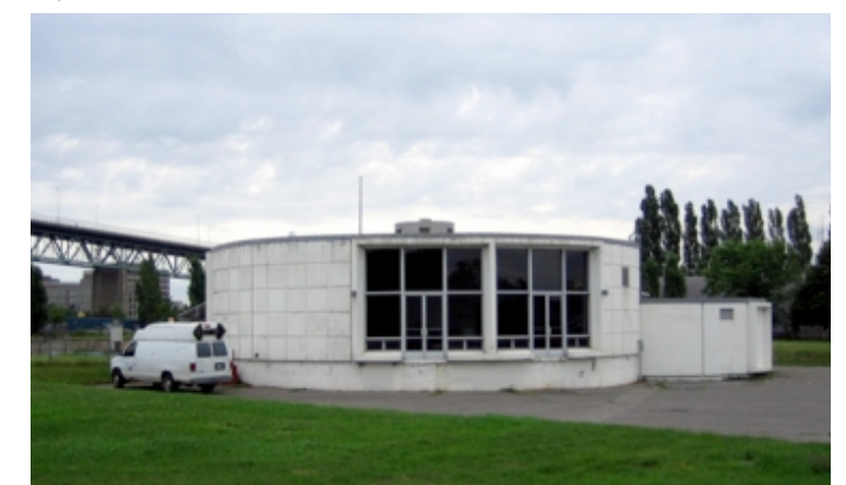
Station de pompage de l'usine d'épuration - île Notre-Dame (2006), Conrad Gallant et Marie-France Morin Messier, 2016.
