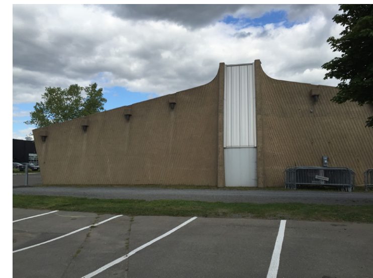
Vue extérieure du hangar permanent du bassin d'aviron et de canoë, Jonathan Cha, 2016.
