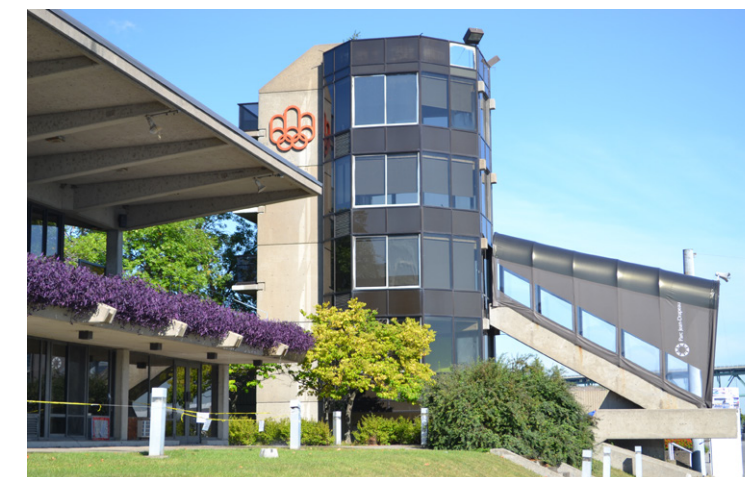
Vue extérieure de la tour d'arrivée du bassin d'aviron et de canoë, Jonathan Cha, 2016.
