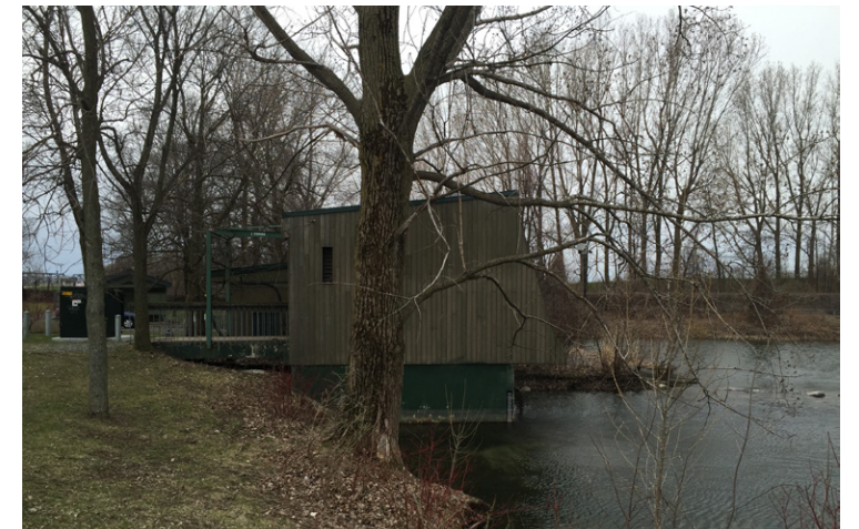
Station de vidanges des eaux, Jonathan Cha, 2016.
