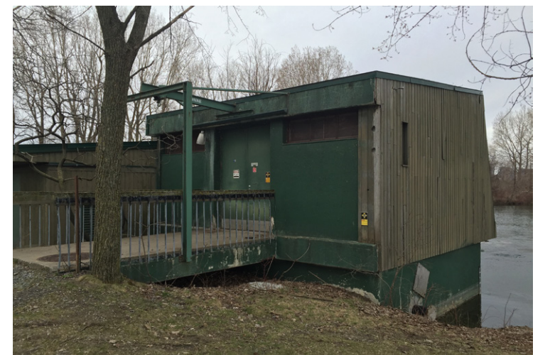
Station de vidanges des eaux, Jonathan Cha, 2016.
