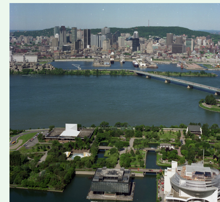
Vue aérienne secteur Pavillon du Canada, 1993, Archives de la Ville de Montréal, VM94-1993-0330-152.
