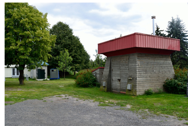
Bâtiment technique, secteur chez Tommy, Jonathan Cha, 2016.
