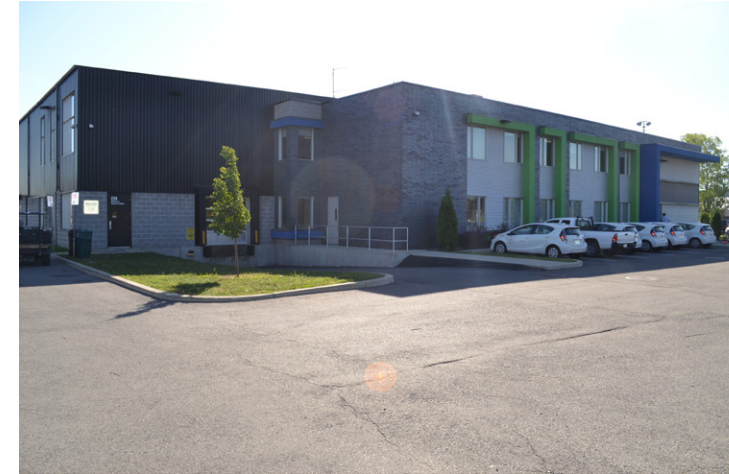
Vue extérieure du bâtiment de service du bassin d'aviron et de canoë, île Notre-Dame, Jonathan Cha, 2016.
