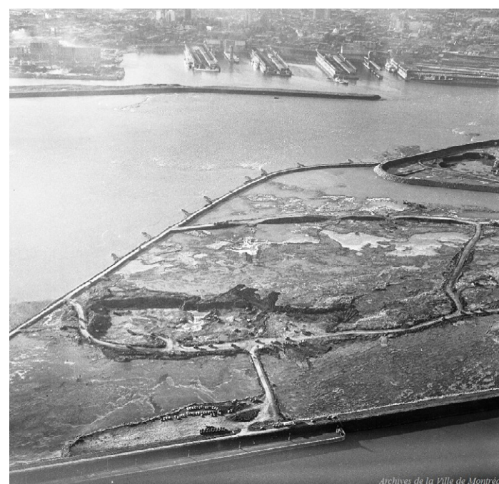
Vue aérienne de la construction de l'île Notre-Dame, Louis-Philippe Meunier, 22 octobre 1963, Archives de la Ville de Montréal, VM94-EX021-006.
