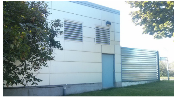
SOUS-STATION ÉLECTRIQUE | date: 1966
