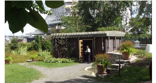
SOUS-STATION ÉLECTRIQUE (T29) | date: 1979
