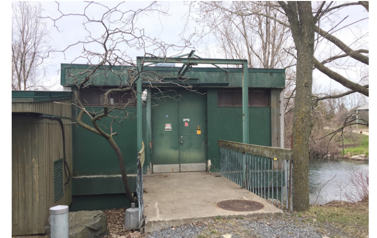
Station de vidanges des eaux, Jonathan Cha, 2016.
