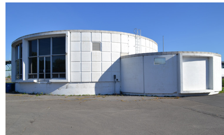
Station de pompage de l'usine d'épuration, Jonathan Cha, 2016.
