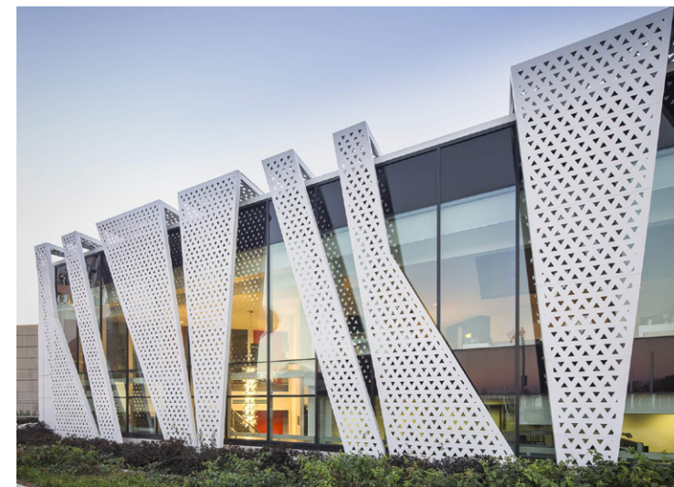
Agrandissement du Casino de Montréal, Provencher-Roy, vers 2013.
