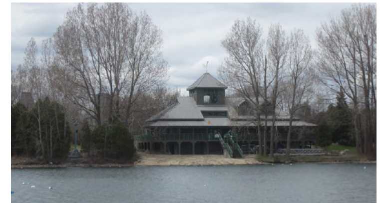
Pavillon des activités nautiques, Jonathan Cha, 2016.
