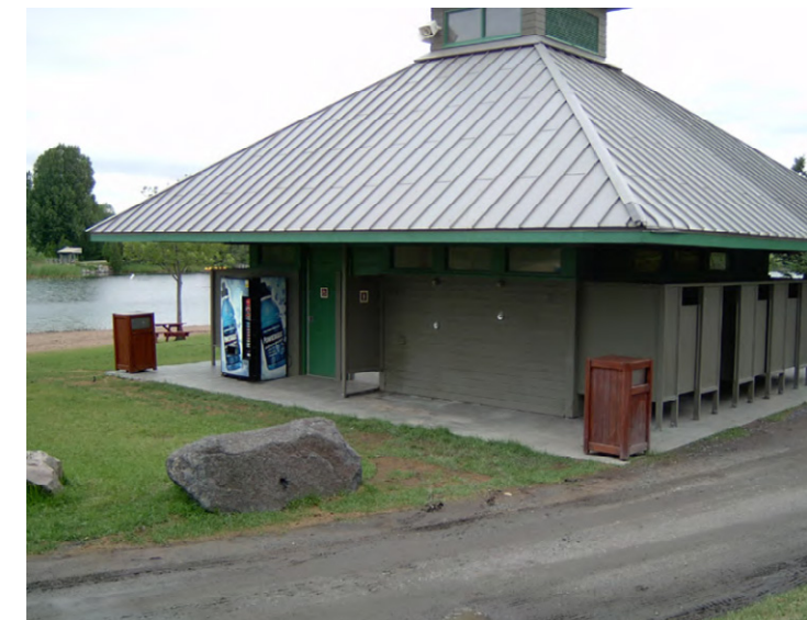
Bloc sanitaire, 2003, Archives du Service des Parcs de la Ville de Montréal, DOCS1-#72283-v1-0391_030711_161.
