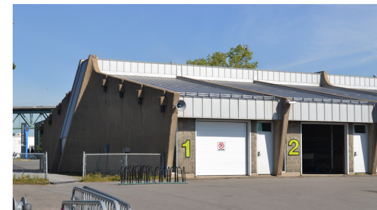
Vue extérieure du hangar permanent du bassin d'aviron et de canoë, Jonathan Cha, 2016.
