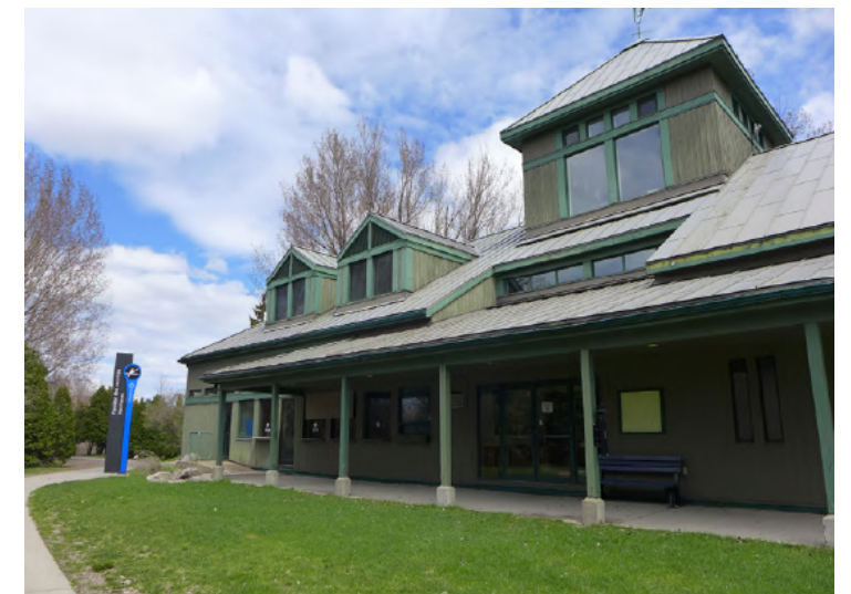
Façade avant du pavillon des activités nautiques, Jonathan Cha, 2016.
