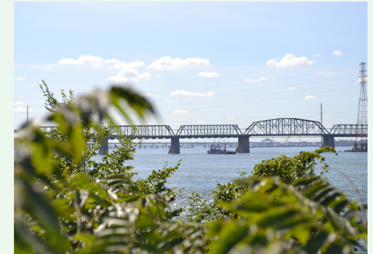
Vue du pont Victoria depuis la berge, Jonathan Cha, 2016.
