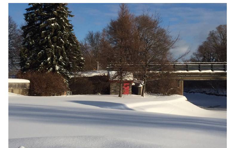
Bâtiment technique, secteur chez Tommy, Jonathan Cha, 2018.
