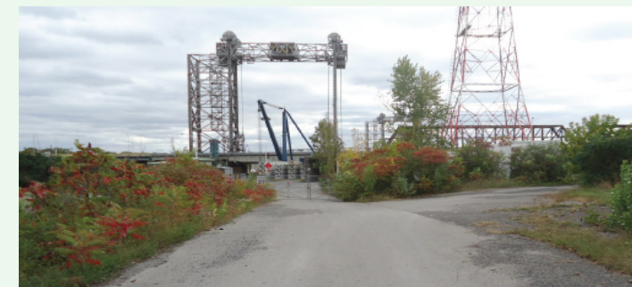
Secteur de la digue de la voie maritime, Plan d'intervention (phase 3) DAA, 2013.
