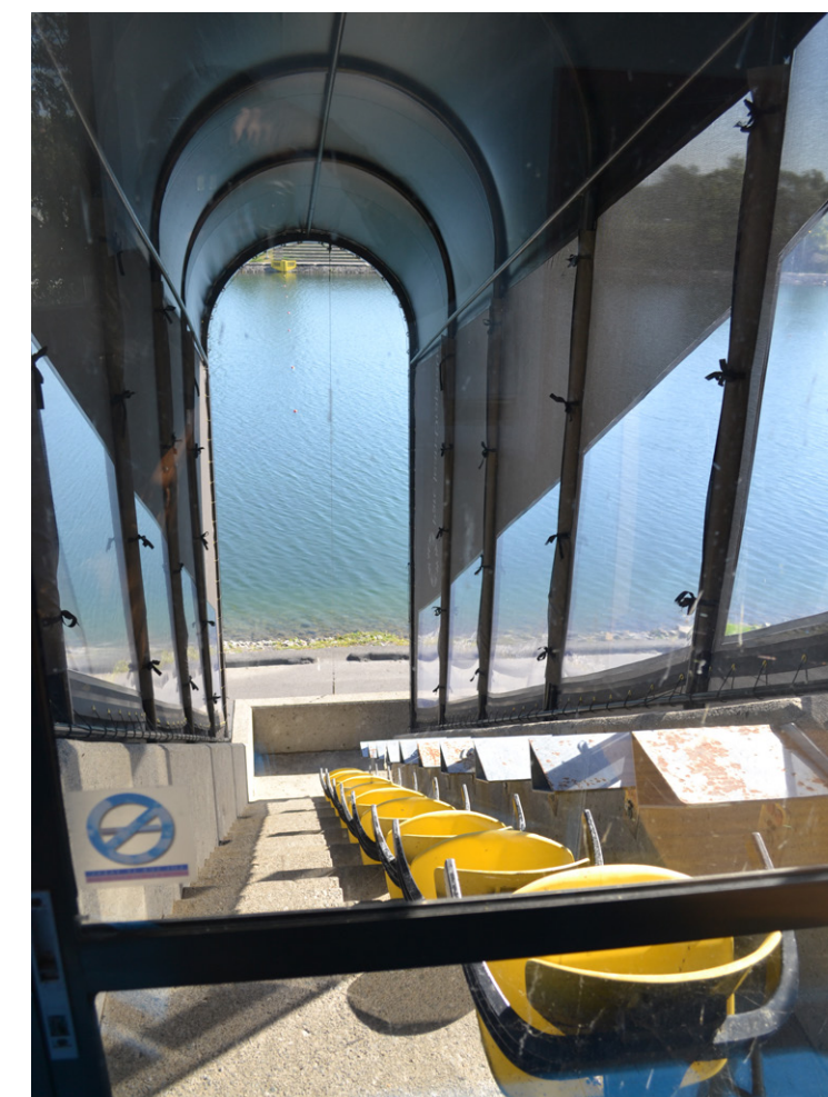
Vue extérieure de la tour d'arrivée du bassin d'aviron et de canoë, Jonathan Cha, 2016.
