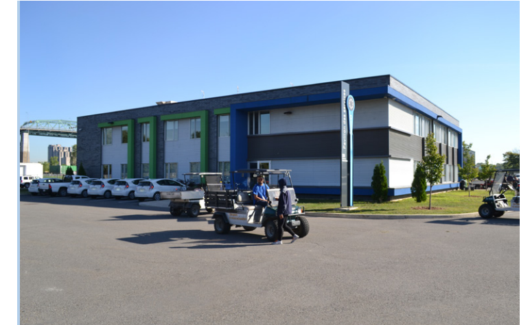
Vue extérieure du bâtiment de service du bassin d'aviron et de canoë, île Notre-Dame, Jonathan Cha, 2016.
