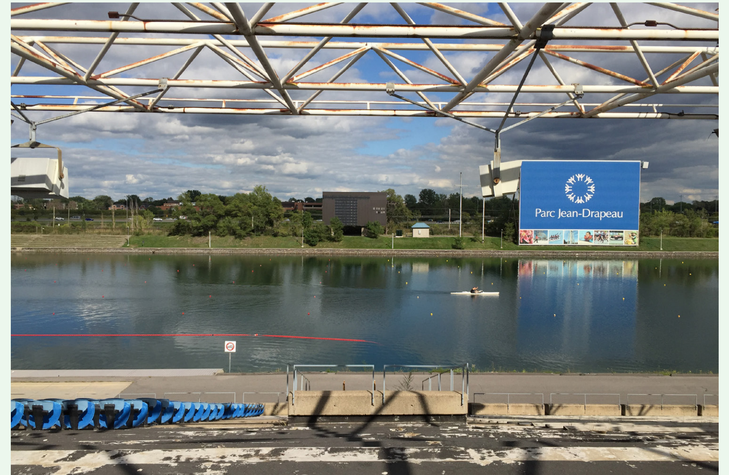
Bassin olympique depuis les grains, vue vers l'est, Jonathan Cha, 2016.
