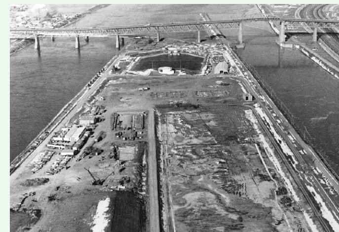
Construction du canal des sports nautiques (mare au diable en arrière-plan) 1975, Archives de la Ville de Montréal.
