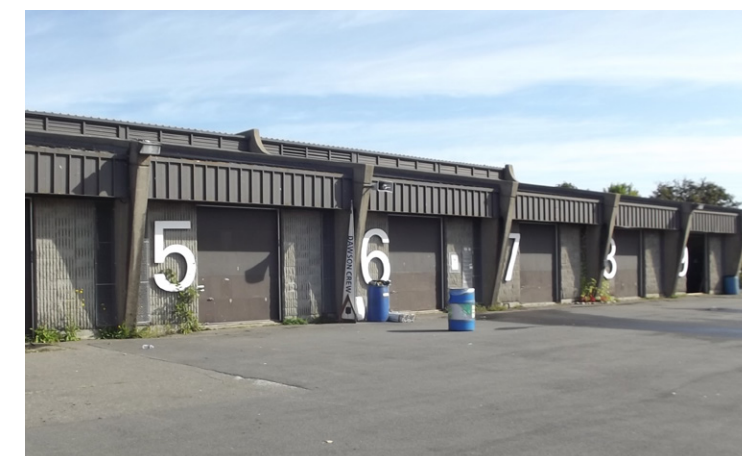
Entrepôt "B" (sud/est), 2010, Archives de la Société du parc Jean-Drapeau.
