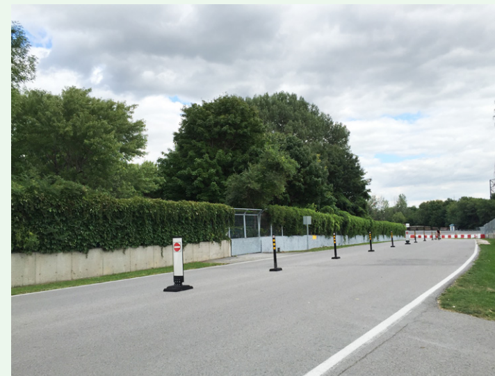
Vue du Circuit Gilles-Villeneuve, Jonathan Cha, 2016.
