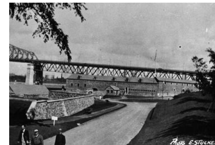
Fig. 6 : L'entrée du fort à la fin des travaux de restauration, 1939 Archive de la Ville de Montréal
