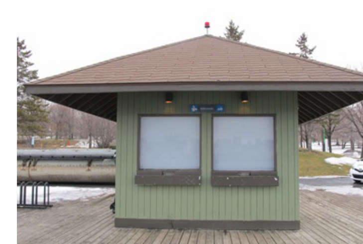
Fig. 205 : Vue d'ensemble extérieur, 2016 L&S
