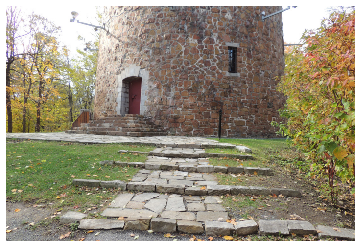
Fig. 253 : Abords de la tour de Lévis, 2015 WAA
