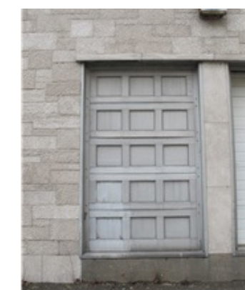
Fig. 334 : Détails extérieurs, 2016 L&S
