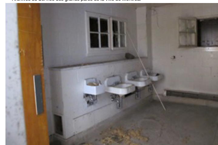
Fig. 263 : Vue d'ensemble de l'intérieur, 2016 L&S
