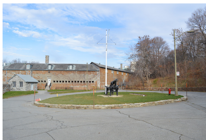
Fig. 298 : Entrée du fort avec rond-point, 2015 WAA
