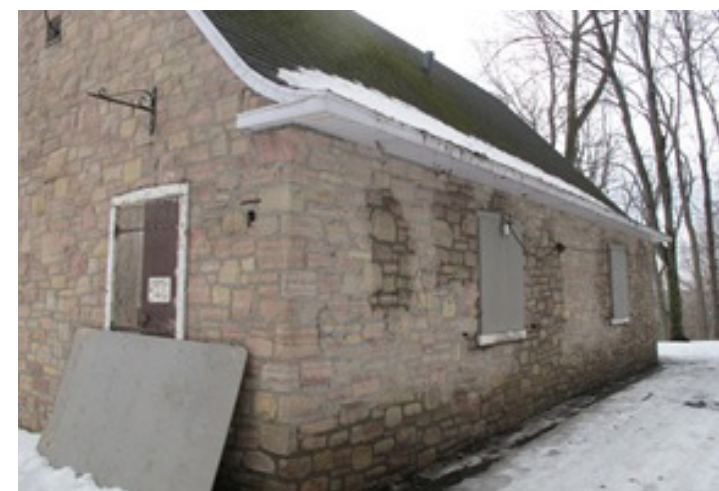
Fig. 264 : Vue d'ensemble de l'extérieur, 2016 L&S
