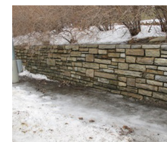
Fig. 224 : Muret de briques, 2016 L&S
