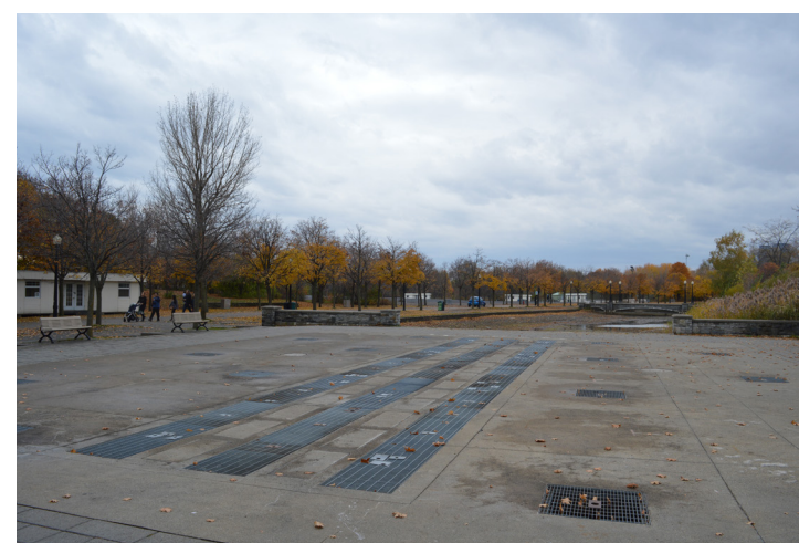
Fig. 61 : Jets d'eau non fonctionnels depuis plusieurs années sur la place d'accueil, 2015 WAA
