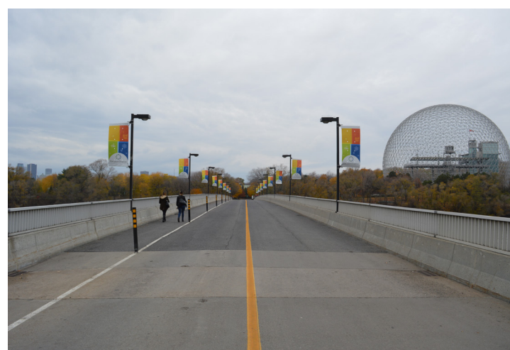
Fig. 124 : Les garde-corps en bois ont été remplacés, 2015 WAA
