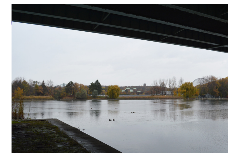
Fig. 48 : Le pont de la Concorde crée un sous-espace sombre, 2015 WAA
