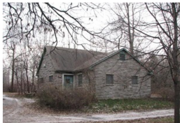
Fig. 194 : Vue générale de la vespasienne, 2010 Ville de Montréal
