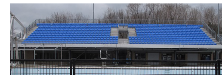
Fig. 173 : Façades principales des bâtiments A et B, 2016 L&S
