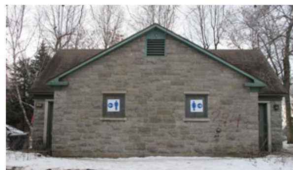
Fig. 199 : Façade latérale, 2016 L&S
