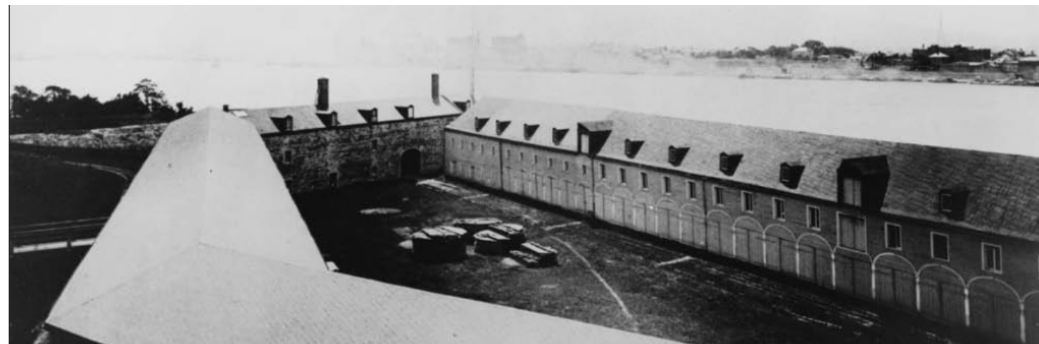
Fig. 302 : L'arsenal et l'édifice des magasins, 1890 BAnQ
