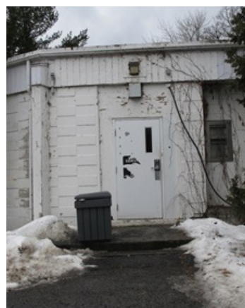
Fig. 68 : Façade extérieure, 2016 L&S
