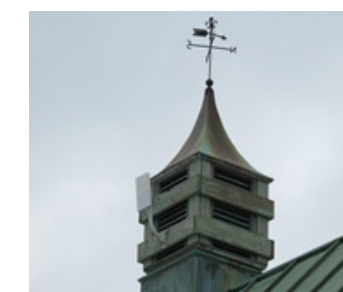
Fig. 225 : Détails extérieurs, 2016 L&S
