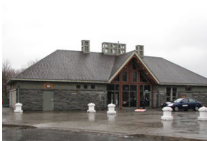
Fig. 87 : Façade principale du pavillon D40, 2016 L&S
