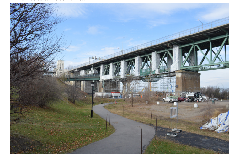
Fig. 326 : Sentier piéton passant sous le pont, 2015 WAA
