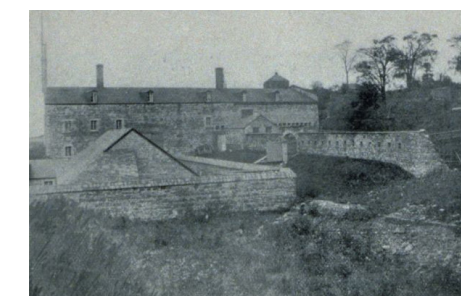
Fig. 318 : Vue générale de l'enceinte, entre 1870 et 1920 BAnQ
