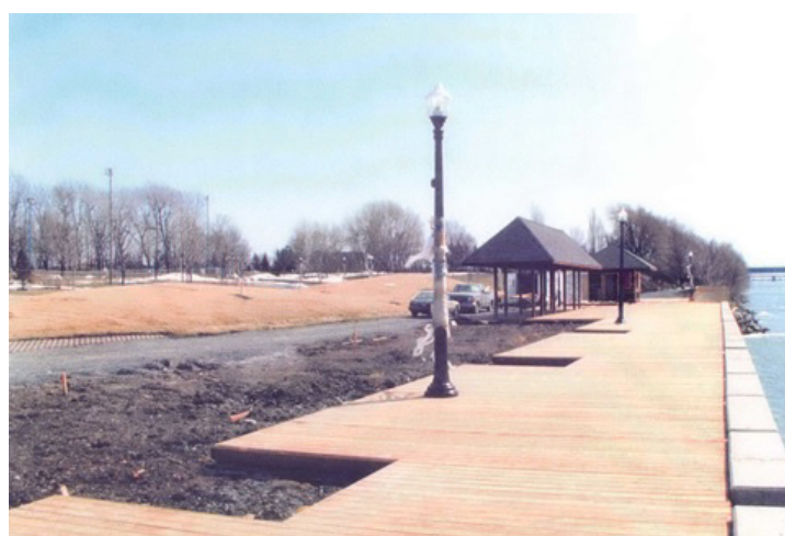
Fig. 209 : Travaux d'aménagement aux abords de l'abri ouvert de la navette fluviale et de son kiosque de perception, [s.d.] Archive du Service des grands parcs de la Ville de Montréal
