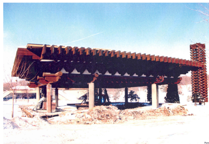
Fig. 75 : Travaux de démolition partielle Archives de la Ville de Montréal
