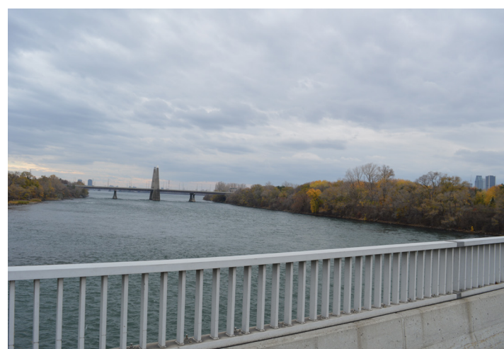
Fig. 125 : Vue sur le pont de la Concorde depuis la passerelle, 2015 WAA
