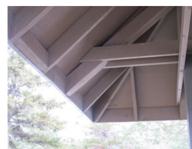
Fig. 211 : Détails de la toiture, 2016 L&S
