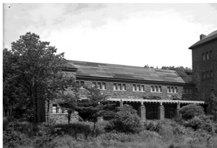
Fig. 160 : Chantier du Pavillon des Baigneurs [s.d.] Archives de la Ville de Montréal - VM-Z374.1
