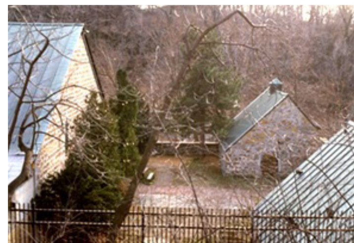
Fig. 288 : Entrepôt, 2009 Ville de Montréal
