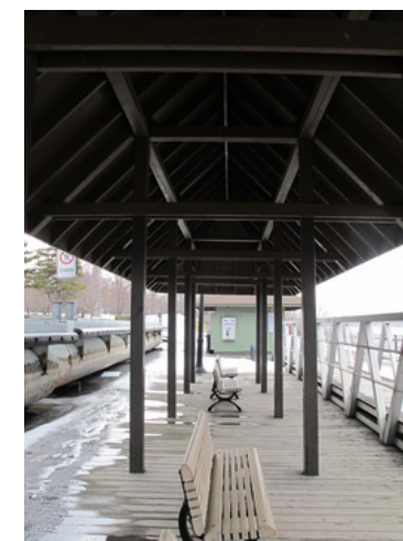
Fig. 212 : Vue d'ensemble, 2016 L&S
