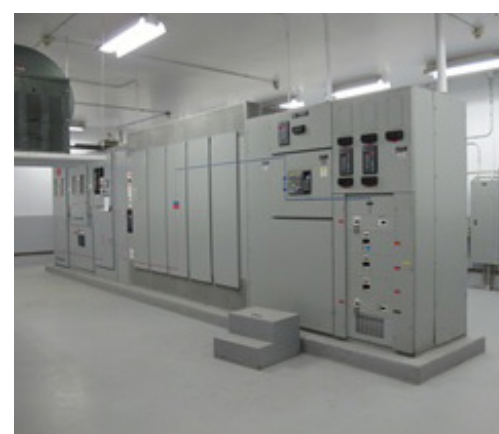
Fig. 52 : Vue d'ensemble de l'intérieur, 2016 L&S
