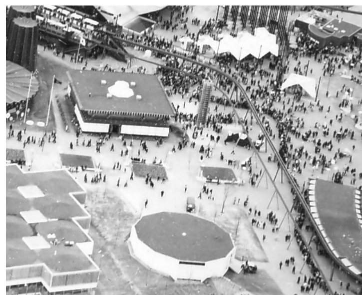
Fig. 71 : Vue aérienne du pavillon de la Corée et du pavillon des services bancaires de la CIBC dans leur environnement, 1967 Archives de la Ville de Montréal
