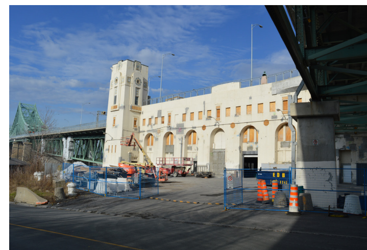
Fig. 324 : Le pavillon du pont, aujourd'hui utilisé comme surface d'entrepotage, 2015 WAA
