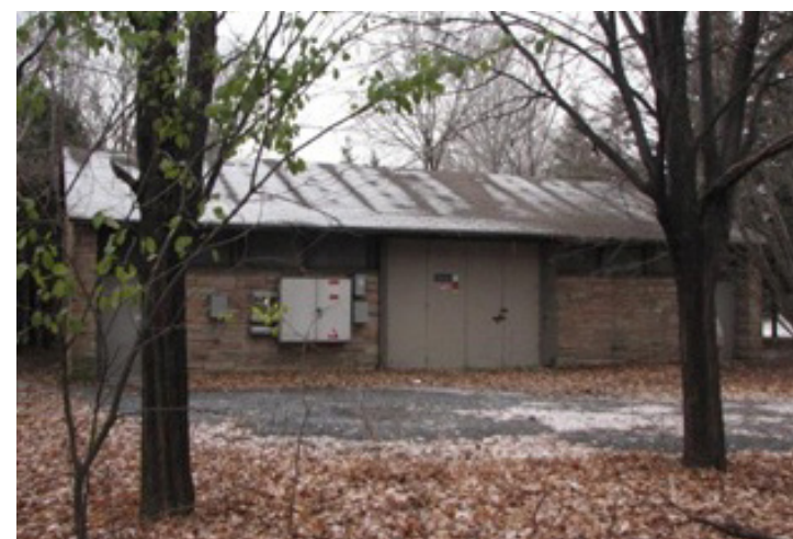
Fig. 177 : Façade arrière, ancien pavillon des pataugeoires, 2011 Ville de Montréal
