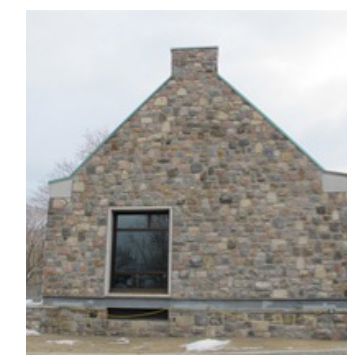
Fig. 277 : Mur latéral, 2016 L&S
