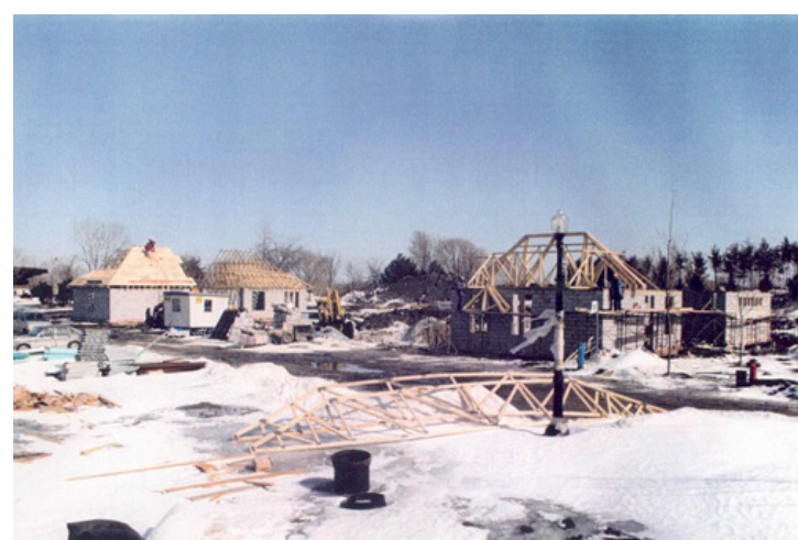
Fig. 84 : Construction des pavillons D39 et D40, [s.d.] Archives du service des grands parcs de la Ville de Montréal
