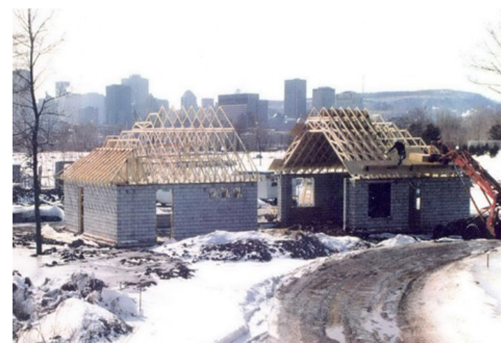
Fig. 79 : Construction du pavillon D39, [s.d.] Archives du service des grands parcs de la Ville de Montréal
