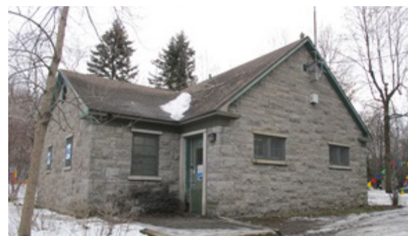
Fig. 198 : Vue d'ensemble, 2016 L&S
