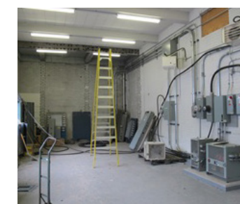
Fig. 335 : Vue d'ensemble intérieur, 2016. L&S
