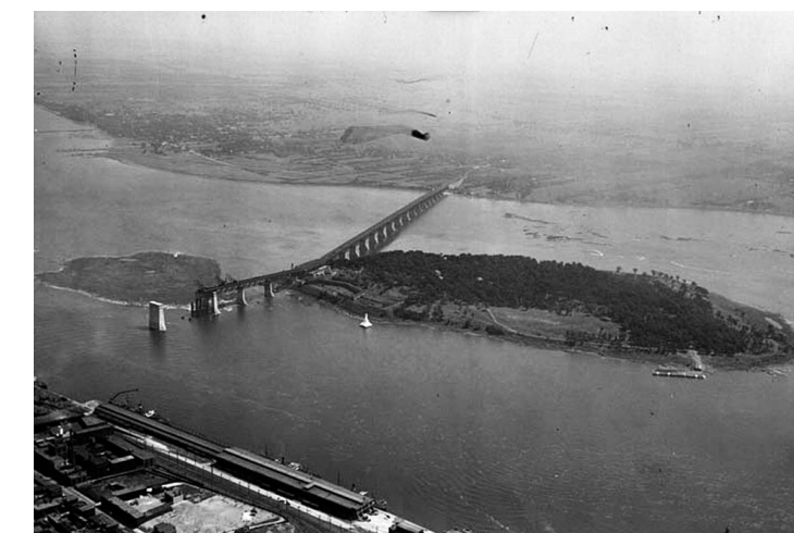
Fig. 325 : Construction du pont Jacques-Cartier, 1927 Archives de la Ville de Montréal
