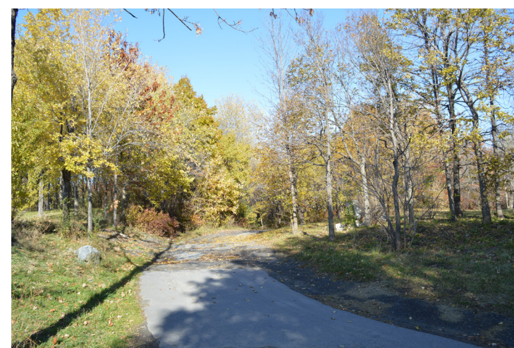
Fig. 107 : Certaines sections de sentiers sont asphaltées, 2015 WAA
