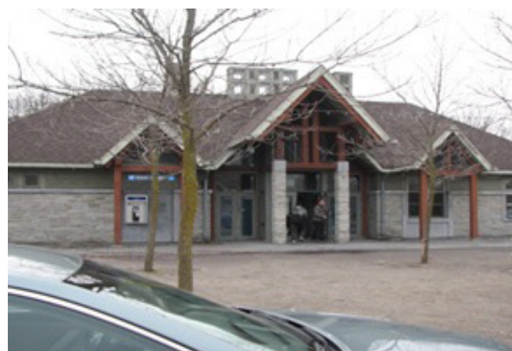
Fig. 78 : Façade principale pavillon D39, 2010 Ville de Montréal
