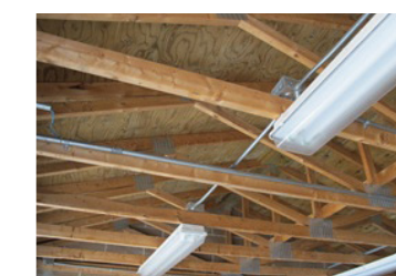
Fig. 172 : Vue d'ensemble (bâtiment D), 2016. L&S
