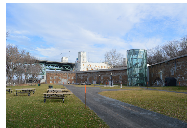
Fig. 295 : La cour du fort et entrée du musée Stewart, 2015 WAA
