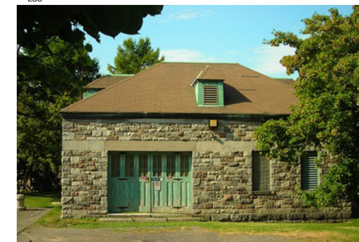
Fig. 151 : Vue d'ensemble et portes principales, 2010 L&S
