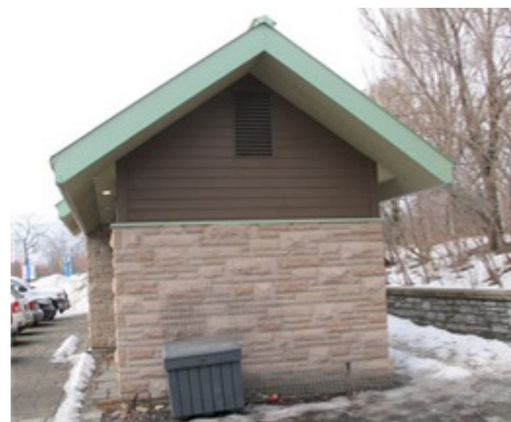
Fig. 94 : Façade latérale actuelle, 2016 L&S
