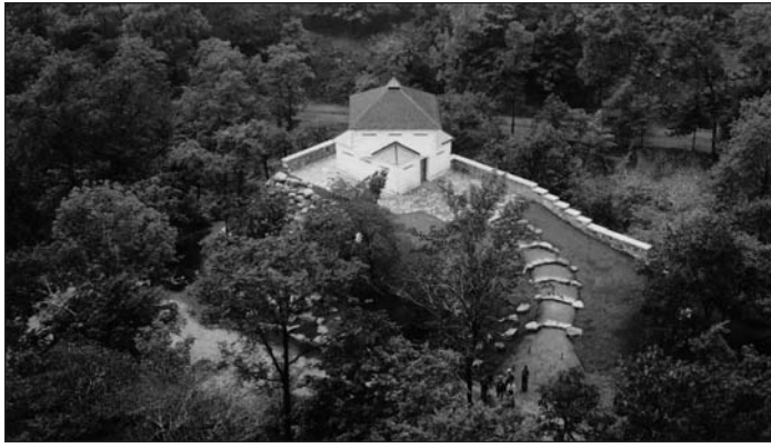
Fig. 31 Le blockhaus et sa terrasse en cours d'aménagement en 1937. Ce cliché est pris depuis la tour de Lévis également en construction à cette époque. Archives Ville de Montréal, 2 juillet 1937, Z-89-1
