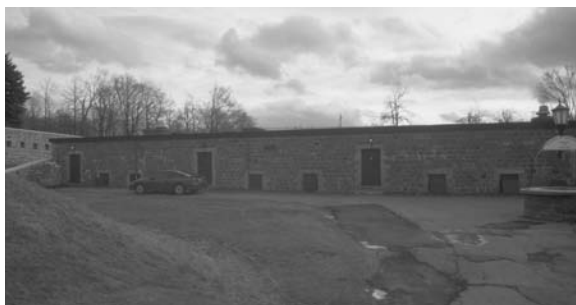
La caserne Photo : BfJ-84-2000D5.14
