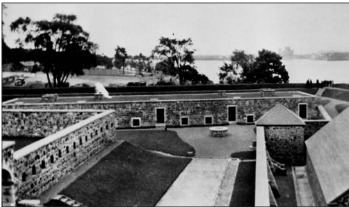
Fig. 23 Le secteur de la petite poudrière et de la caserne après restauration. Archives de la Ville de Montréal, photographe E. Stucker, 1939, z-1547-4
