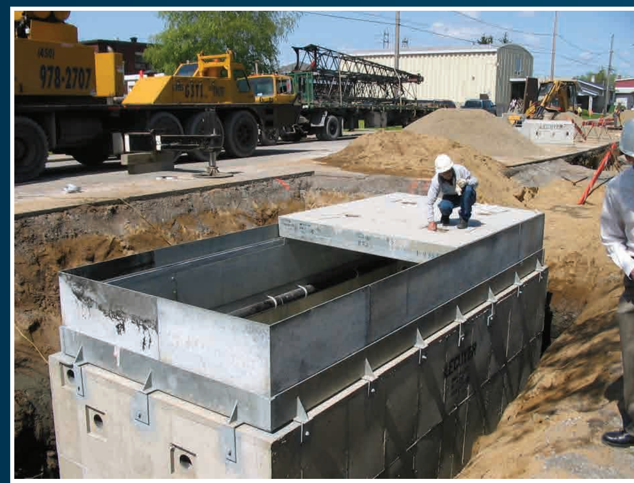
Étape 3 – Remblayage et installation du couvercle / réfection temporaire
