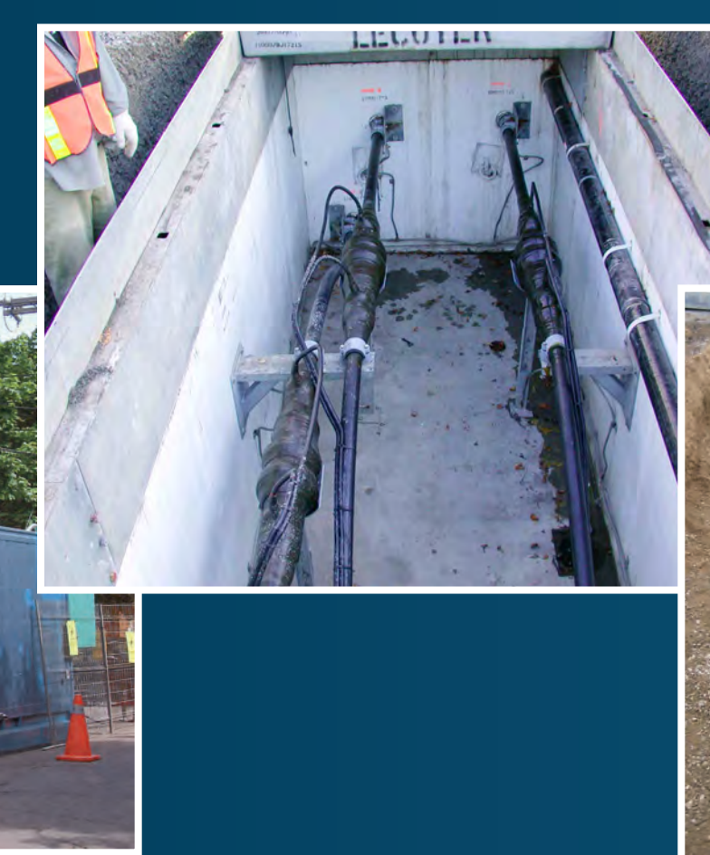
Étape 5 – Jointage des câbles, remblayage de la chambre et réfection des surfaces
