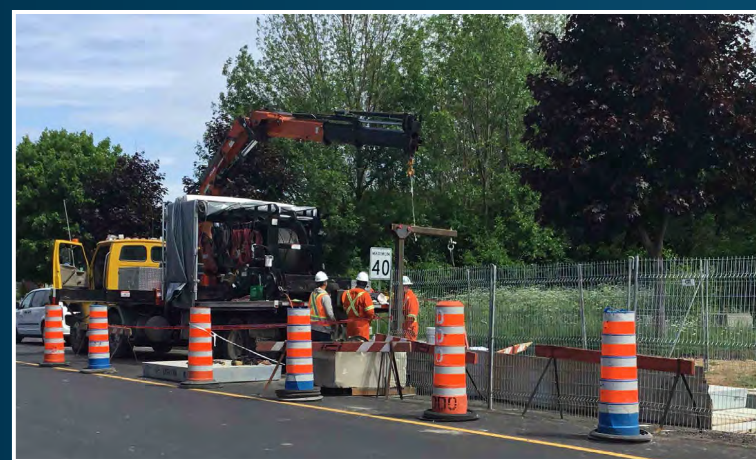
Étape 5 – Jointage des câbles, remblayage de la chambre et réfection des surfaces
