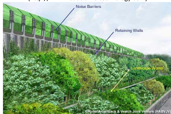
Figure 5. Le mur antibruit qui sera installé dans le projet d'autoroute Tolo and Fanling à Hong Kong ( http://www.roadtraffic-technology.com )
