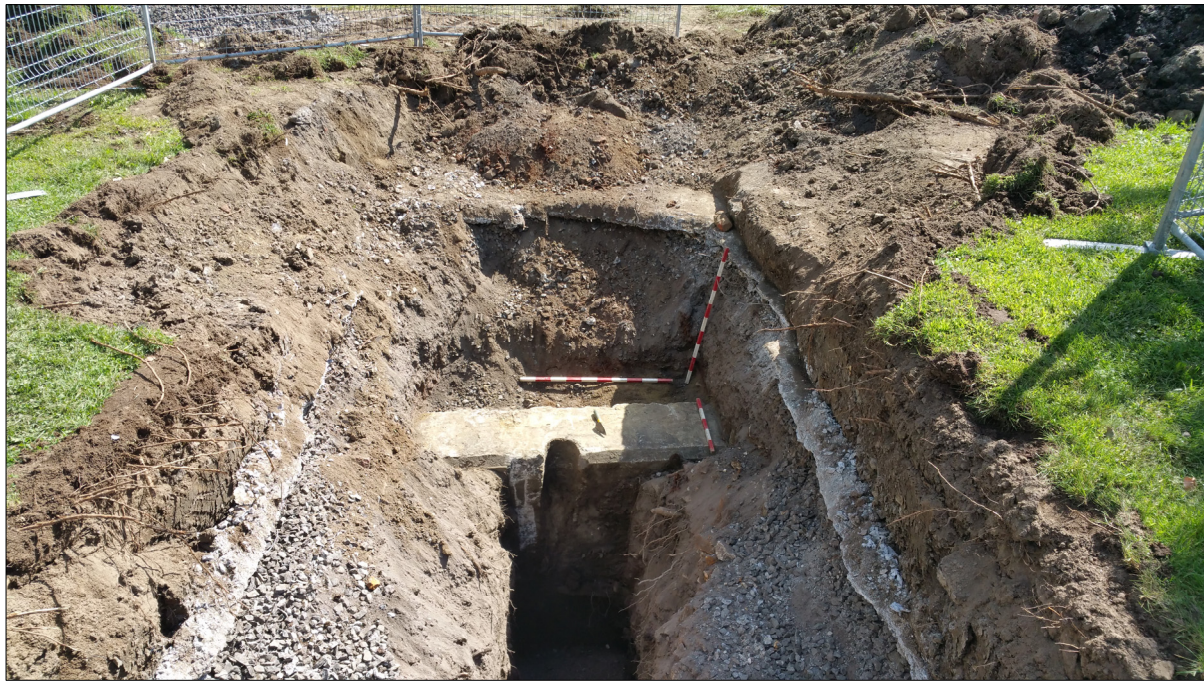
Photo 6 Mur sud du canal de fuite dans la sous-opération 1A, vue vers le sud (MTL16-23-1-NUM1-14)
