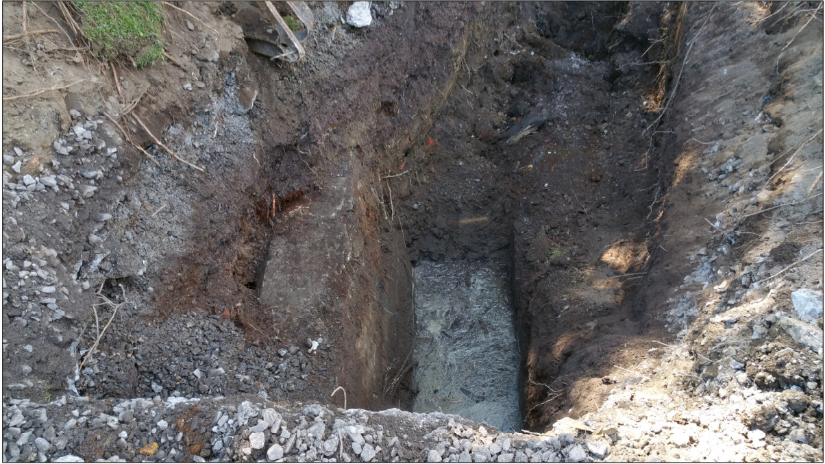
Photo 7 Mur nord du canal de fuite dans la sous-opération 1B, vue vers l'ouest (MTL16-23-1-NUM1-17)
