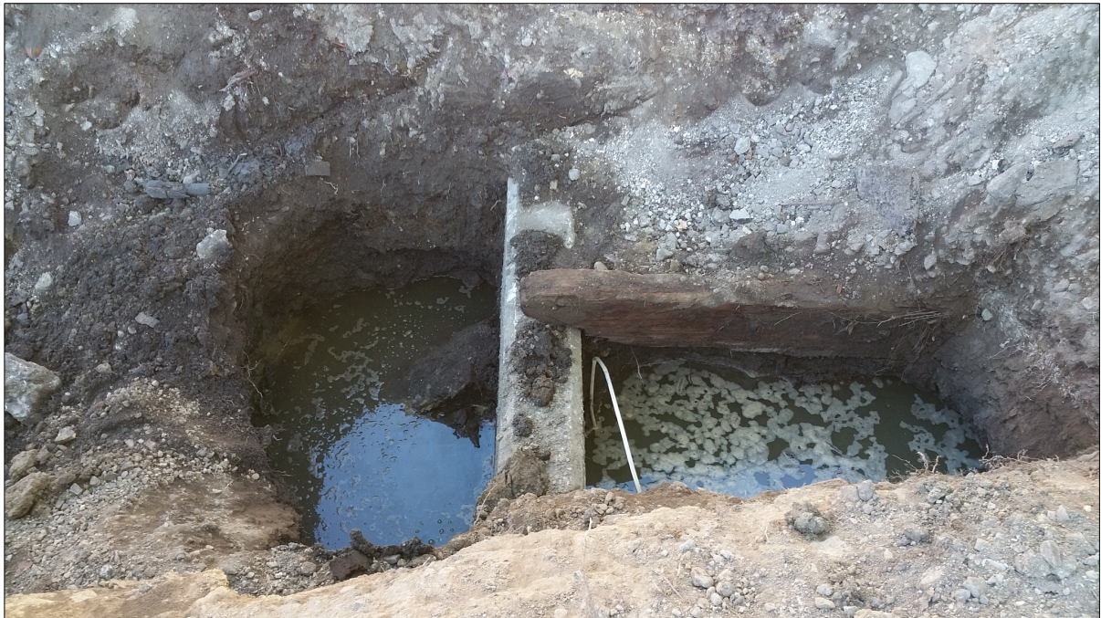
Photo 9 Mur du canal de fuite dans la sous-opération 1C, vue vers le nord-ouest (MTL16-23-1-NUM1-25)
