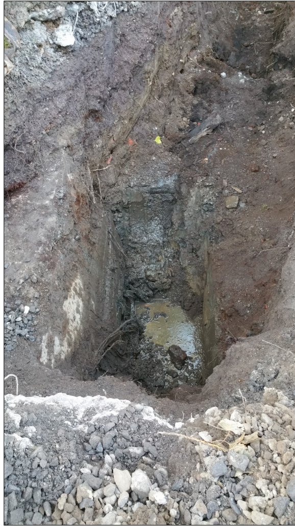
Photo 10 Tranchée de construction du mur nord du canal de fuite dans la sous-opération 1B, vue vers l'ouest (MTL16-23-1-NUM1-24)
