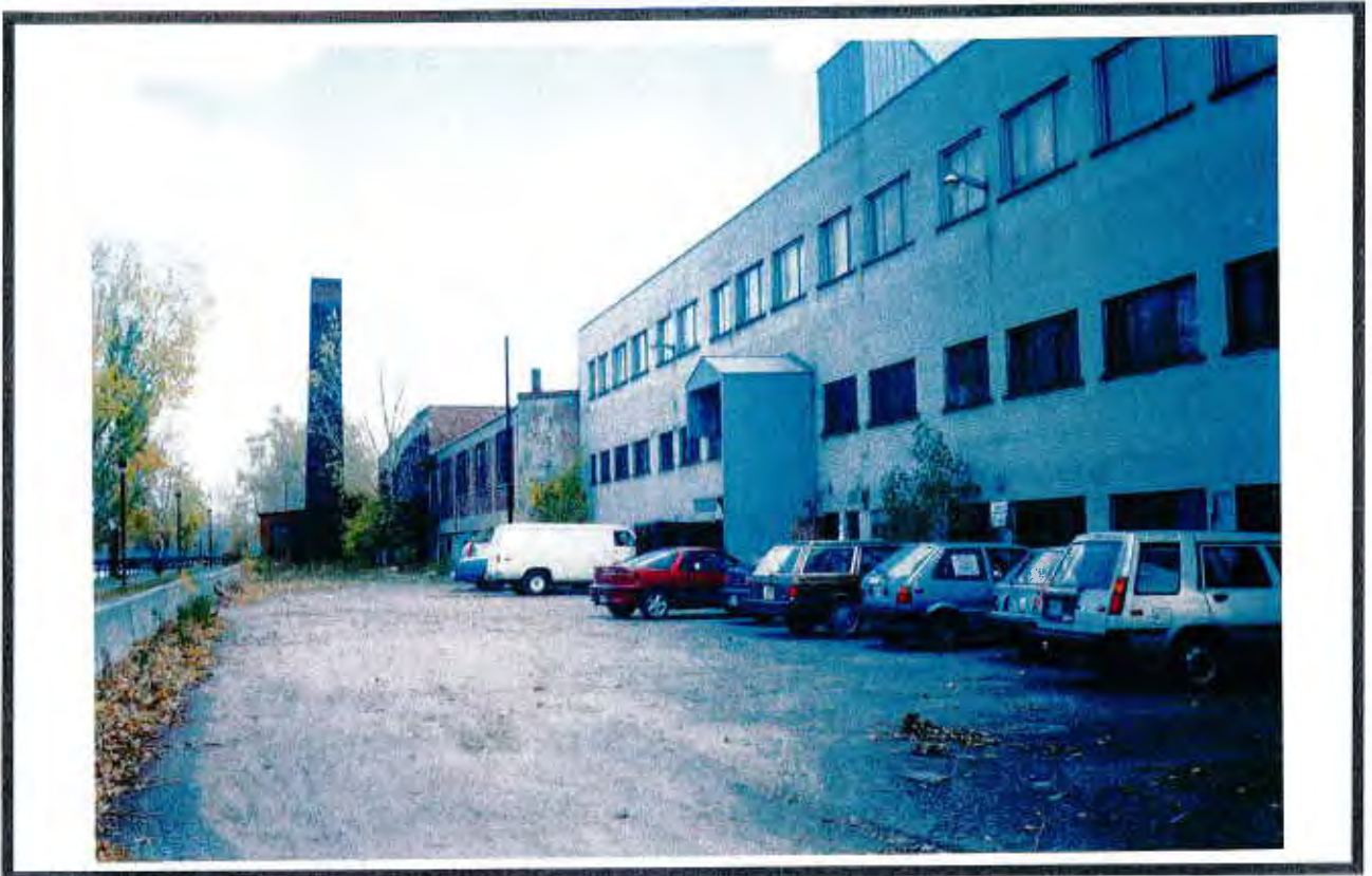
Planche # 3 : Vue de la façade Sud-Ouest (édifice A et D). On note la cheminée en brique adjacente à l'édifice D. Une partie de la piste cyclable du canal Lachine peut être observée à la gauche.
