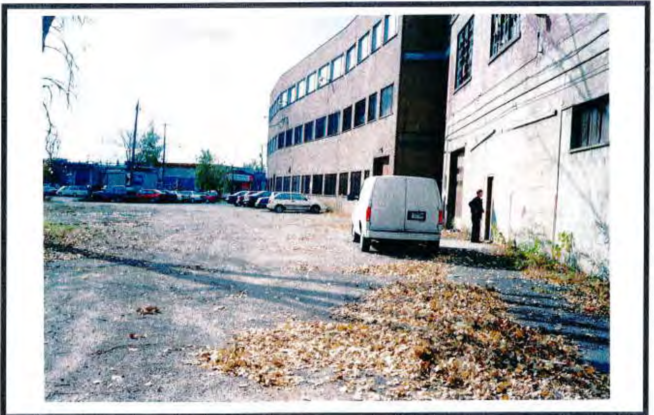
Planche # 2 : vue de la façade Sud-Est (édifice A et B).
