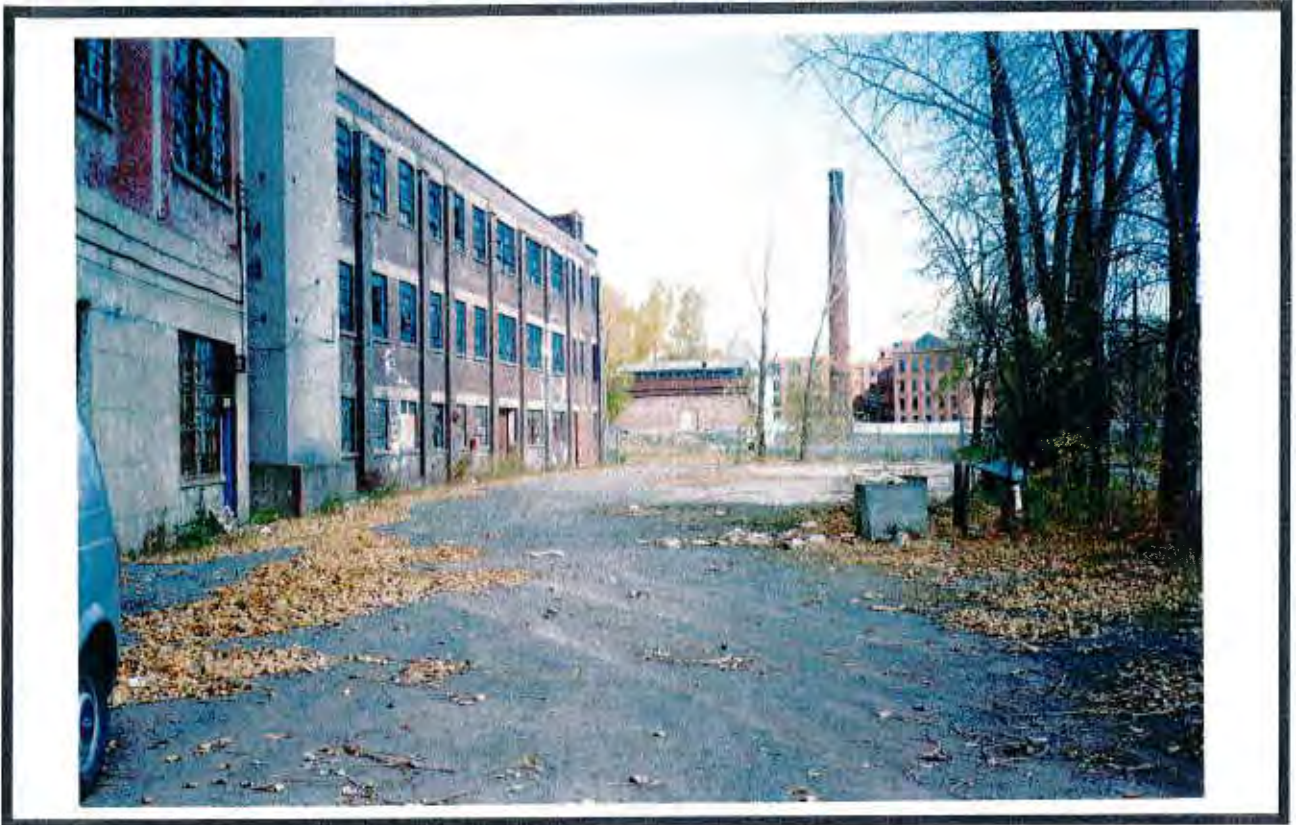
Planche # 1 - Vue de la façade Nord-Est (édifice B et C). On remarque la dalle de béton à droite
