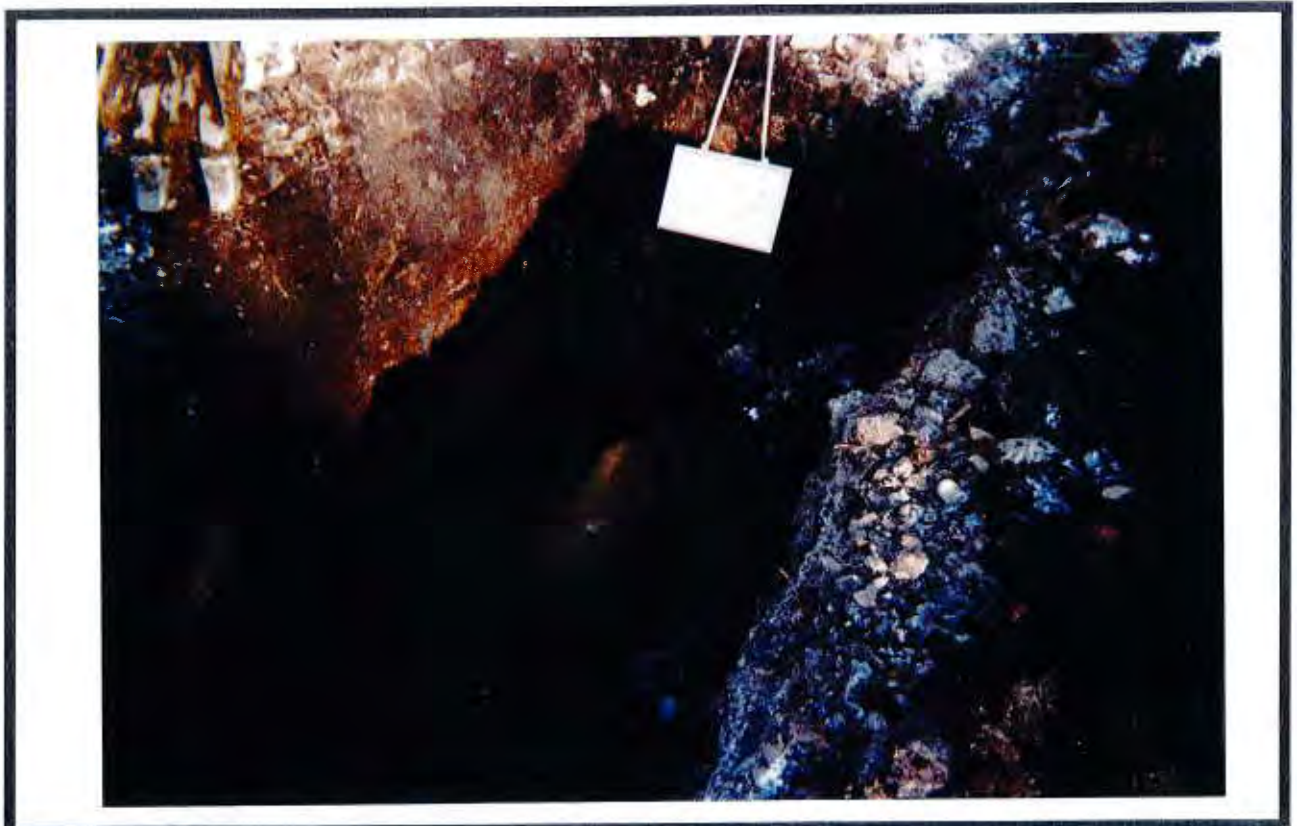
Planche # 9 : Vue du puits d'exploration PU-13. On observe le film huileux présent à la surface de l'eau.
