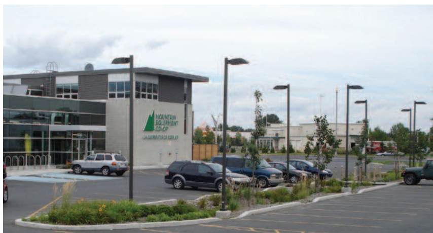
Le bassin de biorétention du Mountain Equipment Coop Photo : Vinci consultants
