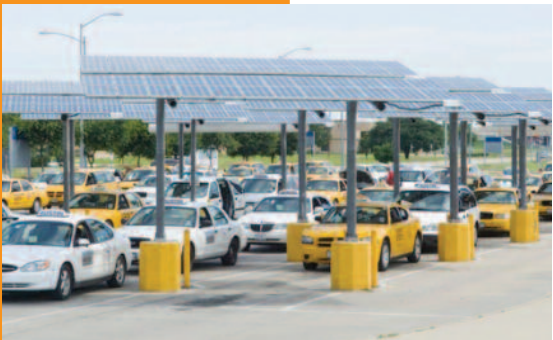
AUSTIN (Texas) - L'aéroport international Bergstrom Source : Meridian Solar
