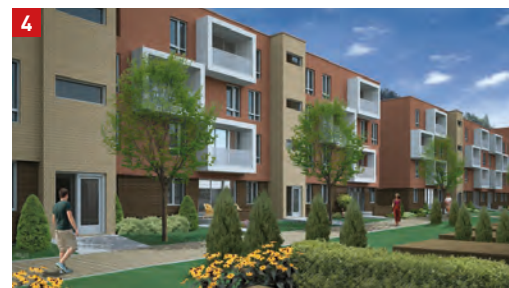
MAISONS DE VILLE DU PROJET ANGUS , AVENUE DU MONT-ROYAL DIRECTEMENT À L'OUEST DE L'ÎLOT CENTRAL
