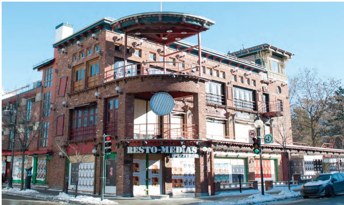
Façade Nord-Ouest du bâtiment 3. On remarque la présence importante des terrasses.
