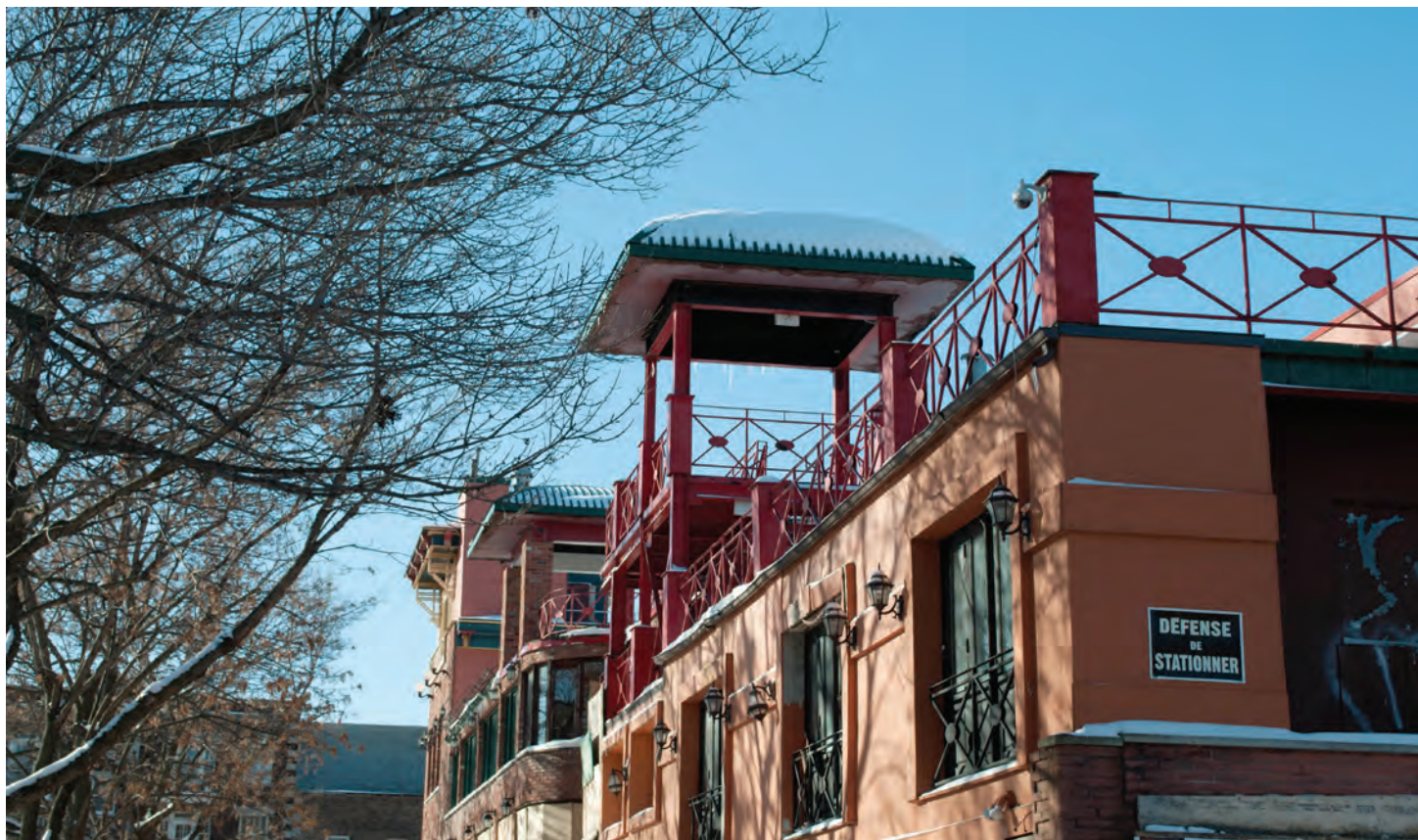
Façade arrière du Complexe Bourbon.
