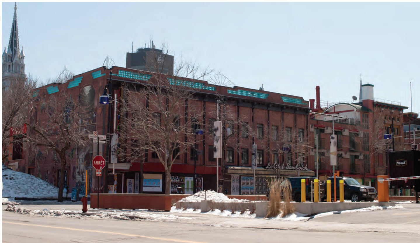
Vue du Complexe Bourbon. On remarque en avant-plan le stationnement de TVA, situé du côté Nord de la rue Saint-Catherine Est.
