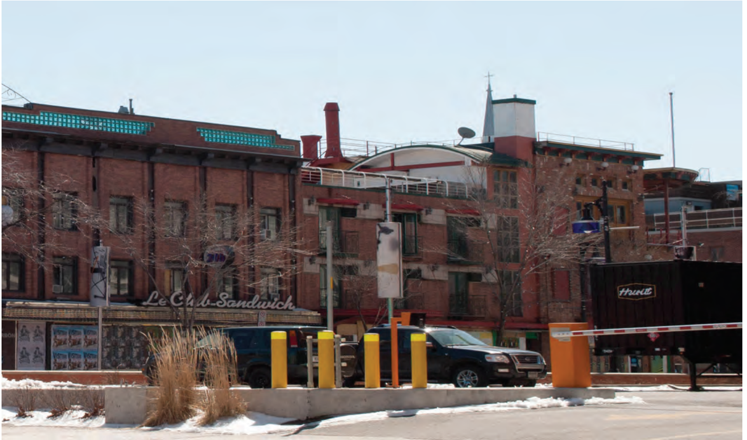
Façade Nord du bâtiment 2.
