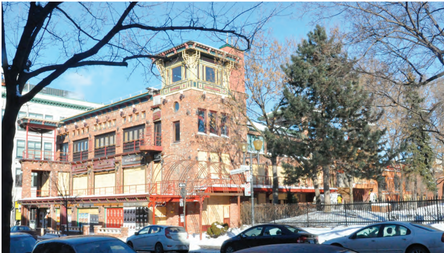
Façade Sud-Ouest du bâtiment 3. On remarque la continuité des terrasses de la façade Ouest à Sud.
