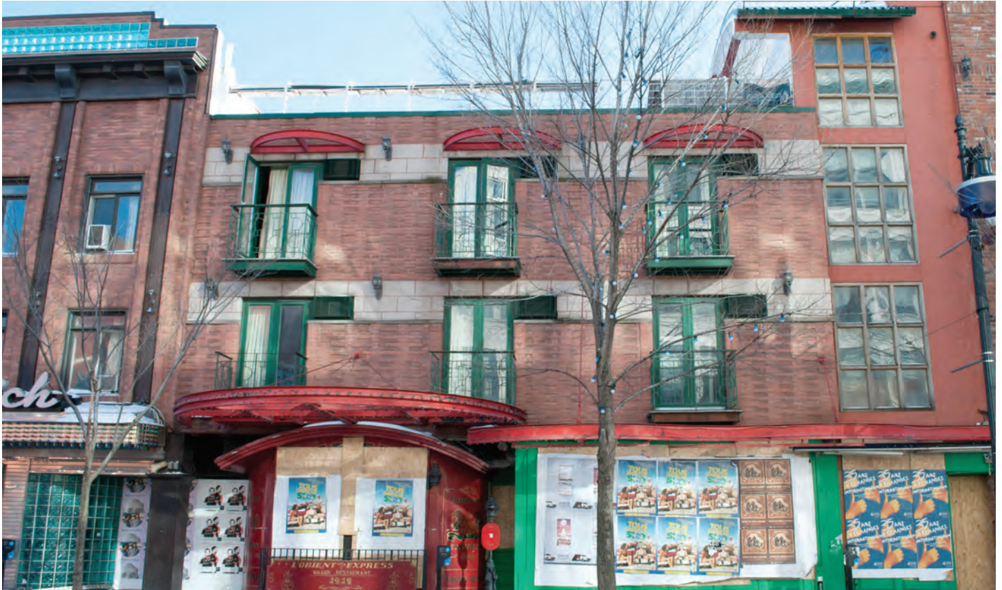
Façade Nord du bâtiment 2.
