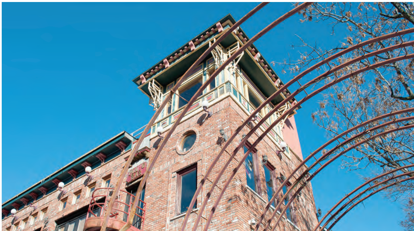
Vue de la tourelle et de la façade arrière du bâtiment 3.
