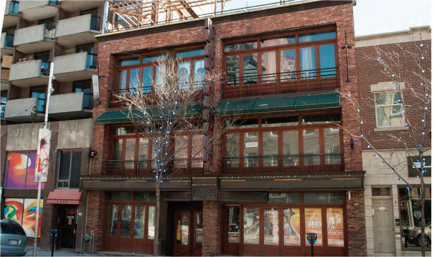
La façade Sainte-Catherine du Drugstore, bar qui appartenait anciennement à Normand Chamberland. On note certaines similarités (types d'ouverture, maçonnerie, utilisation du toit) dans l'architecture de ce bâtiment avec celui du Complexe Bourbon.
