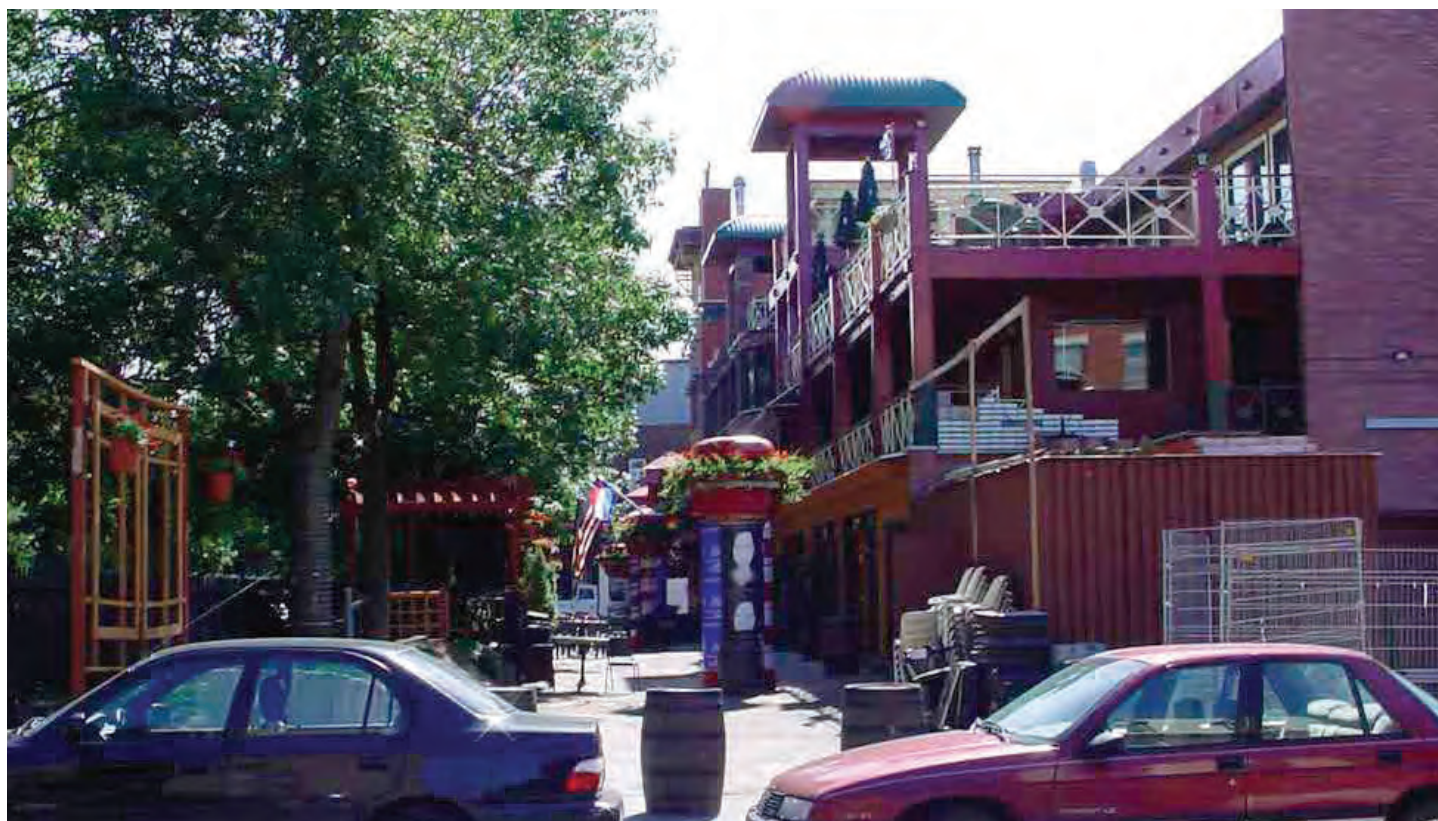
Aménagements de la rue Gareau. On peut notamment noter la fermeture de la rue et de l'utilisation de celle-ci comme terrasse, Dossier Simon Coquoz, date inconnue.
