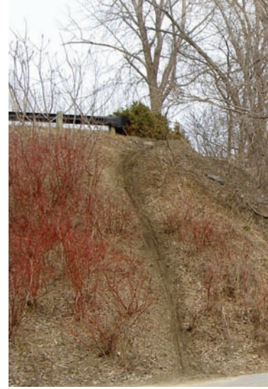
Dégradation causée par les vélos de montagne
