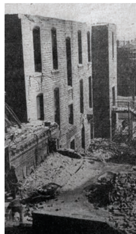
Démolition, Lyall-Mills, 1954 (source : inconnu)
