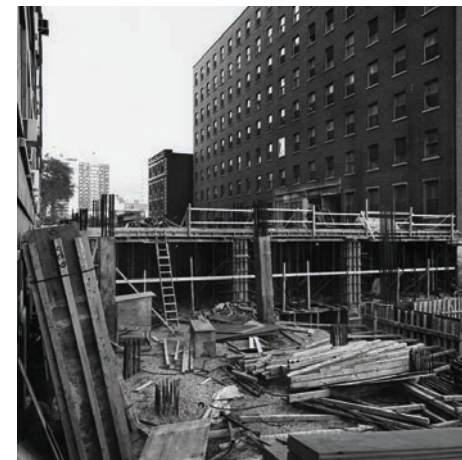
Construction, aile B, 1974 (source : Centre universitaire de santé McGill)
