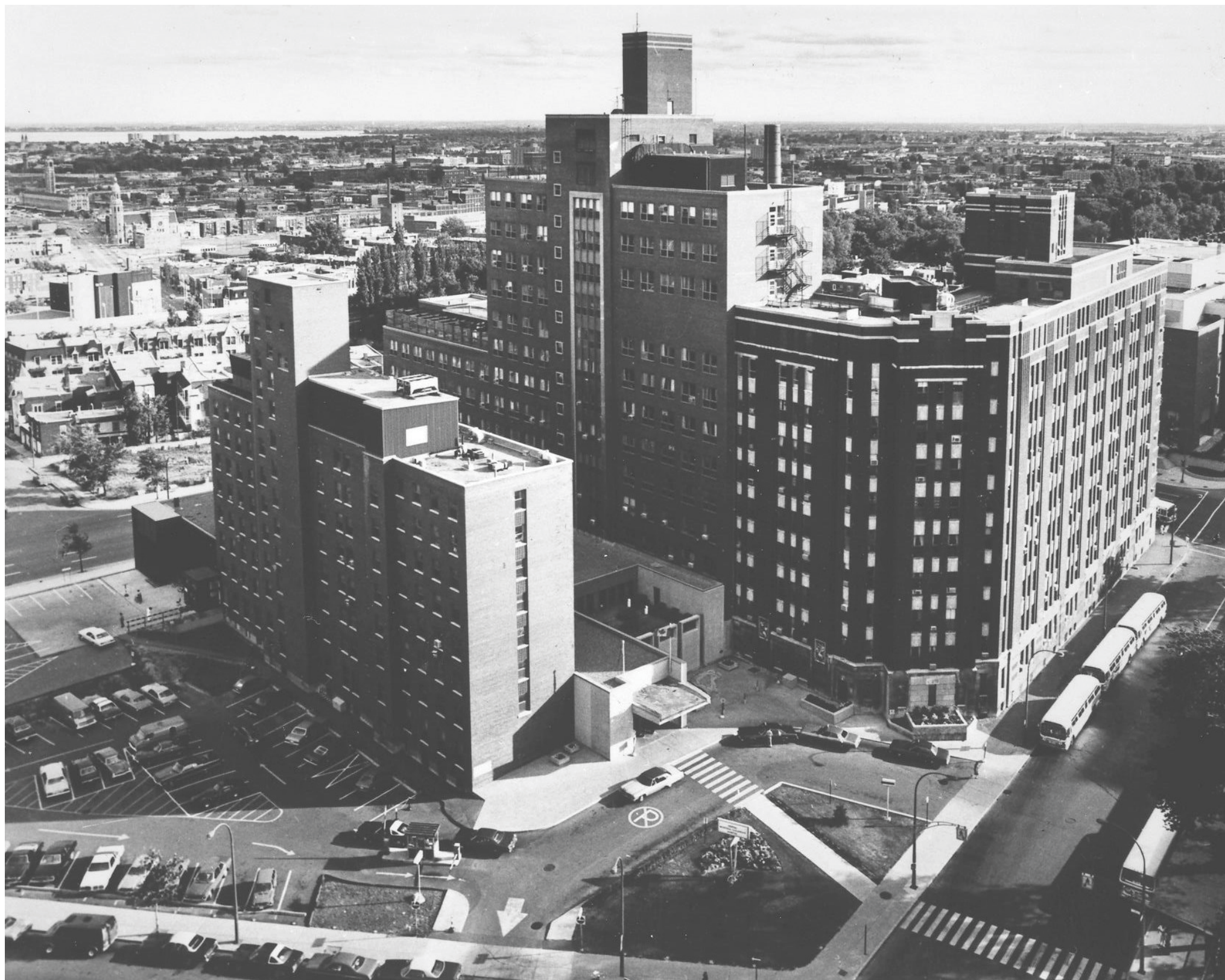
Vue du site, 1980 (source : Centre universitaire de santé McGill)
