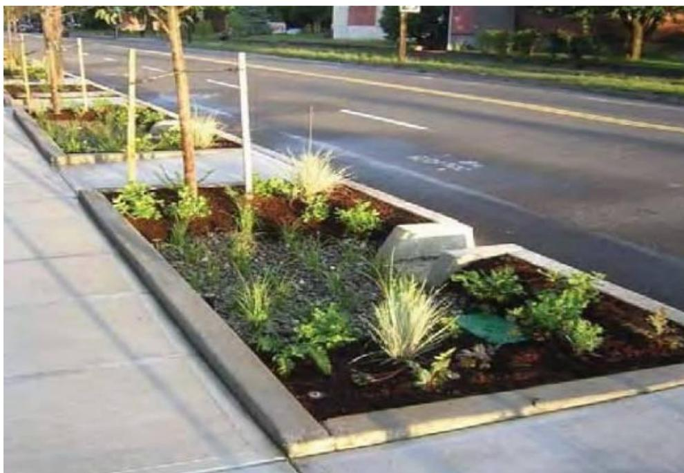
**Figure 16 Exemple d'application de bande filtrante**
