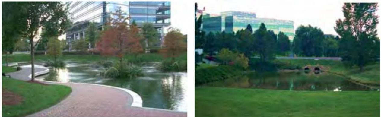
**Figure 6 Exemples de bassin de rétention avec retenue permanente (réf. figure 11.79 du Guide de gestion des eaux pluviales du MDDEFP, 2012)**
