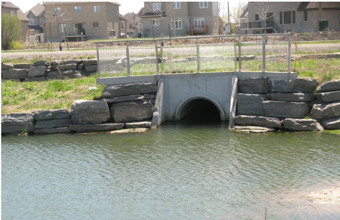
Figure 4 : Photo de l'émissaire pluvial de 1650 mm.
