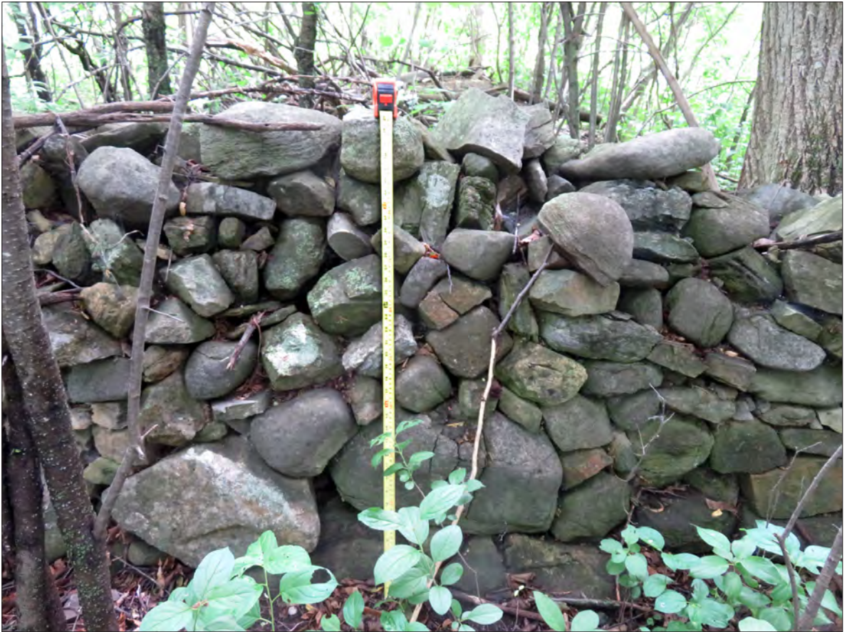
Figure 4.11 Portion du muret n°17 vue vers l'est
