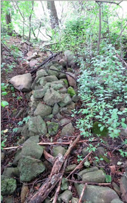
Figure 4.7 Muret n° 20 vu vers le nord Ce muret est en continuité du muret n° 17 (figure 4.4)
