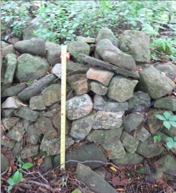
Figure 4.8 Muret n° 21, vu vers l'est Cette portion de muret est en continuité du muret n° 17
