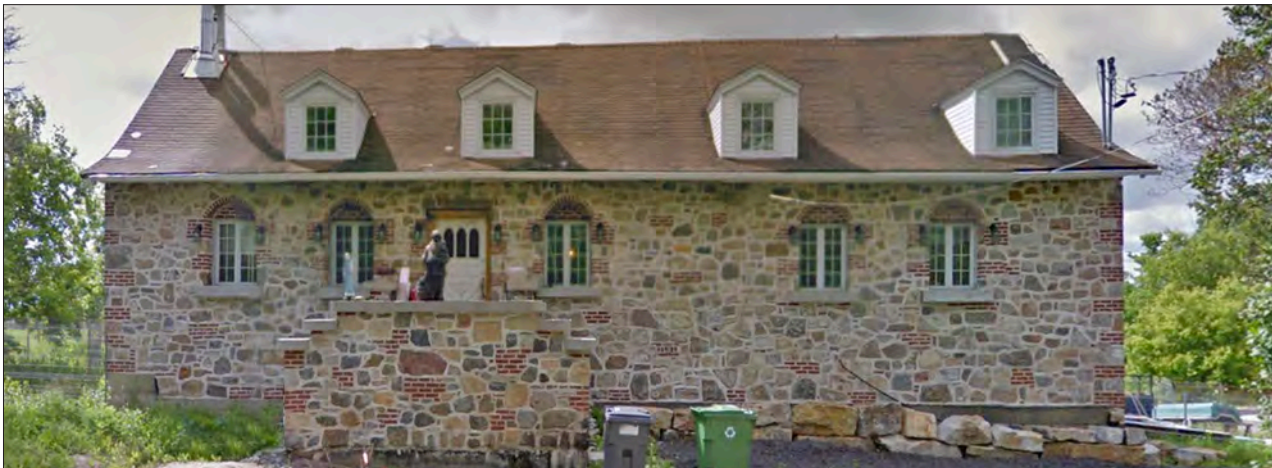
Figure 3.9 Résidence du 20452, boulevard Gouin Ouest
