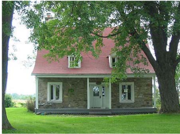
Le Petit Fort, 19 530 Boulevard Gouin Source : Grand répertoire du patrimoine bâti de Montréal
