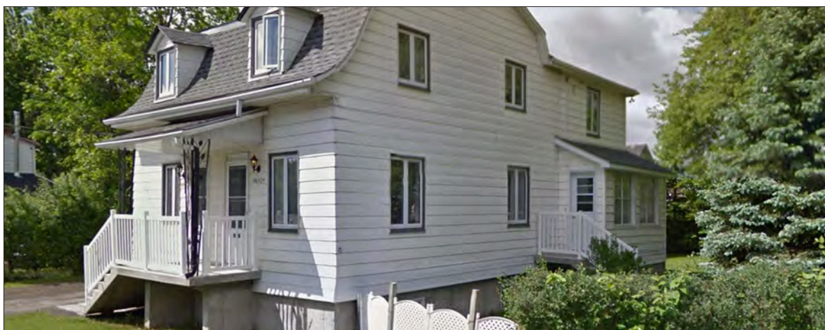
Figure 3.6 Résidence du 19622, boulevard Gouin Ouest
