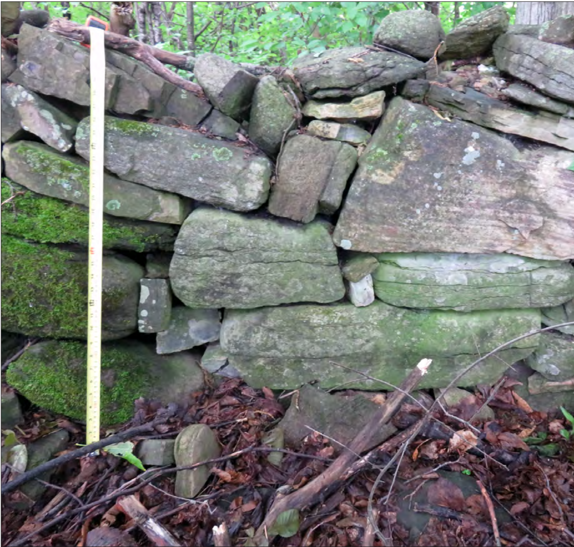
Figure 4.16 Vue rapprochée du muret n°17, vers l'est
