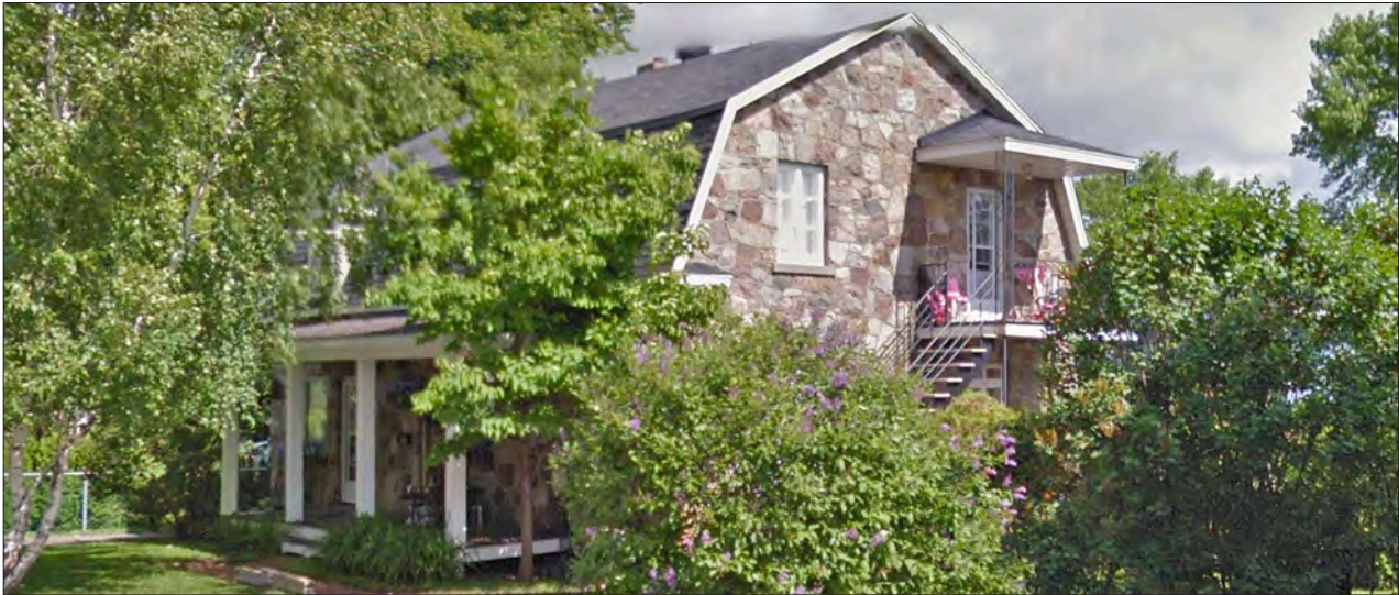
Figure 3.7 Résidence du 19715, boulevard Gouin Ouest
