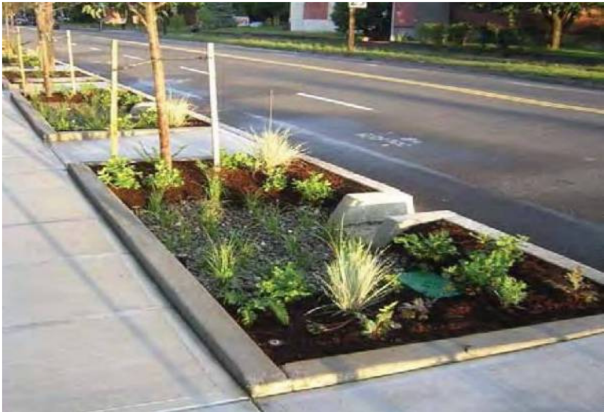
Figure 22 - Exemple d'application de bande filtrante
