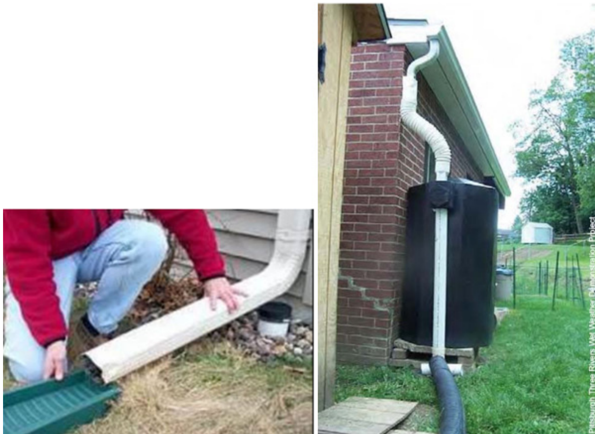
Figure 23 – Exemple de gestion des eaux de toit
