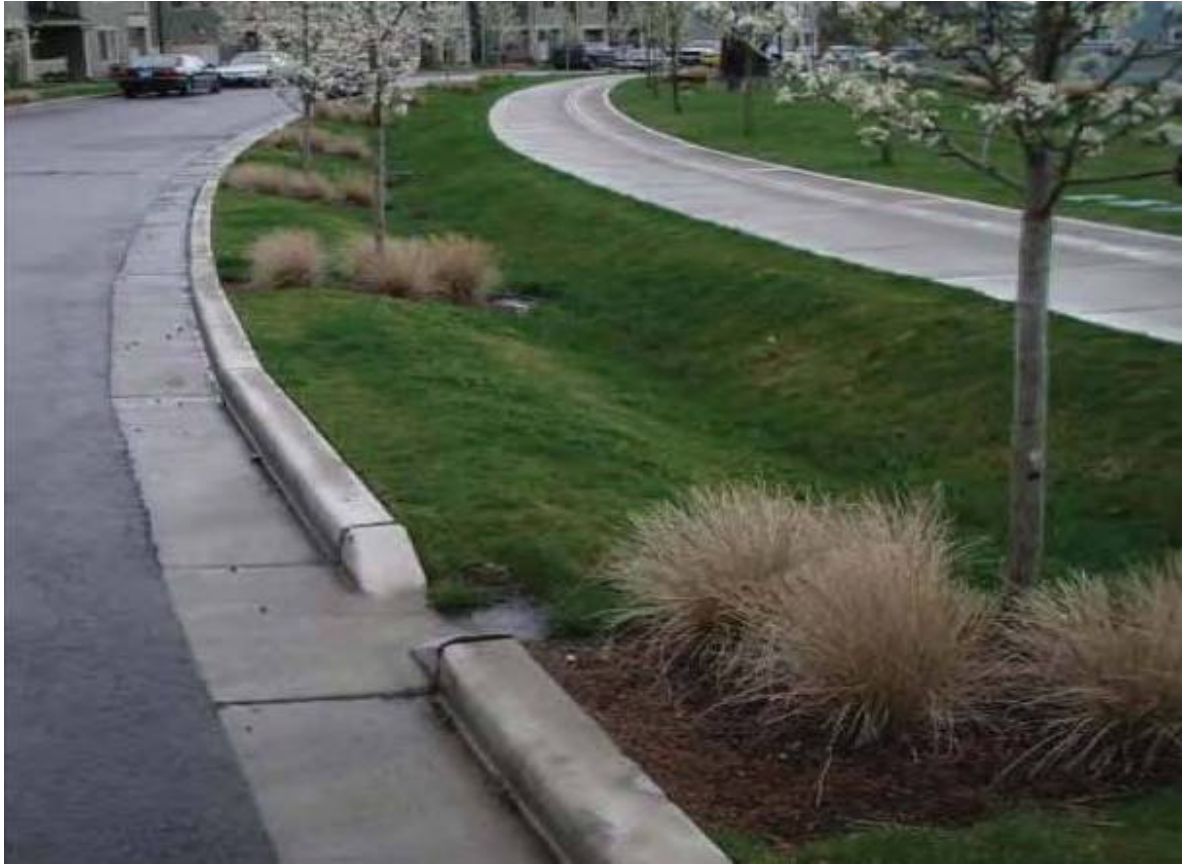
Figure 19 - Exemple d'application de noue
