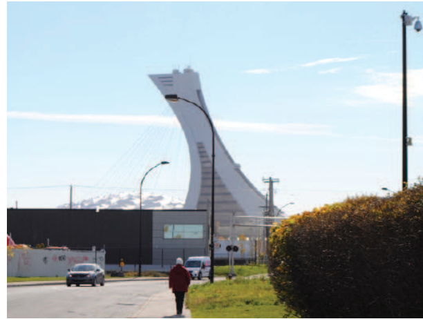
Vue du Stade olympique depuis la rue de Marseille
