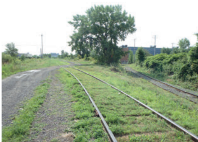
Les voies ferrées du CN, au niveau de l'avenue Pierre-De Coubertin.
