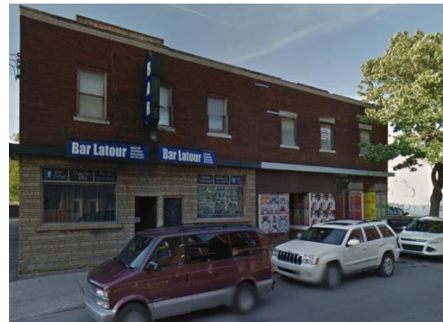
Bâtiments délabrés sur l'avenue De L'Église. Source : Google.
