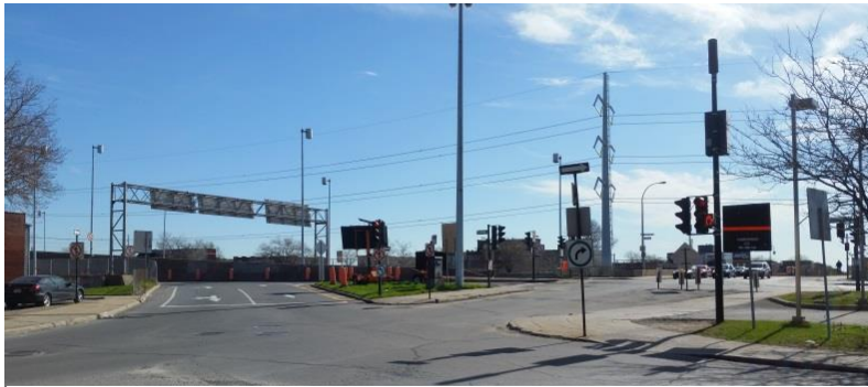
Mer d'asphalte rue de l'Église et Drake, près De La Vérendrye. Une des connections avec l'arrondissement de Verdun. Très dangereuse pour les piétons et cyclistes. De meilleurs aménagements sont de mise.
