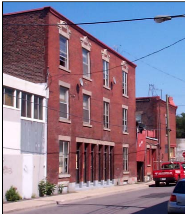
Fig. 2.5.1 : Deux triplex jumelés avec escalier intérieur et portes assemblées au centre, situés sur la rue Murray, entre les rues William et Ottawa. SO0085.
