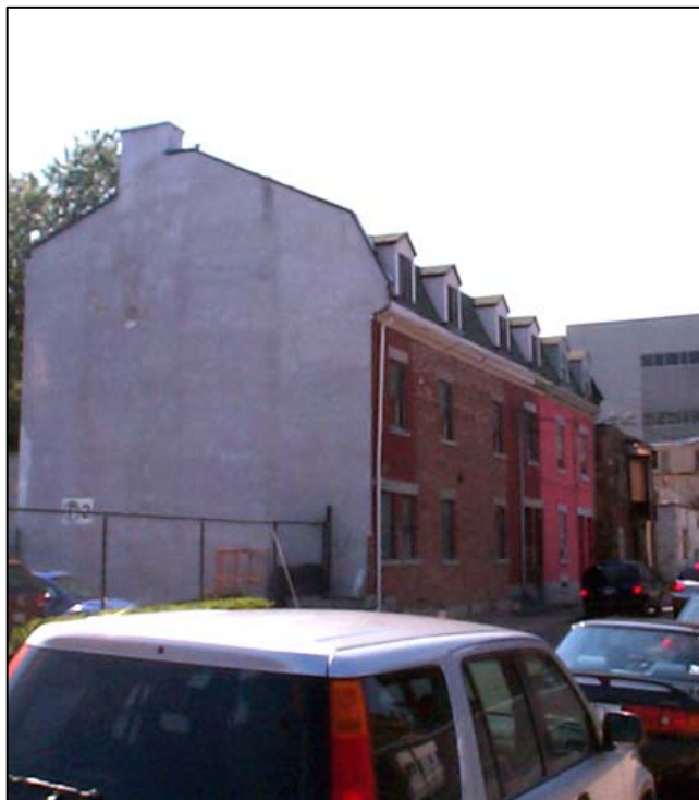
Fig. 2 : Duplex de trois étages à unités superposées sur la rue Young, entre les rues William et Ottawa. SO0090.
