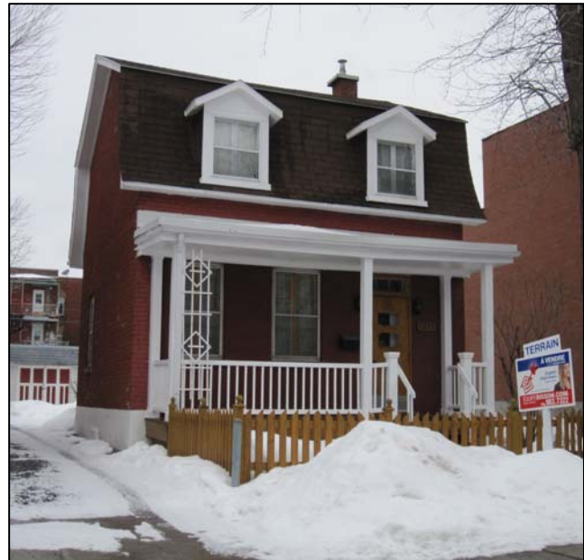
Fig. 5 : Maison villageoise à mansarde, située au 1871, rue Galt. UP3.5_Galt_1871.
