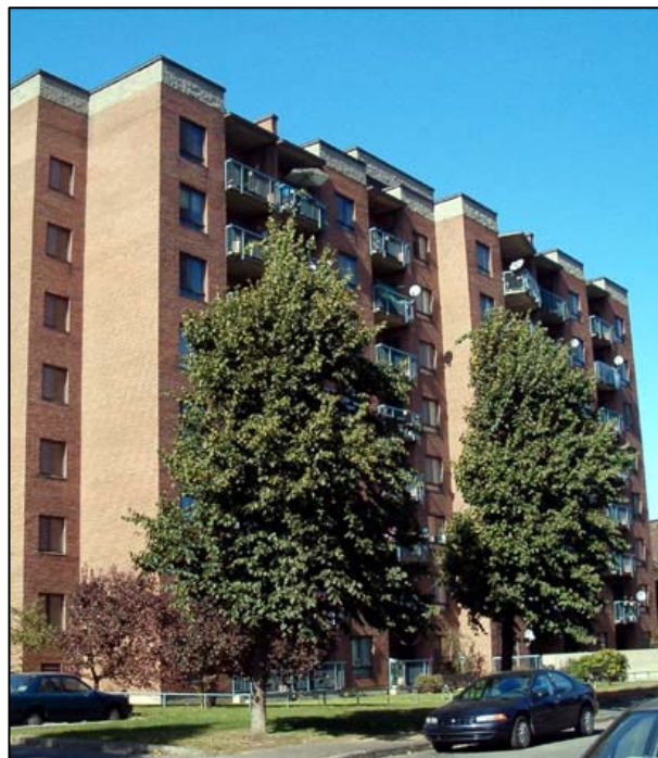
Fig. 3.3.2 : Immeuble d'appartements, Habitation Charlebois, 4450, rue Saint-Jacques. SO3051.
