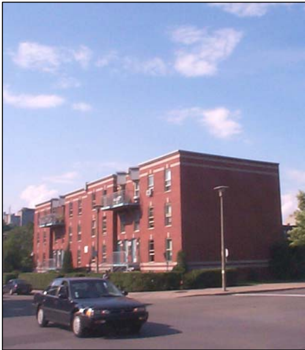
Fig. 3.2.1 : Conciergerie, située sur la rue Vinet, à l'intersection de l'avenue Lionel-Groulx. SO0225.
