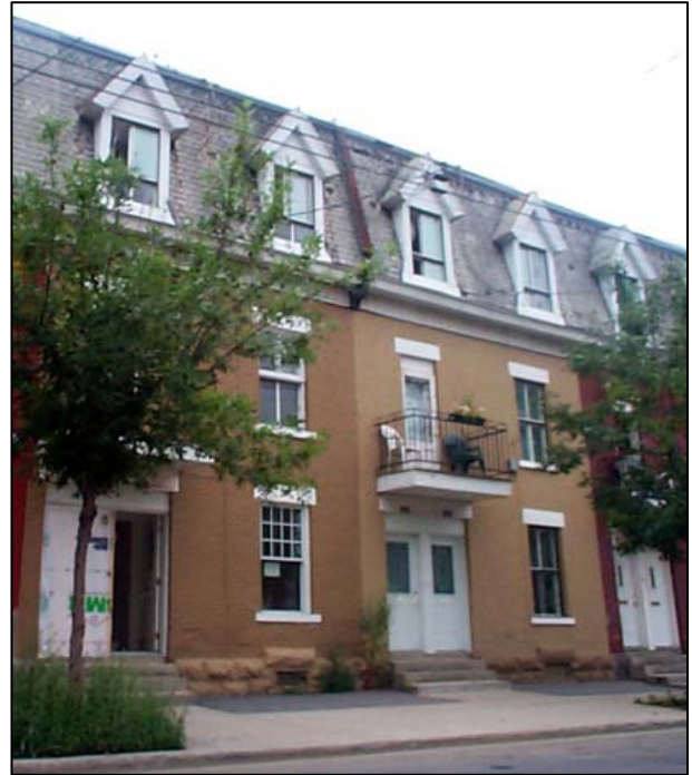
Fig. 2.4.1 : Duplex de trois étages sans marge de recul avant, situé sur la rue d'Hibernia, entre les rues de Coleraine et de Rozel, SO0200.
