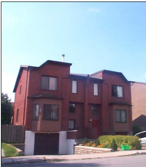
Fig. 1.5.1 : Maisons de ville situées sur la rue Lacroix, entre les rues Allard et Springland. SO0344.
