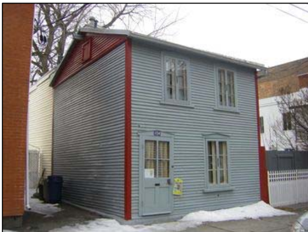
Maison villageoise à deux étages et demi dont les façades sont revêtues de planches à clins. Elle a également conservé des ouvertures traditionnelles en bois. UP4.1_Rose-de-Lima_124 (2).
