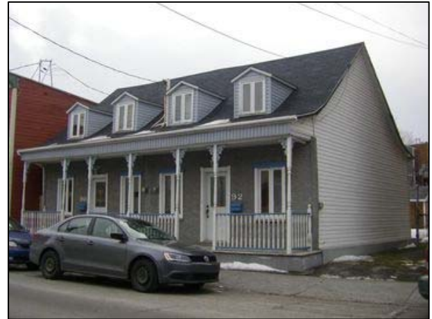
Maison villageoise jumelée dont la volumétrie est typique. La galerie occupe toute la largeur du bâtiment et la composition est symétrique. UP4.9_Ste-Margueritte_90-92 (2).
