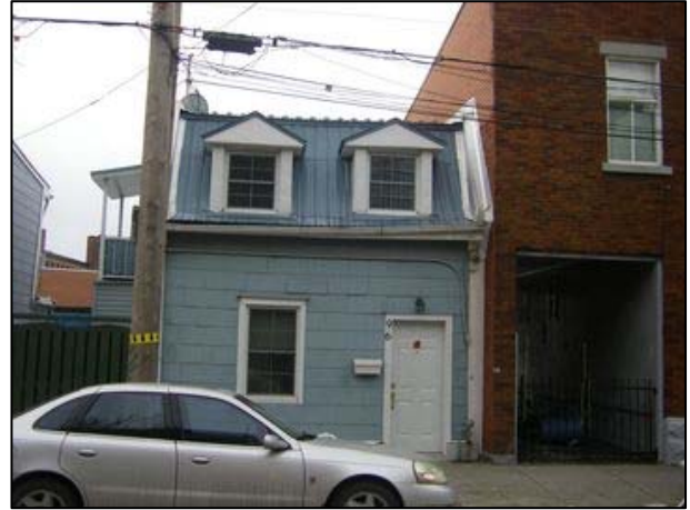
Modeste maison villageoise à toit en mansarde. UP4.1_St-Augustin_96.
