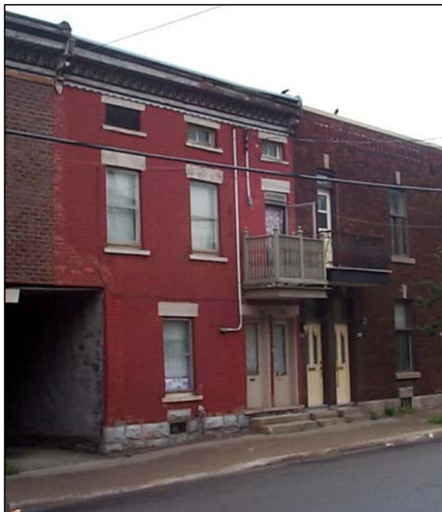
Fig. 3 : Duplex avec escalier intérieur situé sur la rue de Châteauguay, à l'intersection de la rue Roper. SO0148.
