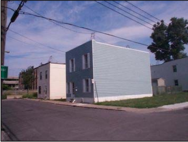
Maison villageoise à toit plat sur la rue Bourassa. UP4.14_Bourassa_705-713.
