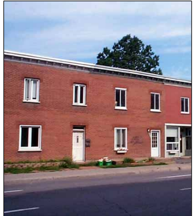
Fig. 2.1.6: Variante 3, maisons en rangée construites simultanément, situées sur la rue Saint-Antoine Ouest, à l'intersection de la rue du Couvent. SO0011.
