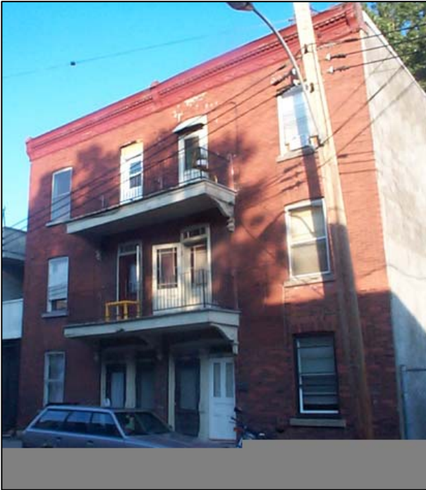
Fig. 2.5.2 : Variante 1, triplex avec escalier intérieur et entrée commune pour les logements supérieurs (bâtiment jumelé) situé sur la rue Sainte-Émilie, entre les rues Turgeon et Bourget. SO0119.
