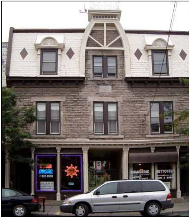
Fig. 4.1.1 : Immeuble à vocation mixte. Édifice O.-Labelle, 2463-2473, rue du Centre, entre les rues Ropery et Charlevoix. SO1706.
