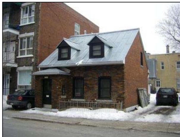
Maison villageoise typique au 727, rue Lacasse. La marge de recul avant est limitée et un accès latéral permet un accès à la cour arrière. UP4.7_Lacasse_727.
