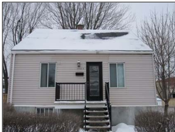
Façade légèrement asymétrique. UP3.7_Jolicoeur_1725.
