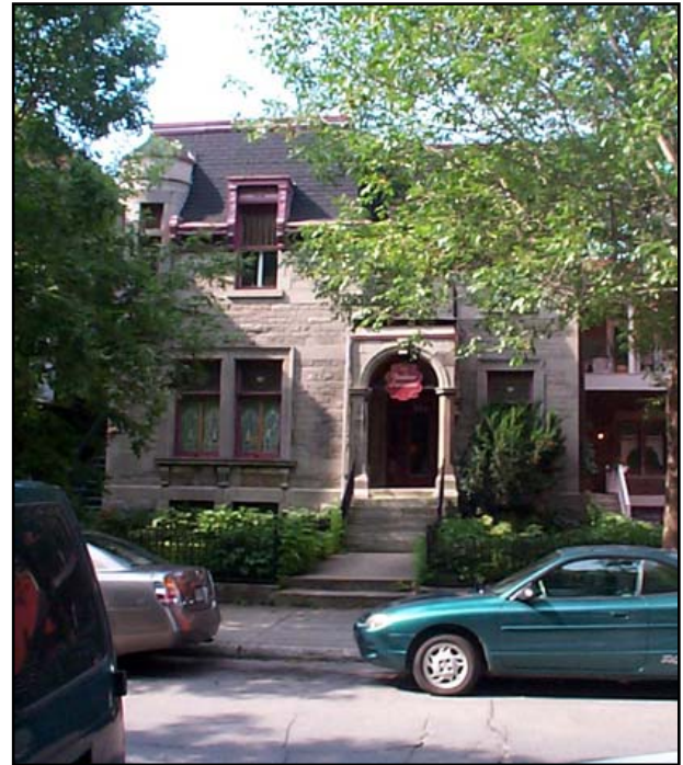
Fig. 1.2.5 : Maison urbaine à trois alignements verticaux, 846, rue Agnès. SO0004.
