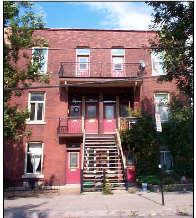
Fig. 2.6.5 : Triplex avec escalier extérieur jumelé, situé du côté est de la rue Desnoyers, à l'intersection de la rue Cazalais. SO0409.
