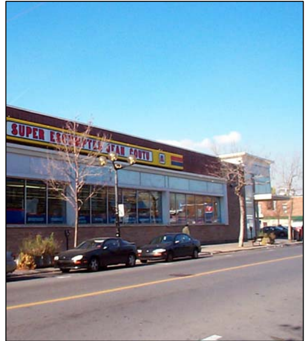
Fig. 5.1.2 : Bâtiment du boulevard Monk, entre les rues Allard et Springland. SO3638.
