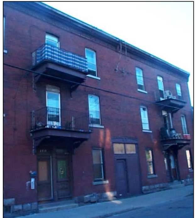
Fig. 2.5.4 : Variante 3, triplex avec escalier intérieur et porte cochère, situé sur la rue Sainte-Émilie, entre les rues Turgeon et Bourget. SO0120.
