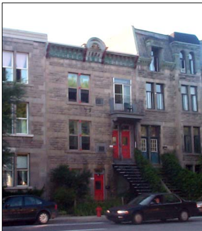
Fig. 7 : Triplex avec escalier extérieur, situé sur l'avenue Egan, entre le boulevard De La Vérendrye et la rue Laurendeau. SO0254.
