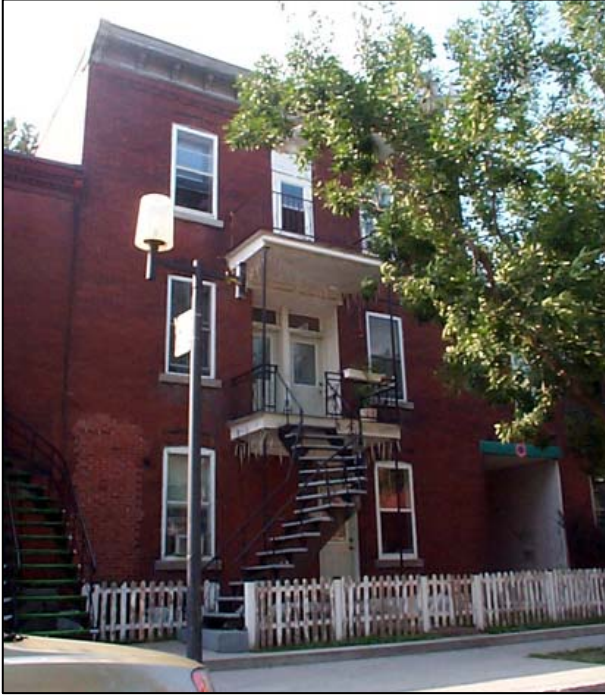
Fig. 2.6.3 : Triplex symétrique, situé sur la rue York, à l'intersection de la rue De Roberval. SO0405.
