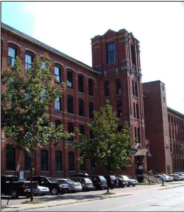
Fig. 6.1.1 : Merchants Manufacturing Co., 4000-4020, rue Saint-Ambroise, entre les rues Saint-Augustin et Louis-Cyr. SO1589.
