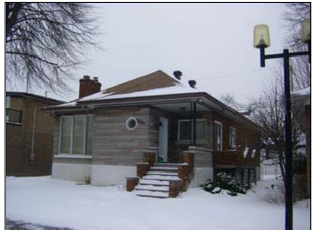
Escalier et porche forment les seules saillies. UP3.8_Hadley_6951.
