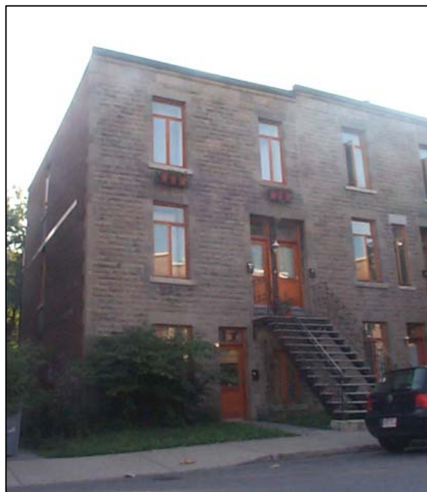
Fig. 2.6.2 : Triplex asymétrique, situé sur l'avenue Greene entre les rues Saint-Antoine Ouest et Saint-Jacques. SO0110.
