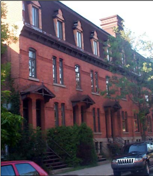
Fig. 2.4.2 : Duplex de trois étages avec marge de recul avant, situé au 2225-2247, rue Quesnel. SO0690.
