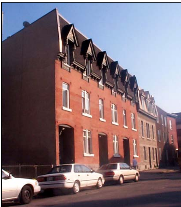
Fig. 2.4.5 : Variante 1, duplex de trois étages avec porte cochère, situés au 6837-6843, rue Laurendeau, à l'intersection de l'avenue Clifford. SO0247.
