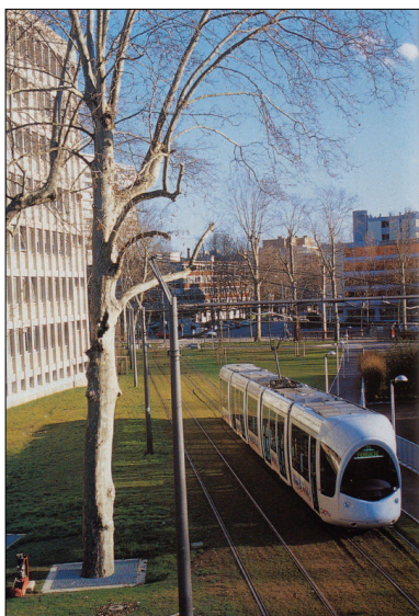
Emprise verte du tramway de Lyon
