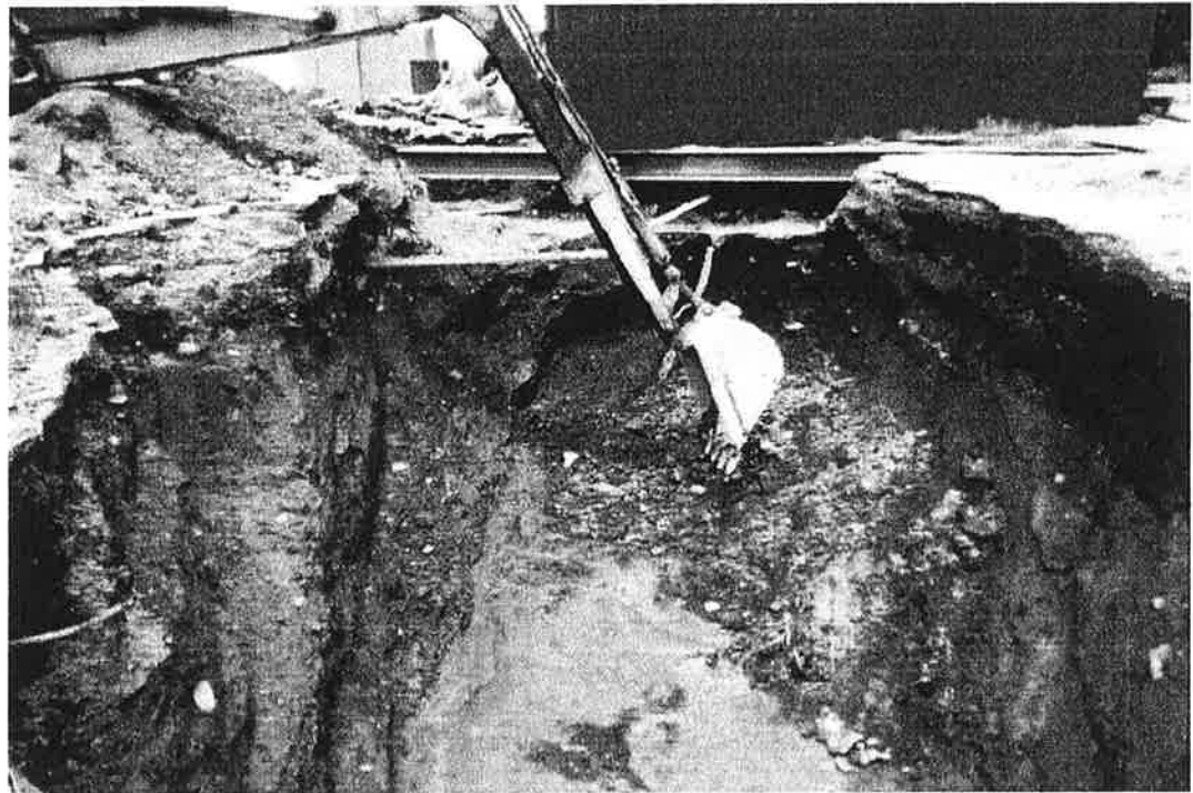
Photographie 3: Aperçu du forage F-4, à proximité du bâtiment de la génératrice et de la fosse de l'ancien réservoir d'essence.
