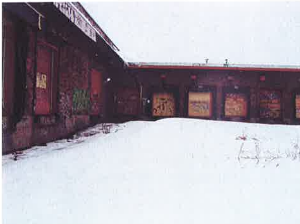
Photo 5 : Vue des quais de chargement sur le coin sud-est du bâtiment.
