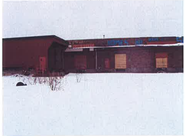
Photo 4 : Vue du coin sud-ouest du bâtiment.
