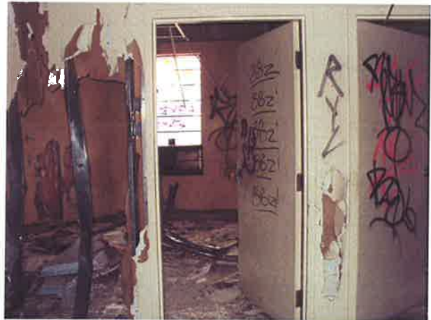
Photo 10 : Vue de l'état actuel des bureaux.
