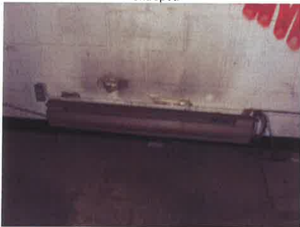
Photo 9 : Vue d'une plinthe électrique dans le bâtiment
