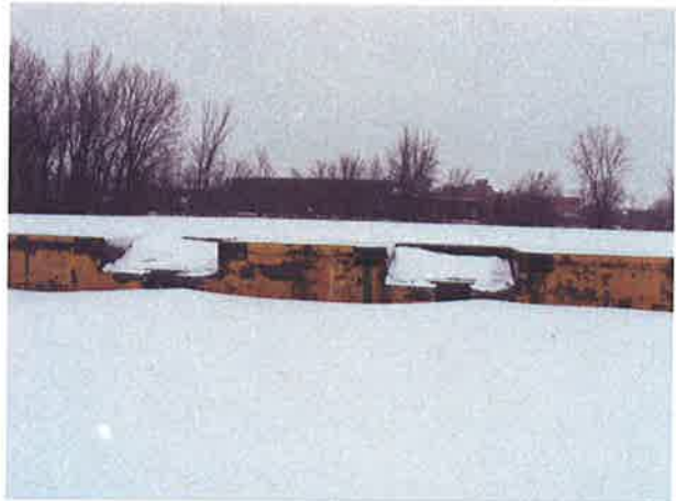
Photo 2 : Vue la dalle de béton laissée en place après les travaux de démolition.
