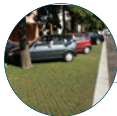
STATIONNEMENT AVEC UN REVÊTEMENT PERMÉABLE.
