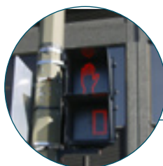
FEU POUR PIÉTONS À DÉCOMPTE NUMÉRIQUE.
