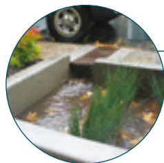
AVANCÉE DE TROTTOIR AVEC FOSSE DE RÉTENTION DES EAUX DE PLUVIALES.
