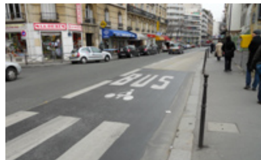
Voie réservée pour autobus combinée à une voie cyclable. Paris, France.
