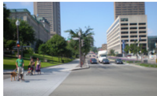
Feu pour piétons à décompte numérique, marquage distinctif des passages pour piétons et terre-plein central avec refuge pour piétons. Boulevard René-Lévesque, Québec.
