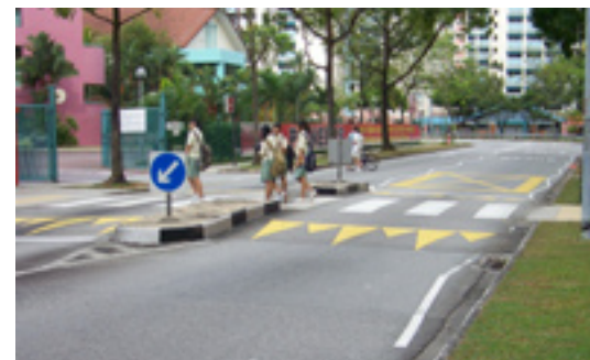
Passage pour piétons surélevé. Singapour.
