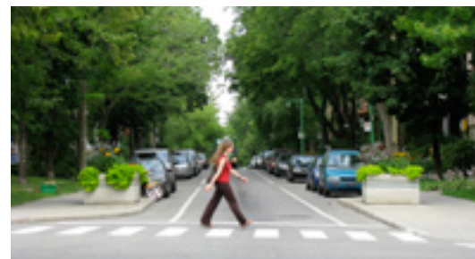
Avancée de trottoir réduisant la distance à traverser et permettant l'implantation de bacs à fleurs. Rue Davaar, Montréal.
