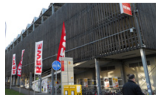
Stationnement étagé pour véhicules et stationnement à vélos adjacent à une gare de tramway. Vauban, Allemagne.
