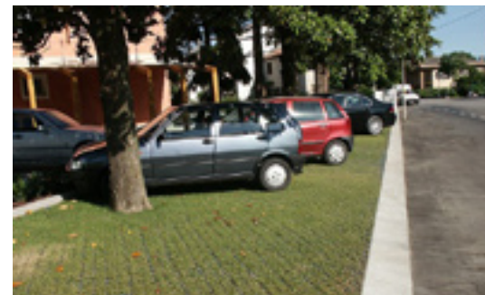
Terrain de stationnement avec un revêtement perméable. France.
