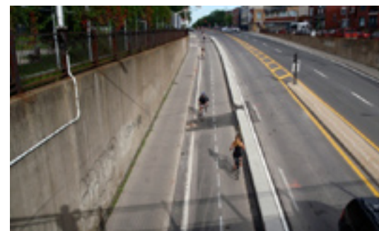
Piste cyclable en site propre sous un viaduc. Avenue Christophe-Colomb, Montréal.
