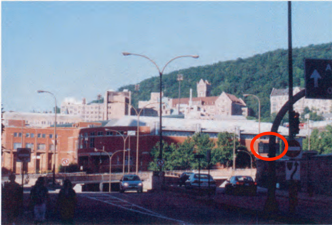
VUE APRÈS GRADINS SUD MODIFIÉS
