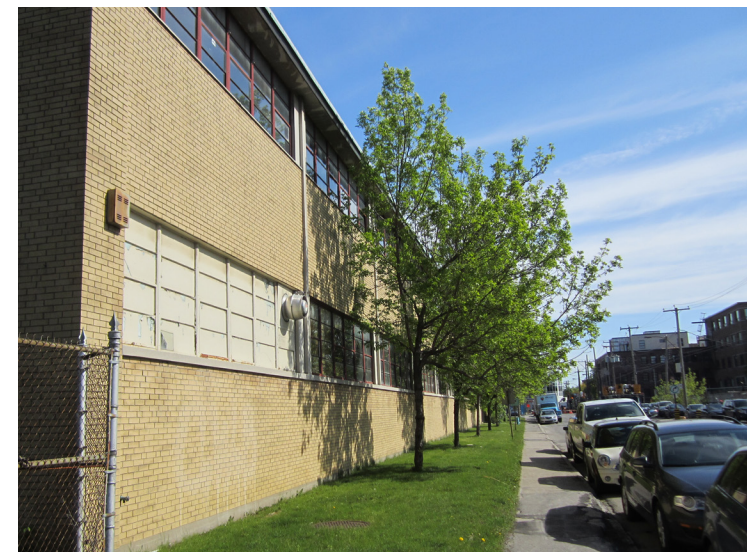
3. FAÇADE AVANT DE L'AILE A - VUE VERS L'EST
