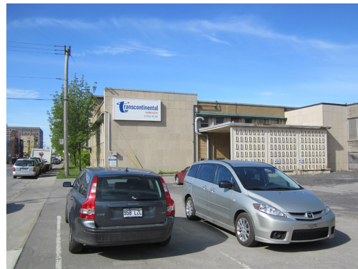
2. ABRI, AIRE DE CHARGEMENT DE L'AILE B - 85, DE CASTELNAU OUEST
