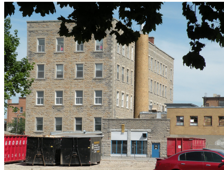
3. FAÇADE ARRIÈRE ET LATÉRALE OUEST, CHEMINÉE | CRÉDIT: I. BOUCHARD
