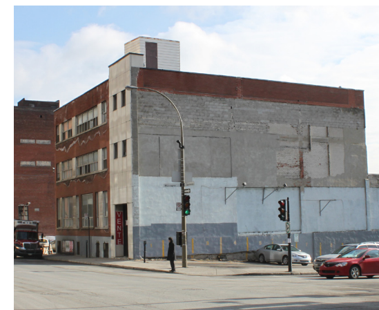
4 1240, RUE SAINT-ANTOINE OUEST
