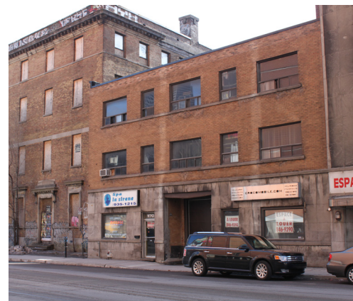
2 1170, RUE SAINT-ANTOINE OUEST
