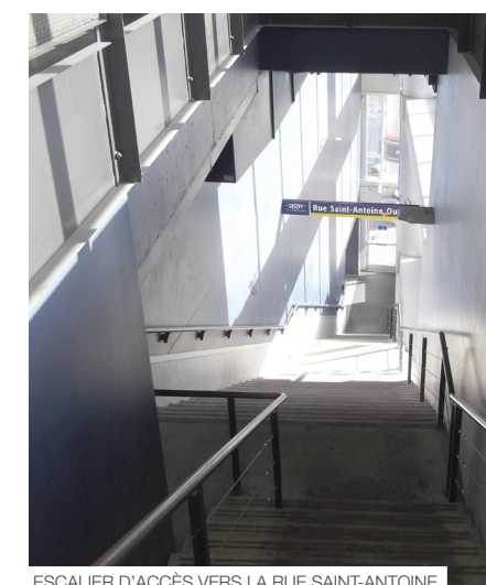
ESCALIER D'ACCÈS VERS LA RUE SAINT-ANTOINE
