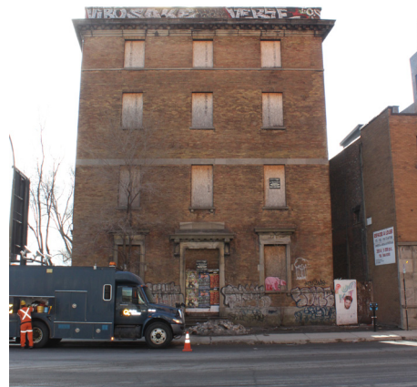
1 1162, RUE SAINT-ANTOINE OUEST
