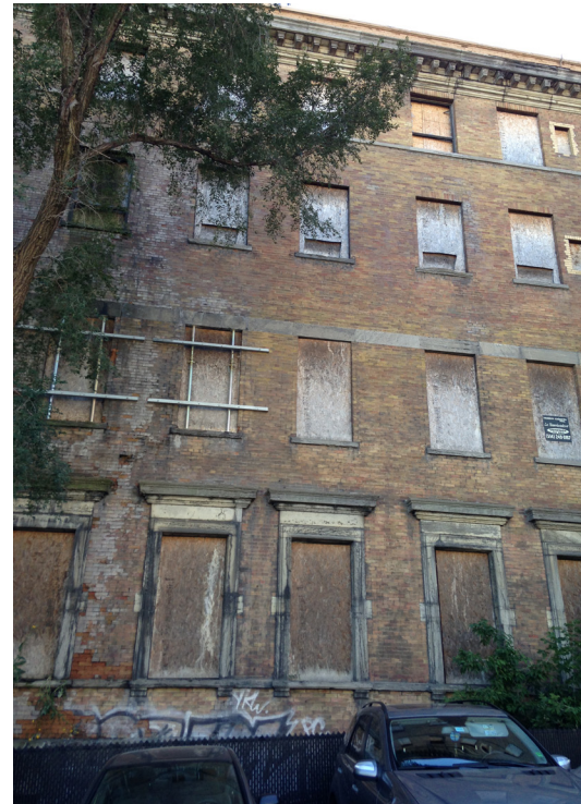
FAÇADE EST (ÉTAT ACTUEL)
