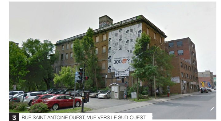
3 RUE SAINT-ANTOINE OUEST, VUE VERS LE SUD-OUEST
