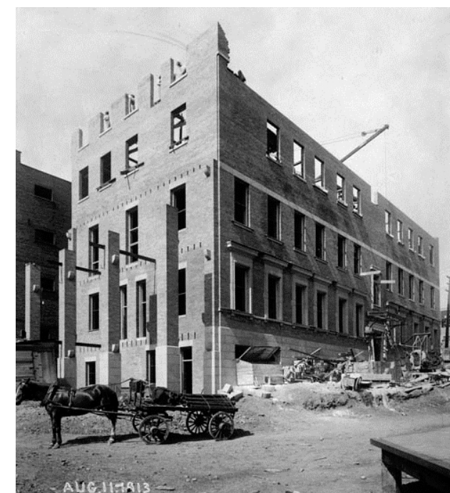
CONSTRUCTION DU BÂTIMENT, 11 AOÛT 1913 | BIBLIOTHÈQUES ET ARCHIVES CANADA
