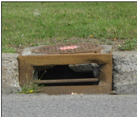
Ouverture d'égout sur le boulevard Tricentenaire, à Pointe-aux-Trembles
