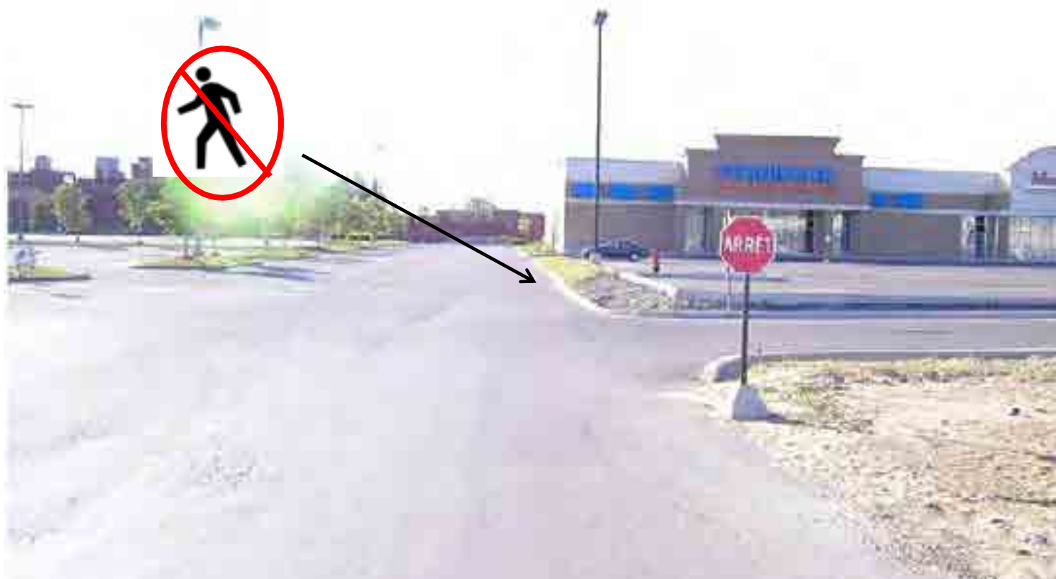
Pole Angrignon 2004 – Absence de trottoirs
