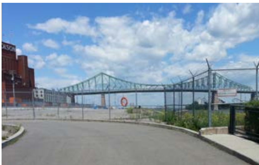
Quais derrière Molson (vue vers l'est)
