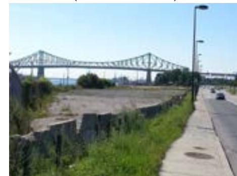
MTQ (m'lasse) (vue vers l'ouest)
