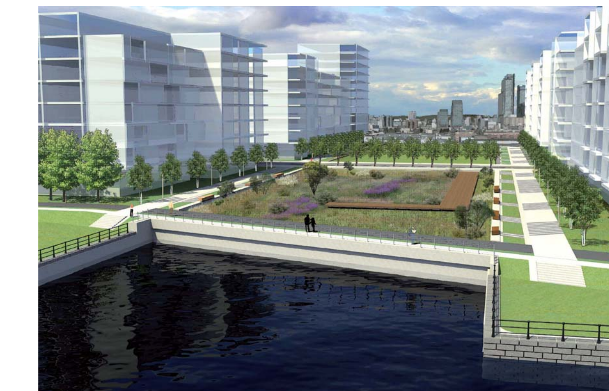
Les Bassins du Nouveau Havre – 2013-2014 Bassin de biorétention qui capte et traite les eaux de ruissellement de la rue Basin. Le fond du bassin est agrémenté de vivaces.
