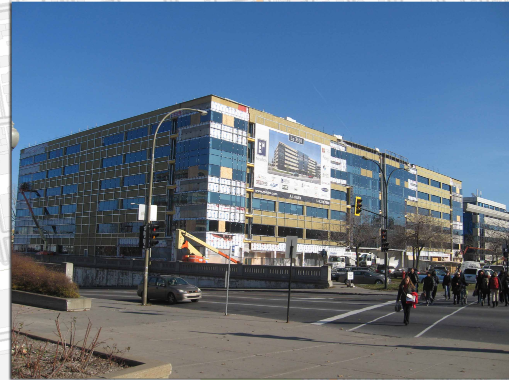
2 - 7101, avenue du Parc
